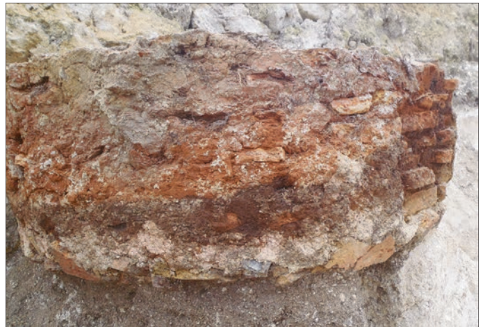
Fig. 3 – Reims, rue Marie-Clémence-Fouriaux : extérieur de la maçonnerie de la chambre de chauffe (avec lutage d'argile) (cliché : G. Cabille).
