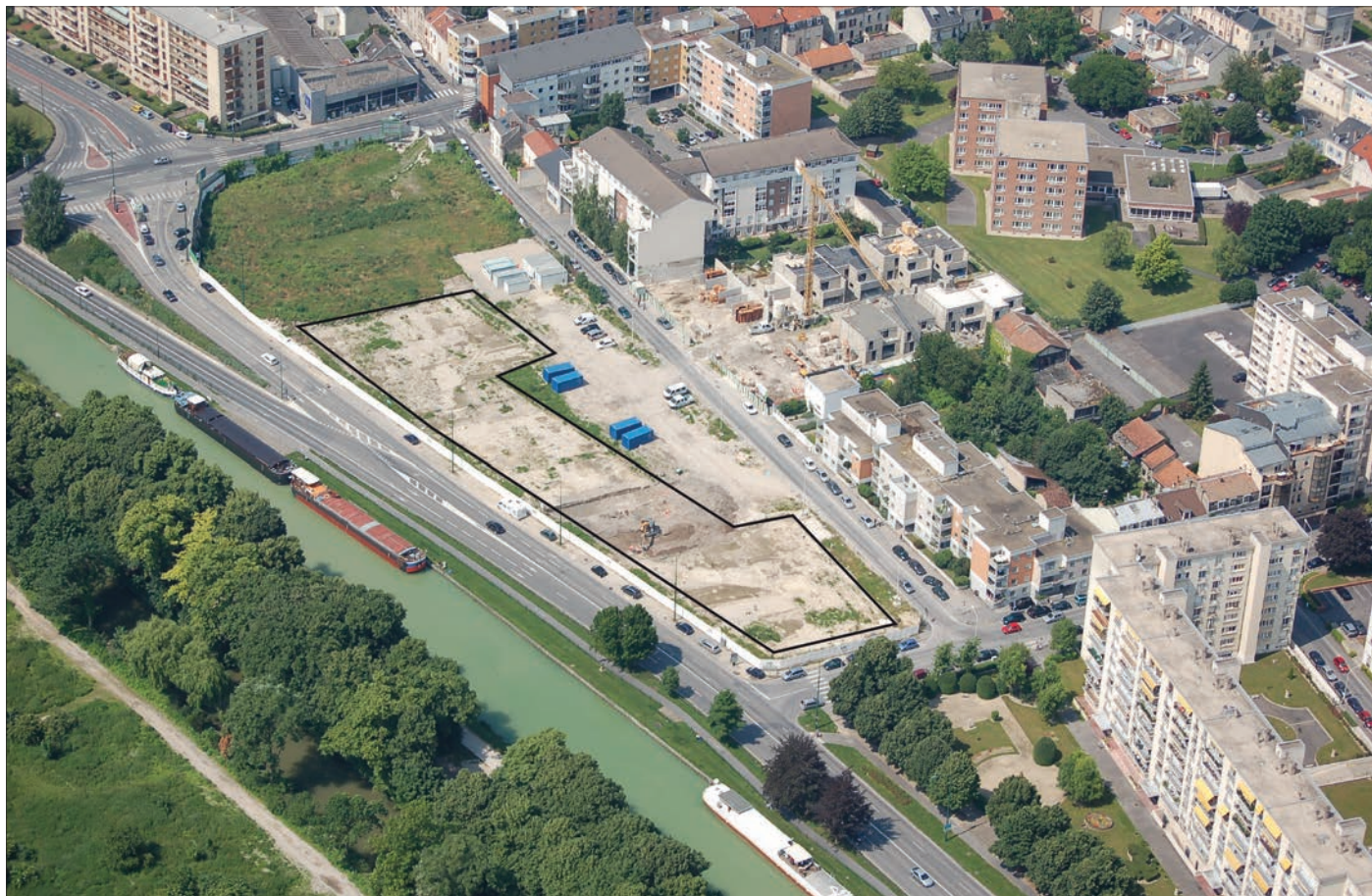
Fig. 2 – Reims, boulevard Dr Henri-Henrot : vue aérienne du site avec, à gauche, le canal de la Marne à l’Aisne, puis la Vesle bordée de végétation arborée (cliché : O. Rigaud, Grand Reims).
