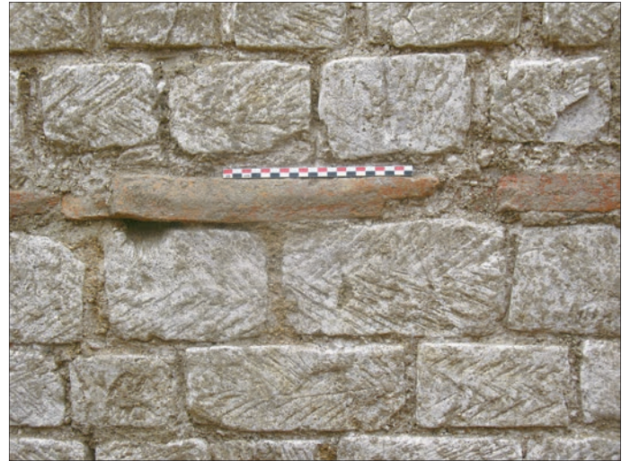
Fig. 16 – Tramway : détail des incisions pratiquées dans les moellons en craie de la cave 138 (cliché : Inrap).
