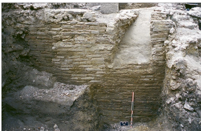
Fig. 25 – Rue Eugène-Desteuque (55) : soupirail dans le mur ouest de la cave 97 (cliché : S. Sindonino, Inrap).
