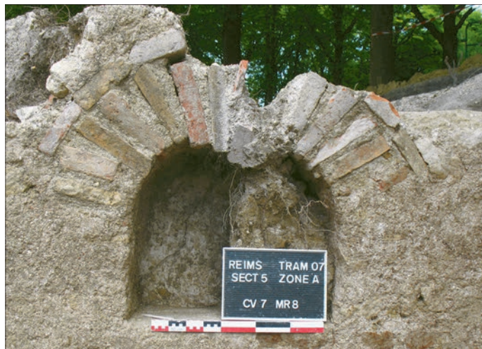
Fig. 20 – Tramway : niche du mur est de la cave 7 (cliché : Inrap).
