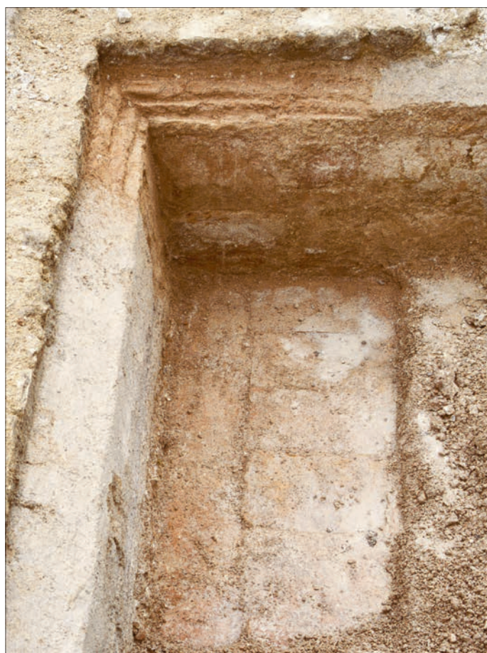
Fig. 21 – 81-85 rue de Venise (73) : fond de la cave pavé d'éléments en terre cuite de type dalles de suspensura et pilettes (cliché : P. Rollet, Inrap).
