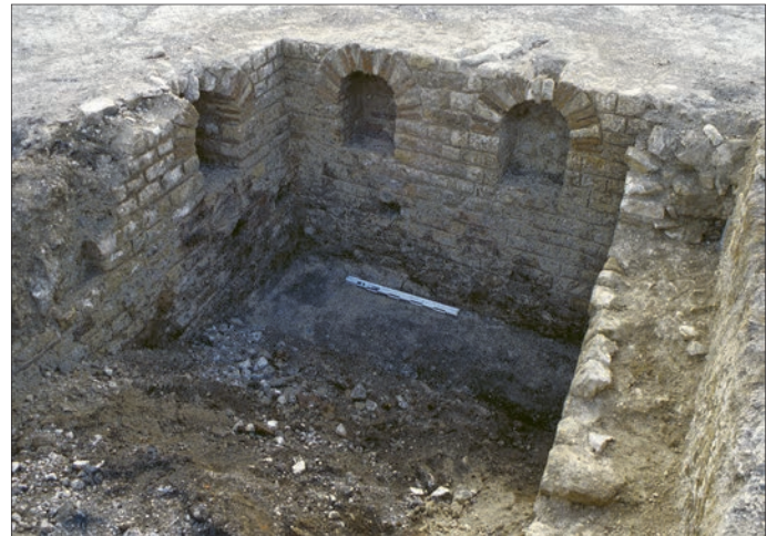
Fig. 17 – 28 boulevard Joffre (15) : vue d'ensemble de la cave 1617 (cliché : A. Balmelle, Inrap).
