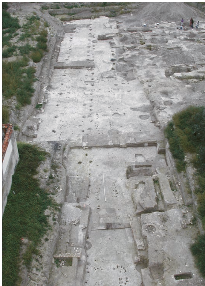
Fig. 11 – Vue aérienne des fondations du bâtiment de stockage découvert rue Maucroix (18) (cliché : P. Rollet, Inrap).
