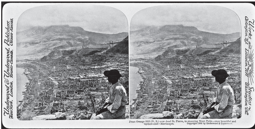
Figura 3. Vista general de Saint-Pierre destruida, desde el monte Orange, 1902, © Boston Public Library
