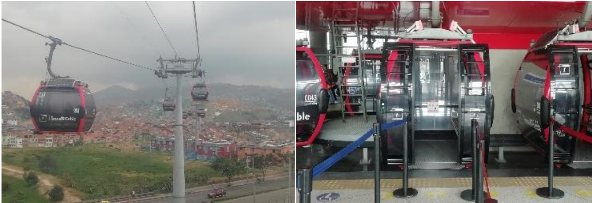
Figure 11 – Transmicable à Ciudad Bolívar. H. Thomas, janvier 2022.
