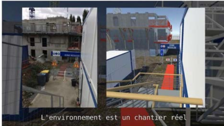
FIG. 2.12 – À gauche le chantier réel et à droite l'environnement virtuel du chantier
