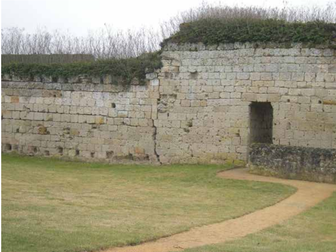
Figure 2. Coucy-Le-Château, Mur de rempart végétalisé côté ouest, 2012, © LRMH
