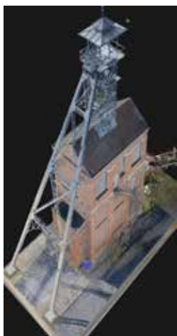
Reconstruction en 3D du chevalement du site de Wallers Arenberg (D)
