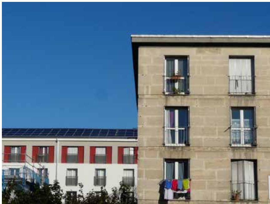
Figure 1. La Montagnette, in La transition énergétique et le bâtiment ancien : Un paradoxe insoluble ? Gerhard Scheller, La Pierre d'Angle , décembre 2016, © Gerhard Scheller.
