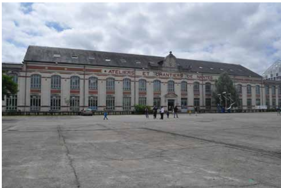
Figure 1. Nantes, La Maison des hommes et des techniques réhabilitée © Varvara Toura, 2019
