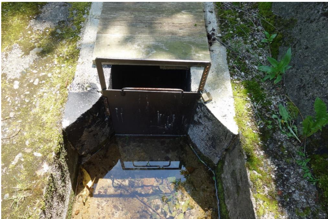
Figure 17. Exemple de martelière crantée. La position est sécurisée à l'aide d'un cadenas (Auteur : Collard, juin 2018)
