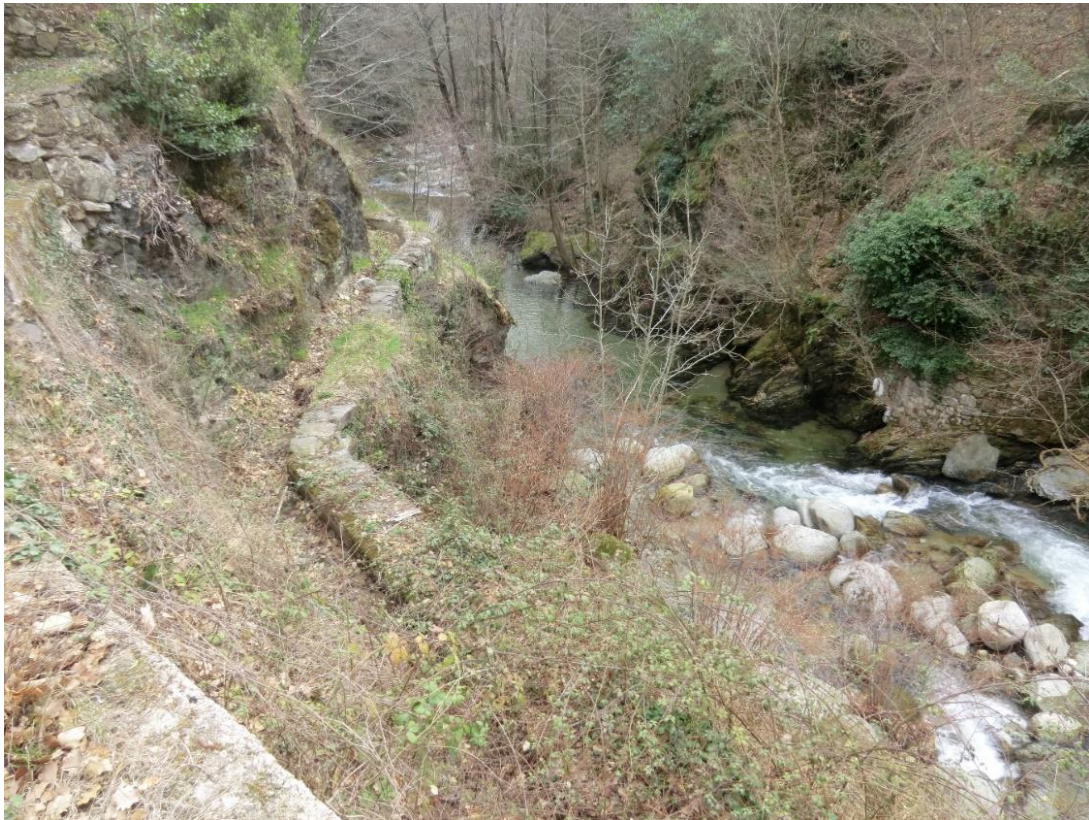
Figure 8. Béal abandonné du Pont du Mas Haut
