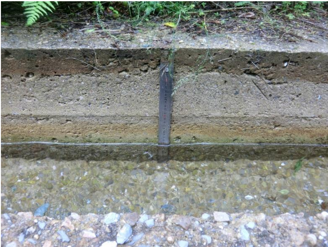
Figure 17. Exemple de martelière crantée. La position est sécurisée à l'aide d'un cadenas (Auteur : Collard, juin 2018)
