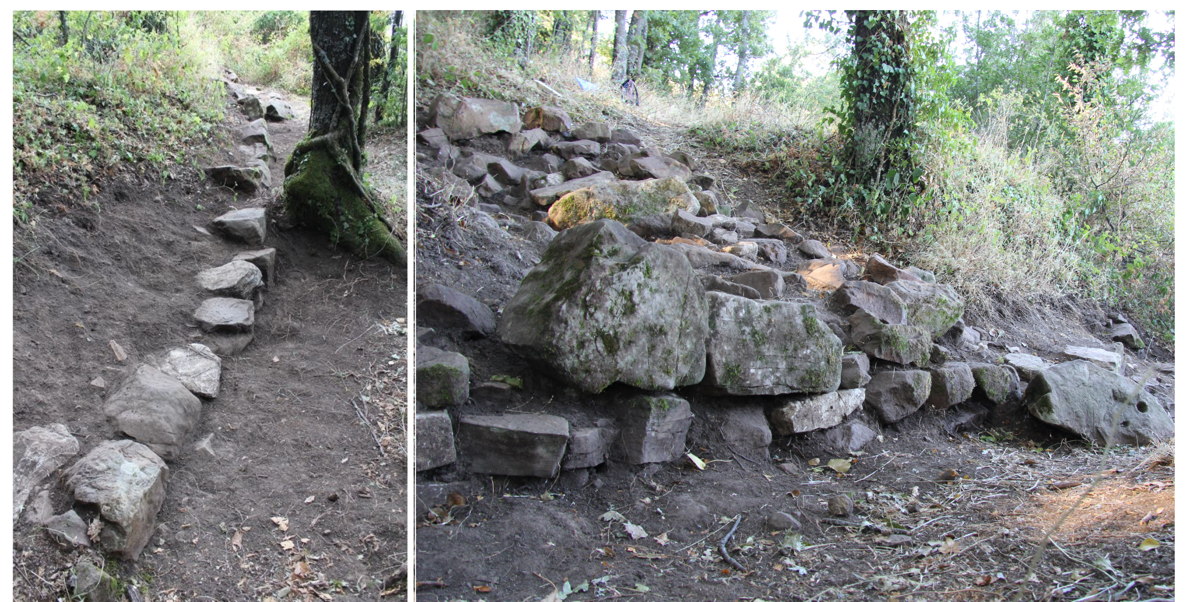
Fig. 4. Muri di terrazzamento sul versante N della c.d. Acropoli
