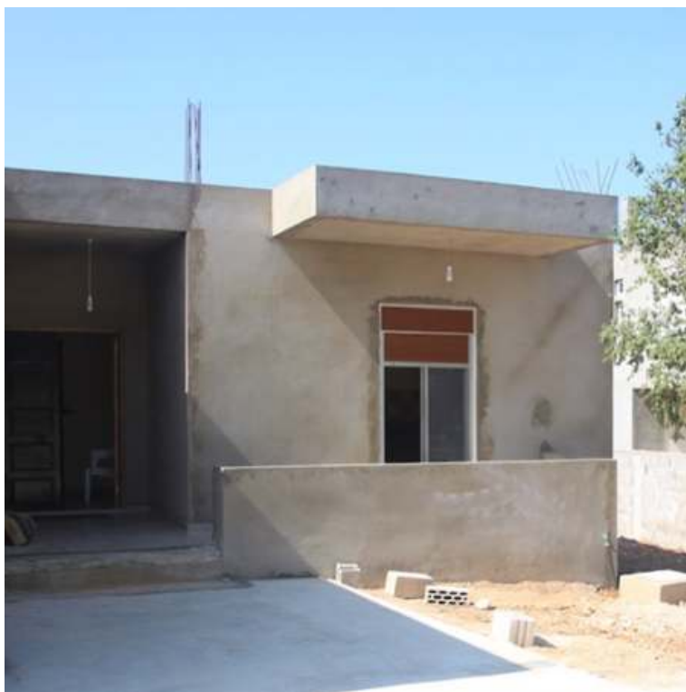
Figure 3 – Hâmât, le village de ma mère. Maison de sa sœur.
