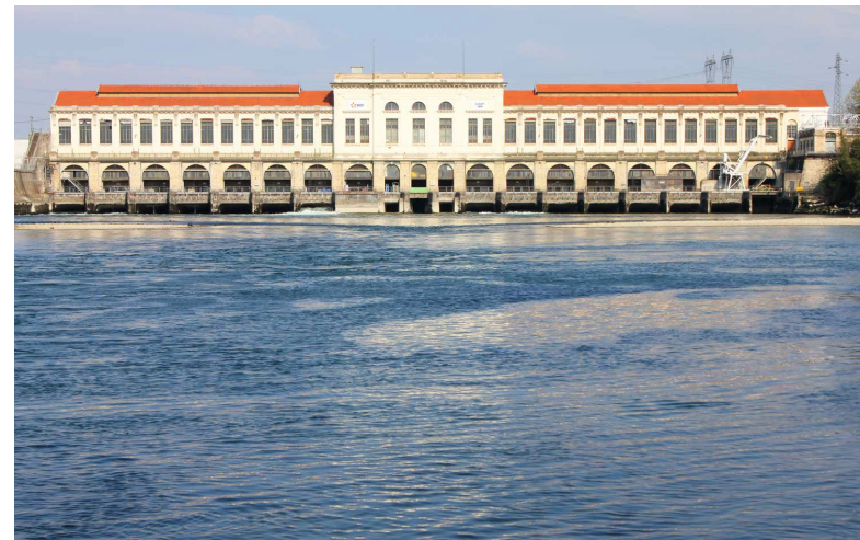
Barrage de Cusset, Villeurbanne
