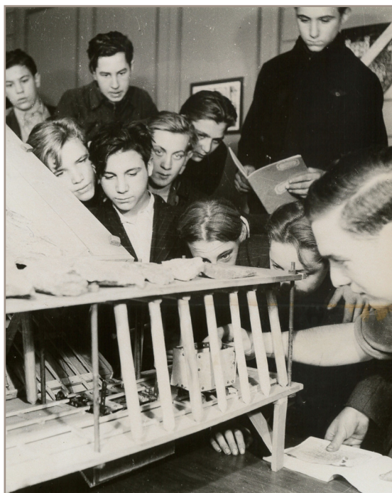
Figure 2 - Exercices en classe de maniement des berlines sur maquette par un moniteur aux apprentis mineurs au Centre d'apprentissage d'Auby (Nord) : photographie noir et blanc, reportage Borge, octobre 1945.
