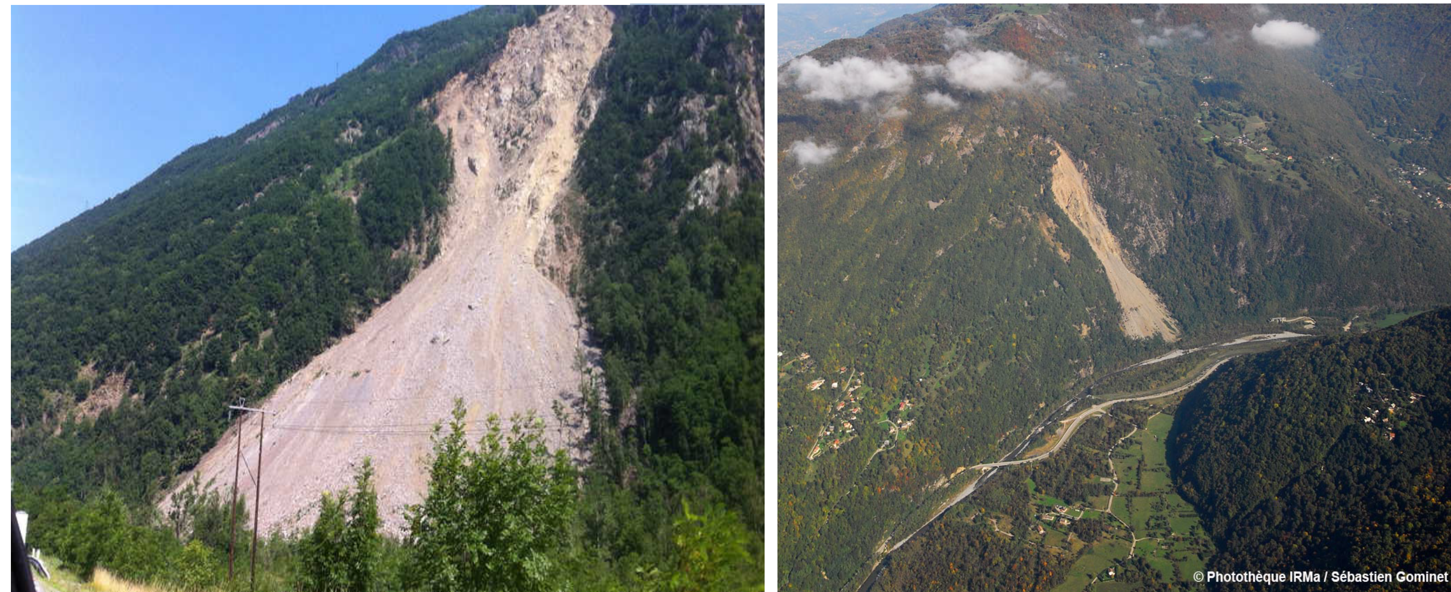
FIG 1 : VIEWS OF THE SÉCHILIENNE LANDSLIDE (PHOTO CREDIT : SÉBASTIEN GOMMET, INSTITUT DES RISQUES MAJEURS)
