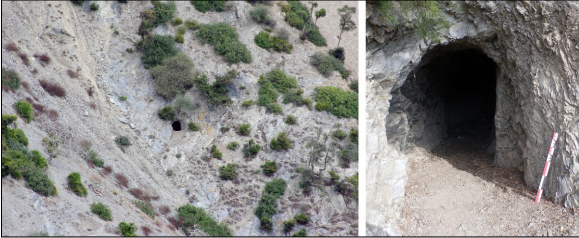
Fig. 34 : vue générale de la mine moderne avec indice d'extraction ancien O-S-M-1. Sur la photo de droite, au second plan, au niveau de l'entrée, la saillie verticale sur la paroi de droite marque le début de la mine moderne qui s'est alignée dans les travaux d'extraction plus ancien.
