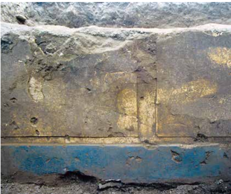
Fig. 7 : Arpi. La domus dite de « la mosaïque des lions et des panthères ». Détail d'un mur en bauge avec revêtement en style structural (Photo Archives SABAP Foggia).
