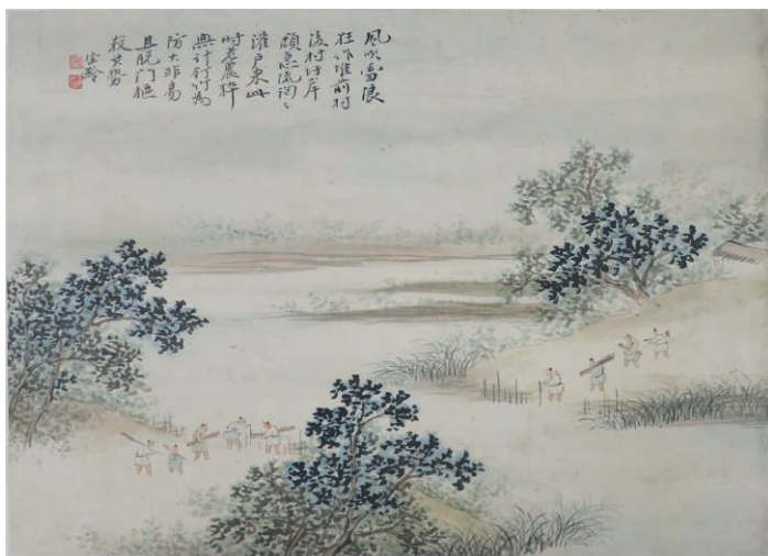
486 — Fig. 11. Jiang Baoling, « En construisant des digues » (Zhuba), Collection de peintures sur l'inondation, feuille n° 3
