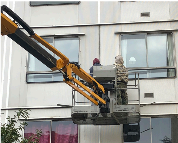
Dépose des couvre-joints rapportés Mathilde Padilla, 2019
