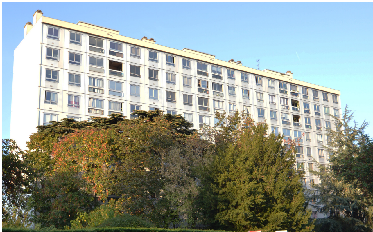
L'immeuble les Cèdres depuis la rue de la Favorite © Mathilde Padilla, 2018
