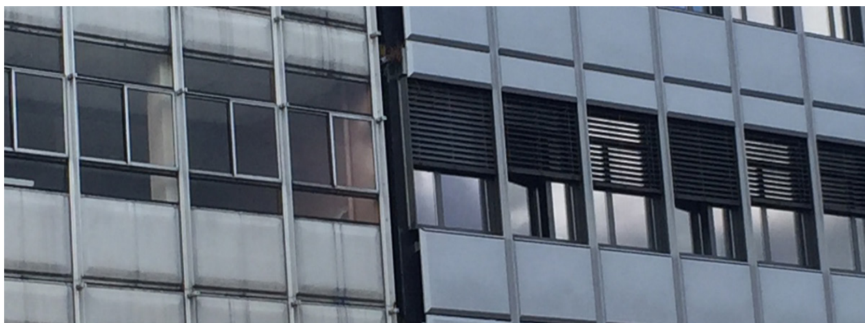
Façade d'un immeuble du Campus de la Doua en cours de chantier. Façade-rideau d'origine / Nouvelle façade-rideau Cl. Mathilde Padilla, 2018
