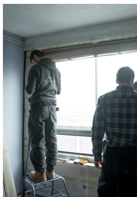
Pose de la première couche d'isolant et du frein vapeur © Mathilde Padilla, 25 janvier 2020
