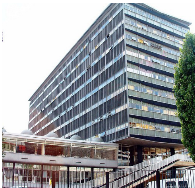
Paris, Caisse centrale des allocations familiales, avant intervention Cl. Jacques Mossot, 2005, © Structurae
