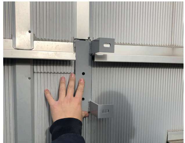
Pose des pattes de fixation dans les joints entre panneaux Mathilde Padilla, 2019
