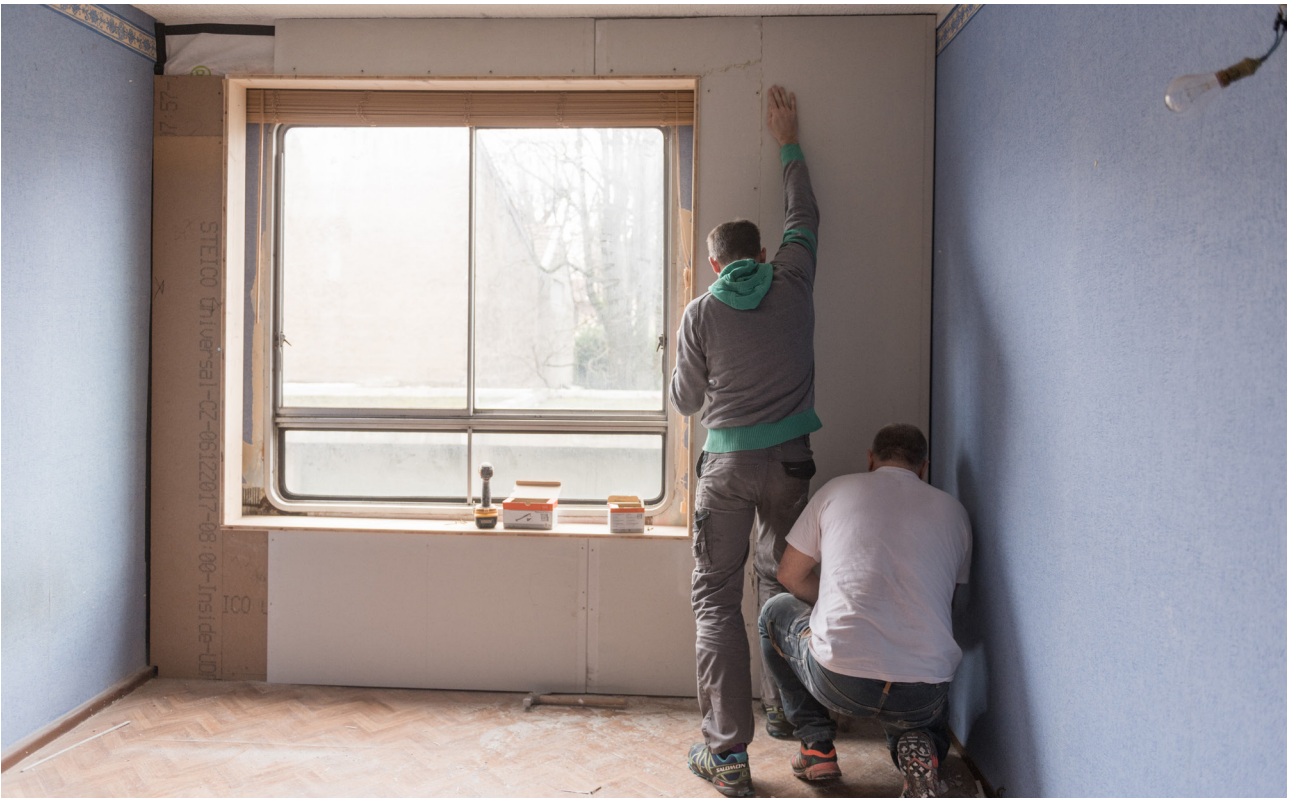
L'entreprise Fermacell en action sur le prototype 2 Cl. Sabine Serrad, 28 janvier 2020
