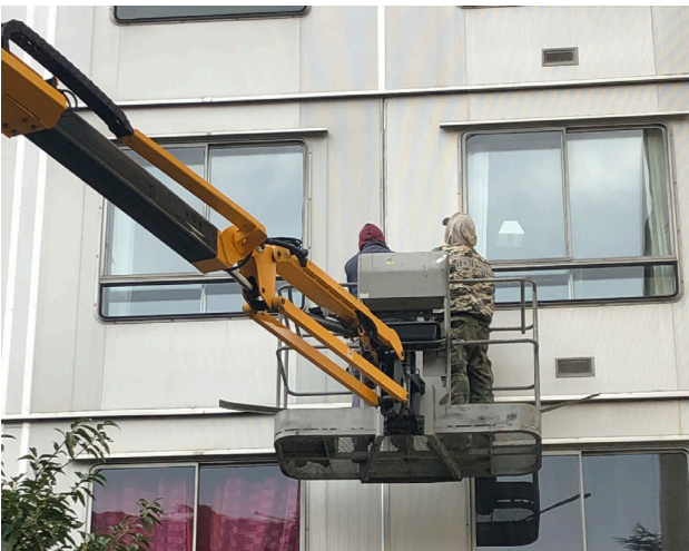
Dépose des couvre-joints rapportés Mathilde Padilla, 2019
