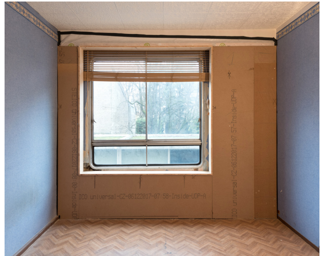
Photo de la loge après pose du prototype 2 (avant pose du Fermacell) Cl. Sabine Serrad, 25 janvier 2020
