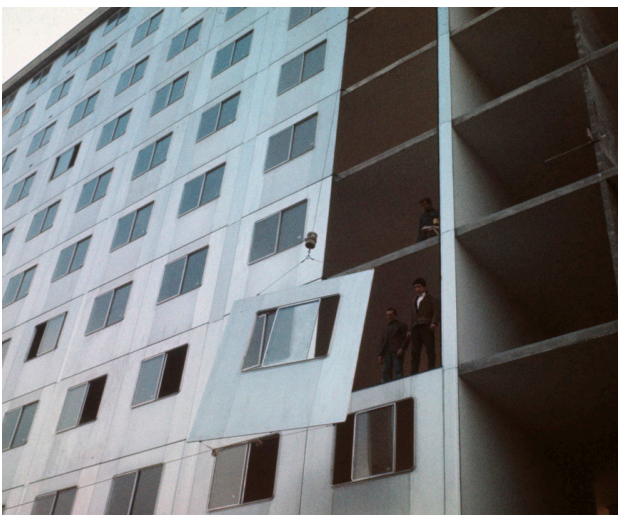
Le chantier des Cèdres, façade nord © Centre Pompidou/MNAM-CCI/Bibliothèque Kandinsky
