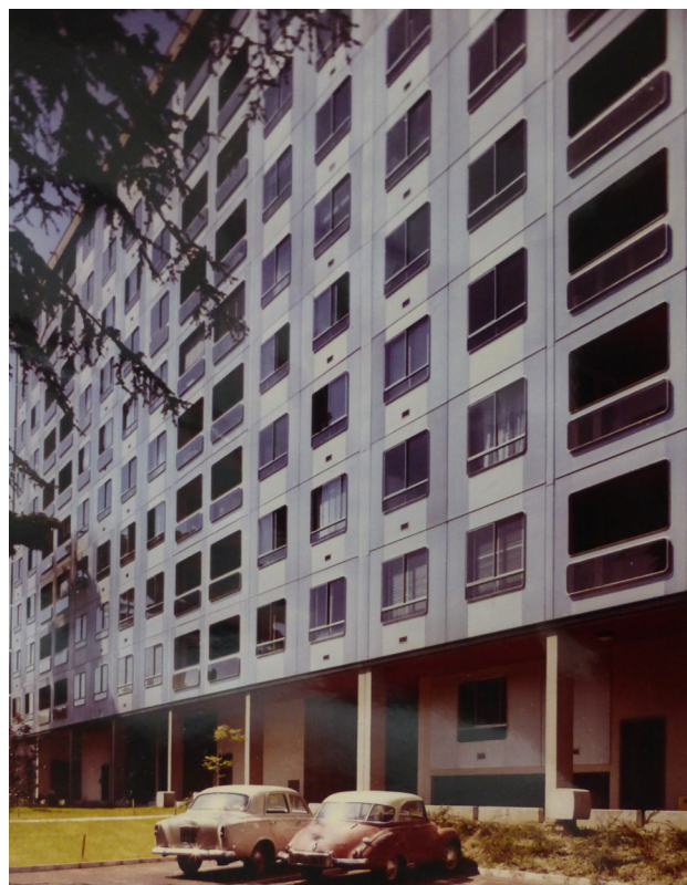
Immeuble les Cèdres à sa construction, côté rue © SAAL, fond 14B François-Régis Cottin
