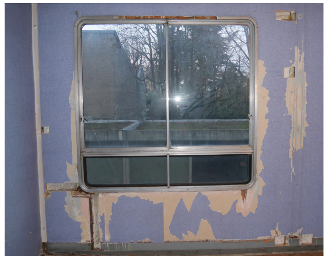
Ensemble des percements réalisés sur le panneau lors des travaux d'observation
