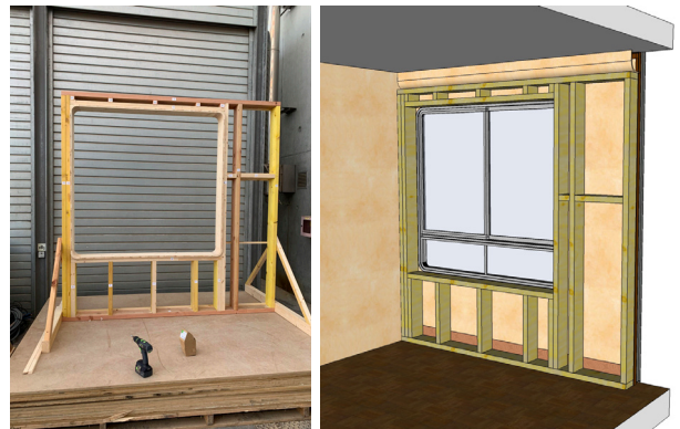
Ossature du prototype 1 © Eddy Giroux, Compagnons du Devoir, novembre 2019
