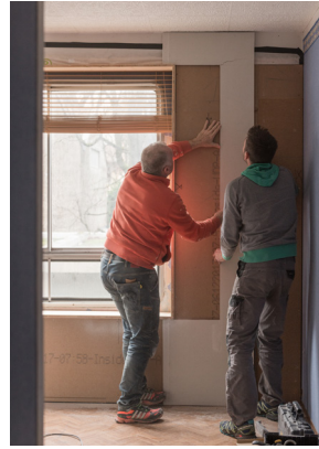
Pose du Fermacell sur le prototype 2 © Mathilde Padilla, 25 janvier 2020
