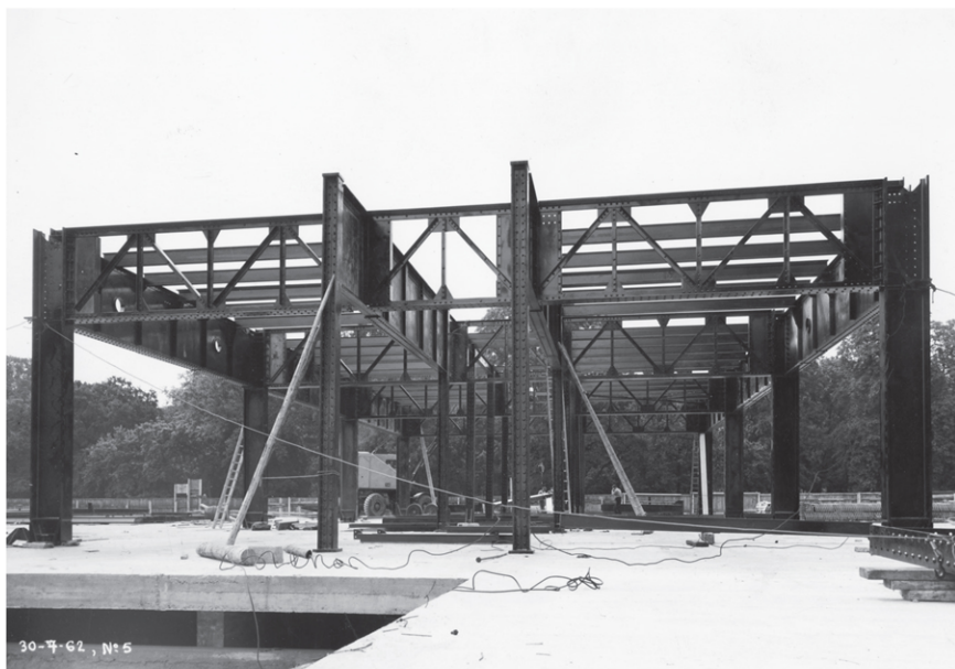
LA STRUCTURE DU MUSÉE DES ATELIERS, EN COURS DE CONSTRUCTION EN 1962. ©CAPA.
