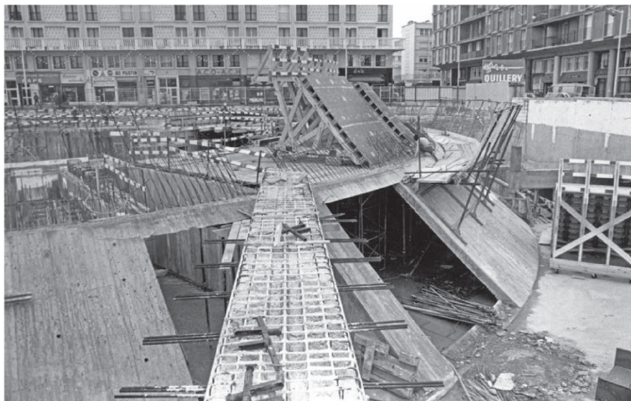
Le chantier de la Maison de la culture du Havre. Détail de la construction du petit Volcan montrant la technique de ferrailage adoptée pour sa réalisation. Photo attribuée à Daniel Fondimare, non datée, vers 1980. Archives Jean-Maur Lyonnet.
