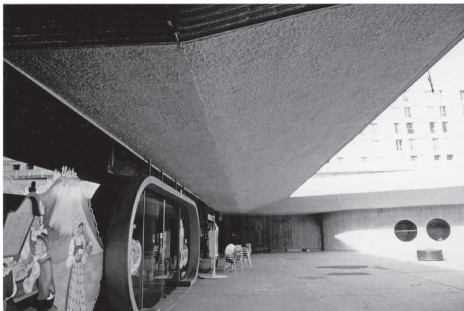
Détail de l'espace public bas de la Maison de la culture, avec l'entrée d'un bar-restaurant. L'angle de cet espace public accueille aujourd'hui l'entrée de la bibliothèque Oscar-Niemeyer ouverte en novembre 2015. Celui-ci est visible sur l'image montrant Jean-Maur Lyonnet en conversation avec des étudiantes et des étudiants de l'ENSA Normandie. Photo Jean-Maur Lyonnet, non datée, années 1980. Archives Jean-Maur Lyonnet.
