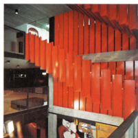
8. Pas d'escalier d'honneur. Les deux niveaux du hall sont reliés par un escalier droit, large, vigoureusement dessiné. Des lames de verre trempé soigneusement une main courante en chêne massif au profil sculpté par Maria Pan.
