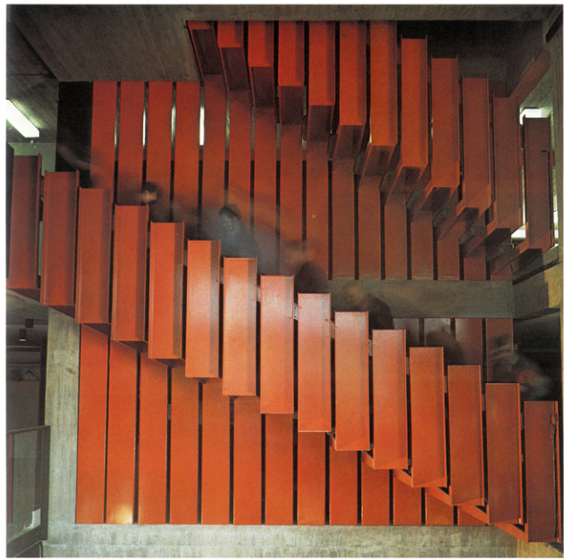
14. L'escalier rouge est formé de poutres d'acier caudées. Tous les détails ont été étudiés avec une même netteté de forme, de matière, de couleur. L'architecture donne l'exemple de la clarté et de la vigueur.
