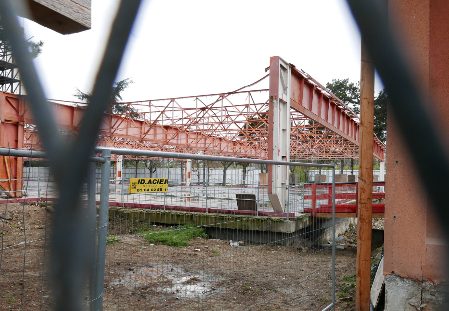
La structure à nue du MNATP le 11 février 2019 (clichés XD)
