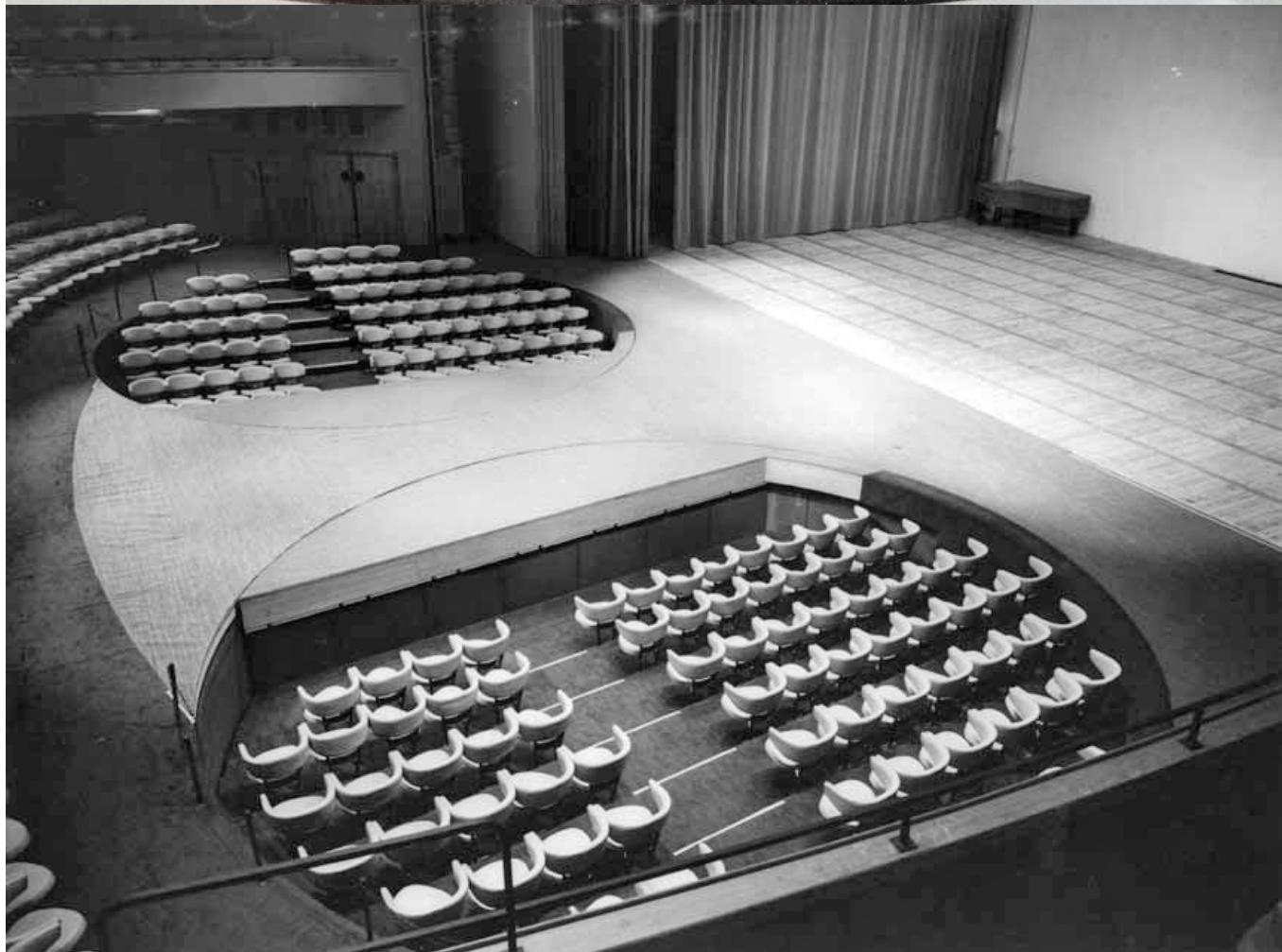
**Le dispositif mobile du proscenium pendant le chantier et après achèvement de la salle**
