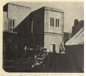
FIG. 20. — Maisons d'habitation en béton armé restées debout au milieu d'un quartier entièrement détruit.
