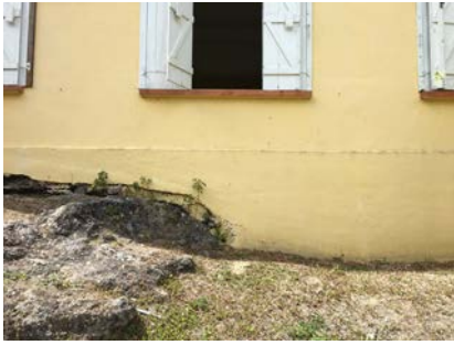
Façade arrière de l'école des filles des Grands-Fonds du Moule. Le socle de la construction en maçonnerie de moellons de calcaire repose directement sur le massif affleurant en sommet de morne.
