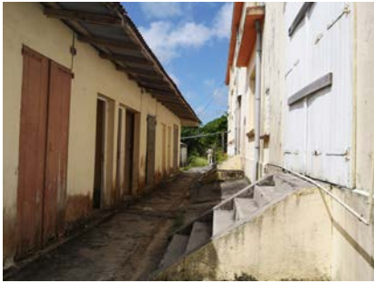
Béton de l'arrière de l'école des garçons des Grands-Fonds.
