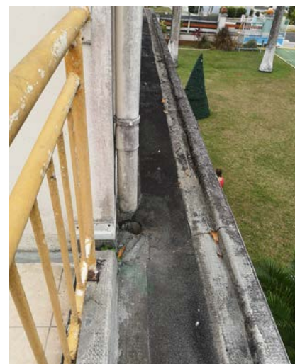
Largeur des chéneaux du groupe scolaire du Lamentin
