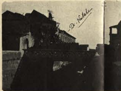
FIG. 19. — Pont sur le torrent Portalegui. La première maison derrière en construction ordinaire est détruite. Plus loin, les moulins de Natale en béton armé sont restés debout.
