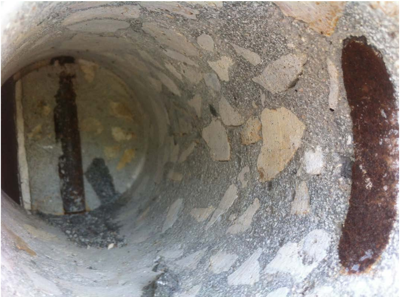
Carottage dans l'un des bétons de l'église de Morne-à-l'Eau
