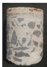
Eprouvette : Carotte de la dalle de toiture de l'Ecole Saint Geneviève de l'école de Petit Canal.
