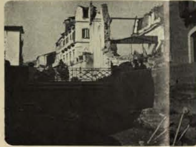
FIG. 16. — Couverture du torrent Portalegui (vue de face).
