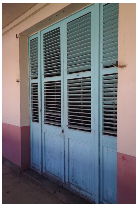
Baies en jalousies de la galerie du groupe scolaire de Morne-à-l'Eau
