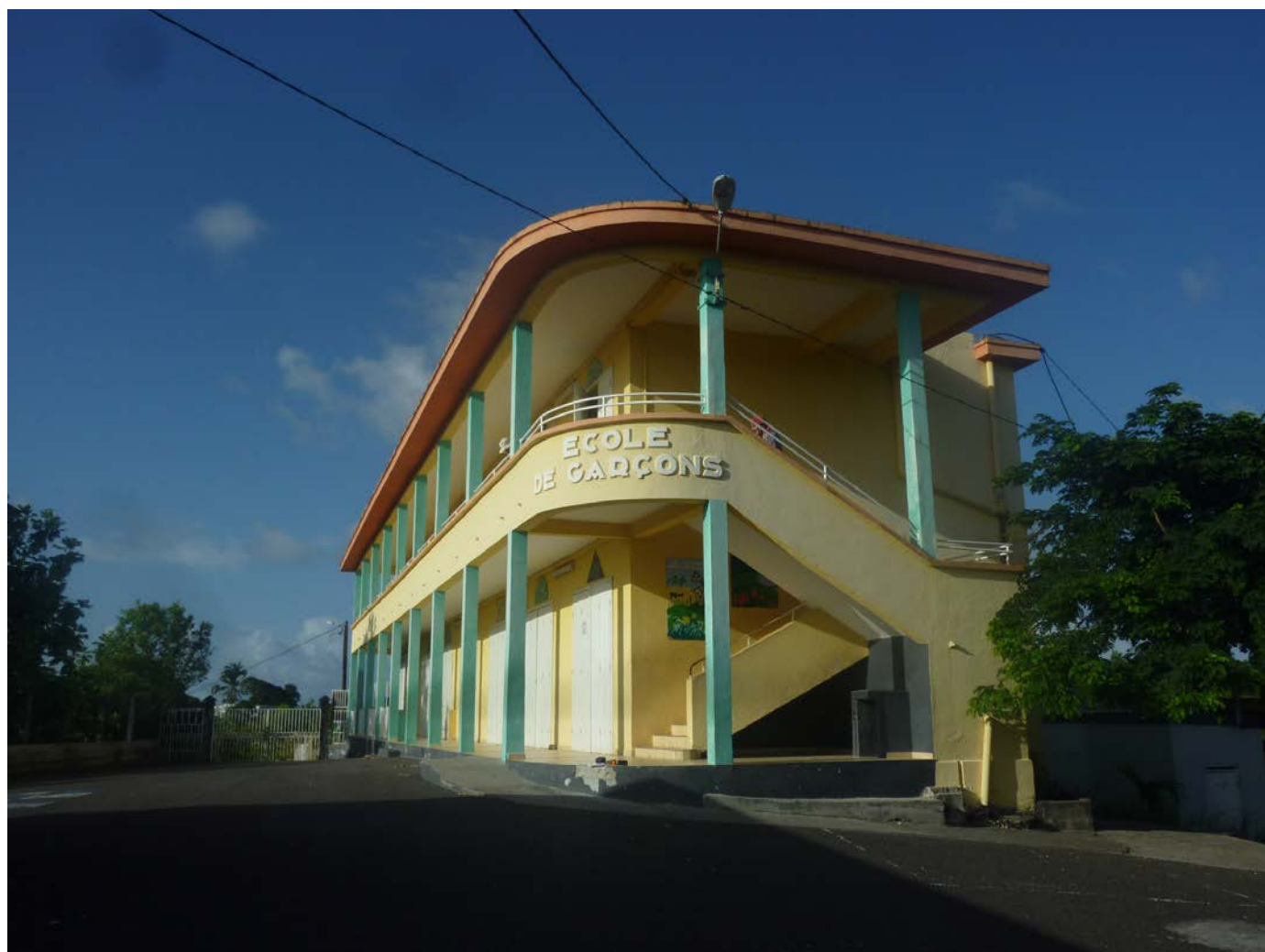
Escalier et galerie en façade sud-ouest de l'école des garçons des Grands-Fonds du Moule
