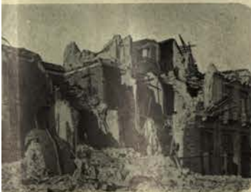
Corroboré les observations précédentes. Confirme qu'il ne s'agit pas de secousses provoquant la mise en mouvement des superstructures, mais non des déplacements du sol sous les fondations.
