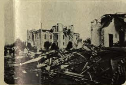
FIG. 10. — Destruction complète d'une construction mixte fer et maçonnerie.
