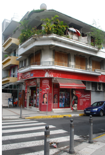
Immeuble de logements de Gérard-Michel Corbin et Gilbert Amarias, à l'angle des rues Schoelcher et Chanzy à Pointe-à-Pitre pouvant être mis en conformité sismique à partir de la méthode élaborée dans le cadre de cette recherche
