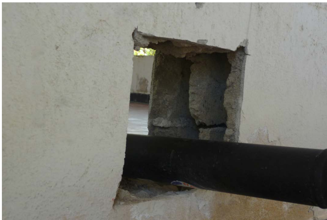
Percement des parois donnant à voir les blocs d'agglomérés de sable.
