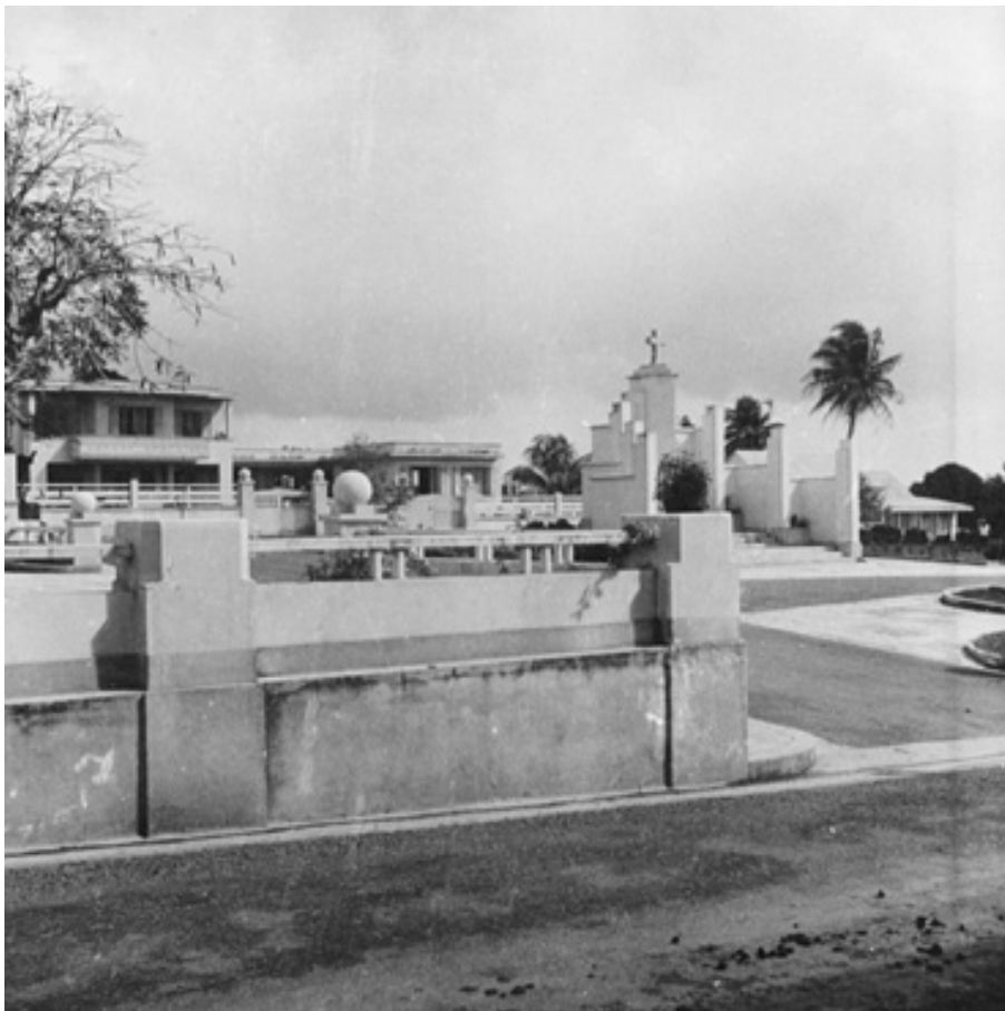
Groupe scolaire du Lamentin vu depuis le square, photographie de Lucien Gauthier© DAC Guadeloupe
