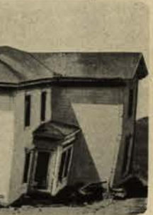
en bois, ce qui montre l'infériorité des parties de la construction.
