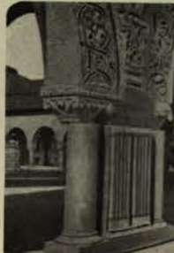
FIG. 8. — Effet particulier montrant l'action de l'inertie de la façade produite par la faute de liaison entre les étages.
