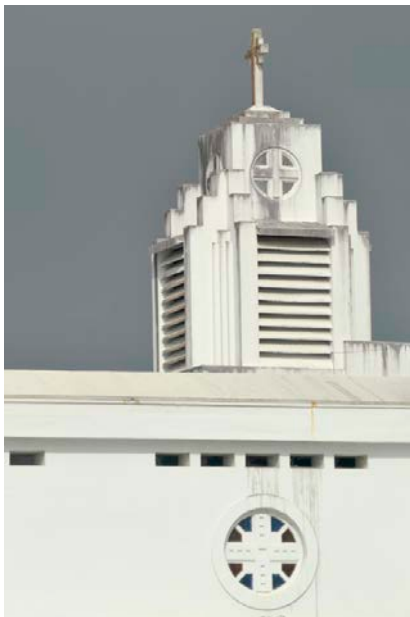
Clocher de l'église du Lamentin, classée MH en 2017, photographies de Charles Chulem Rousseau© DAC Guadeloupe et Charles Chulem Rousseau
