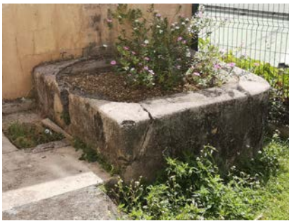
Récolte des eaux de pluies de l'école des garçons des Grands-Fonds du Moule
