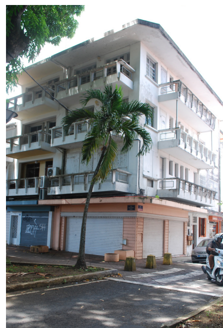
Immeuble de logements de Gérard-Michel Corbin et Gilbert Amarias, place de la Victoire à Pointe-à-Pitre
