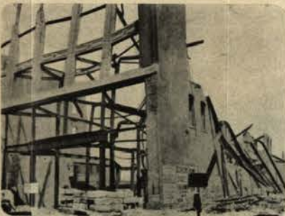
FIG. 15. — Effet du séisme et du feu sur une charpente métallique.
