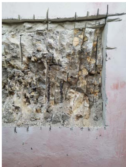
Bétons de site du soubassement sur rue du groupe scolaire de Morne-à-l'Eau
