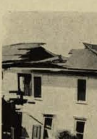
FIG. 11. — Brisure des constructions montrant la faiblesse de liaison entre les étages.
