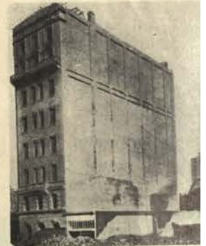
FIG. 21. — San Francisco. Hôtel des télégraphes et télégraphes des États du Pacifique. Ossature, planchers, pontons en béton armé. Remplissage en briques.
