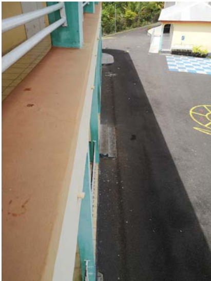
Enrobé de la cour des Grands-Fonds, devant l'école des garçons
