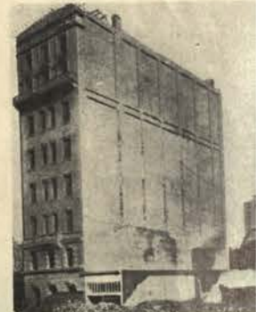
FIG. 21. — San Francisco. Hôtel des télégraphes et télégraphes des États du Pacifique. Ossature, planchers, pontons en béton armé. Remplissage en briques.
