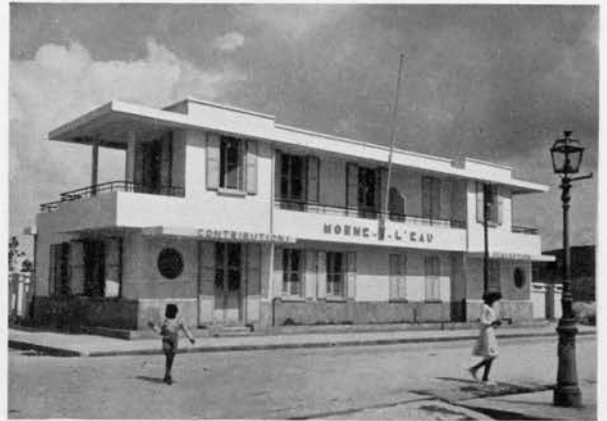
Fig. 143. — Bureau de Contributions-perception à Morne-à-l'Eau (Guadeloupe). — Architecte : Ali Tur.
