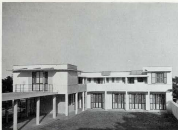
Fig. 138. — Groupe scolaire à Port-Louis (Guadeloupe). — Architecte : Ali Tur. — Façade sur cour.
