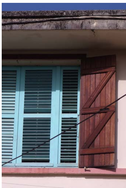
Débord de dalle et jalousies du groupe scolaire de Morne-à-l'Eau
