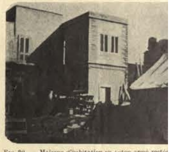
FIG. 20. — Maisons d'habitation en béton armé restées debout au milieu d'un quartier entièrement détruit.
