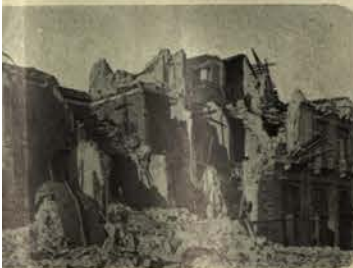
Corroboré les observations précédentes. Confirme qu'il ne s'agit pas de secousses provoquant la mise en mouvement des superstructures, mais non des déplacements du sol sous les fondations.
