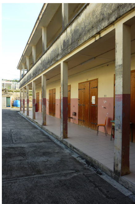
Béton de la cour actuelle du groupe scolaire de Morne-à-l'Eau
