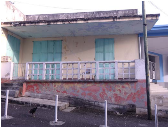
Logement des enseignants sur la ruelle Ézélie Sermanson
