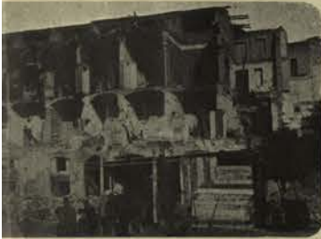
Construction ouverte sous une secousse modérée. Lustres, etc., meubles restés en place. La façade a pivoté au niveau supérieur du premier étage. Façade du rez-de-chaussée restée en place. Les fondations n'ont pas bougé.
