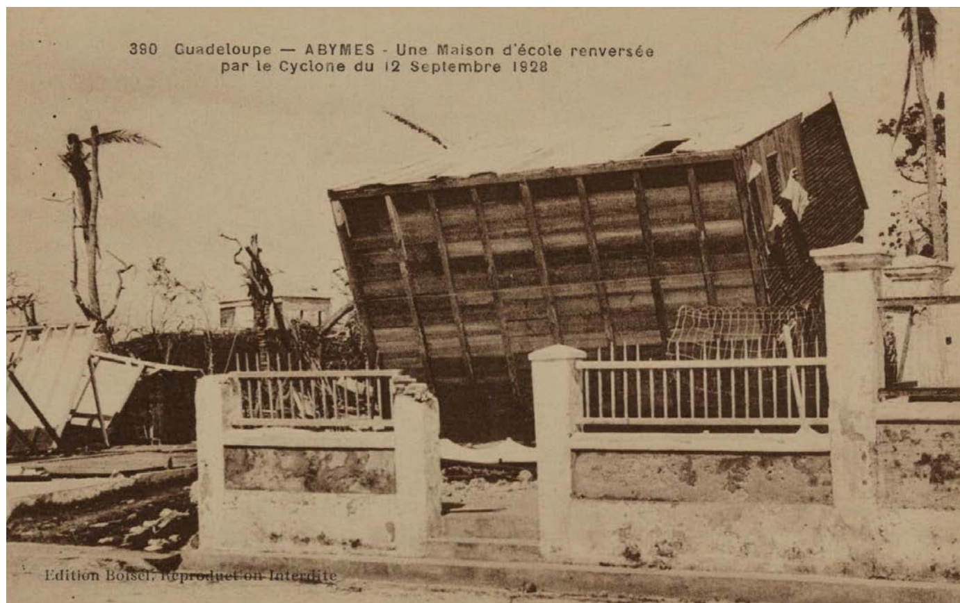
Maison d'école aux Abymes, renversée par le cyclone du 12 septembre 1928© éd. Boisel, ADG
