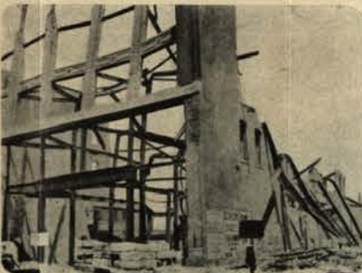
FIG. 15. — Effet du séisme et du feu sur une charpente métallique.
