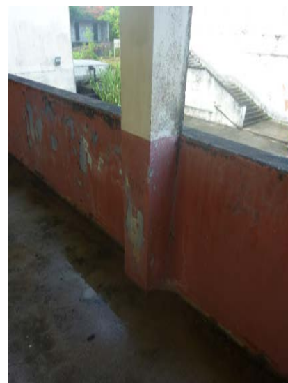
Pilier de la galerie du groupe scolaire de Morne-à-l'Eau
