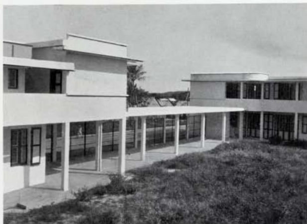
Fig. 139. — Groupe scolaire à Port-Louis (Guadeloupe). — Architecte : Ali Tur. — Façade sur cour.
