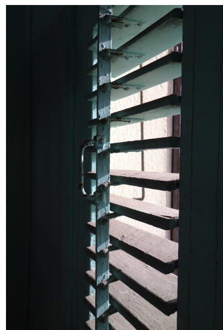
Contrôle du volume d'air et de l'intensité lumineuse par la manipulation des jalousies
