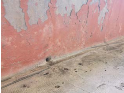
Rigole en pied des garde-corps maçonnés, en connexion avec les barbacanes de la galerie supérieure du groupe scolaire de Morne-à-l'Eau
