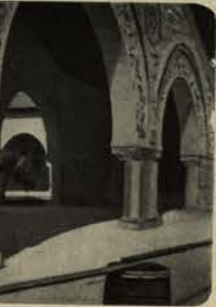
entraînant le déplacement des colonnes et la masse supérieure : déplacement des éléments de la construction.
