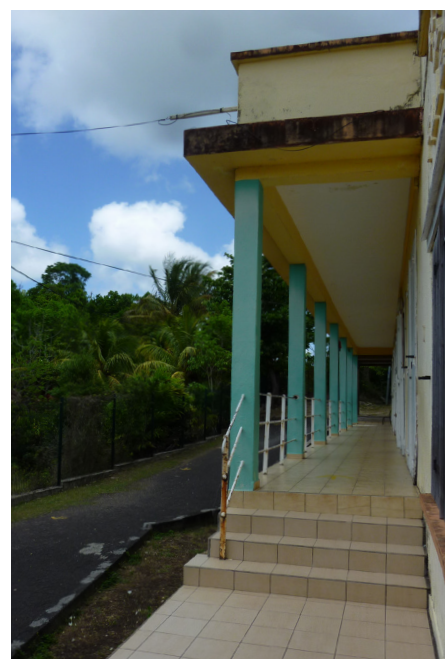
Plates-bandes résiduelles de l'école des filles des Grands-Fonds du Moule
