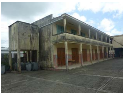
Citerne du groupe scolaire de Morne-à-l'Eau
