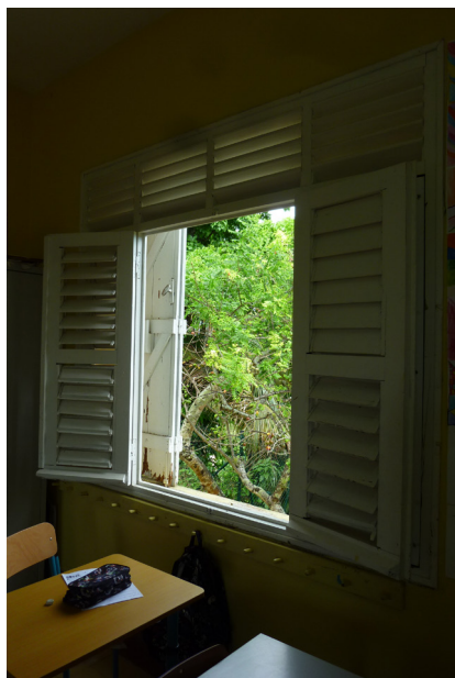
Fenêtre avec jalousies ouvrant sur le morne
