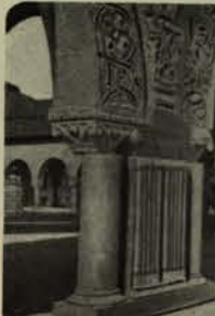
FIG. 8. — Effet particulier montrant l'action de l'inertie due à la rupture de liaison entre les étages.
