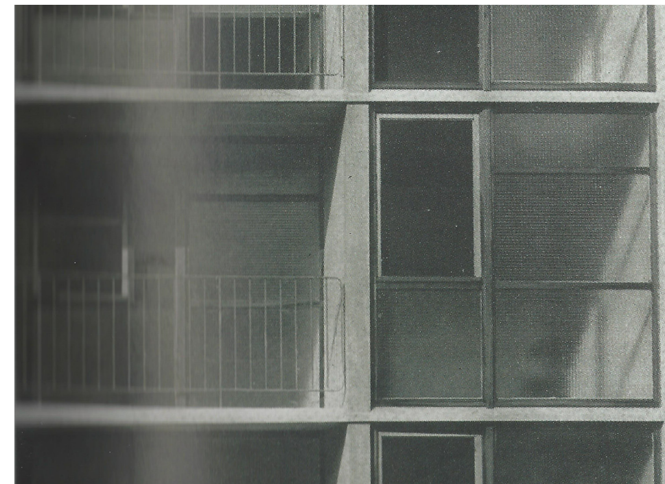
Figure 15 : Firminy-Vert, photographie des panneaux de façade avant installation de l'isolant.
