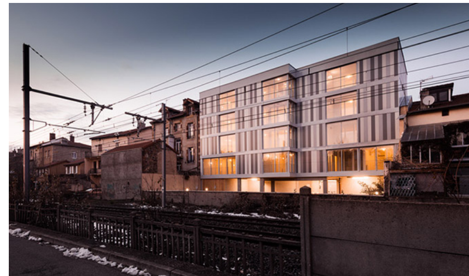
Figure 13 : Réalisation récente de l'OPH Firminy, rue de la république.
