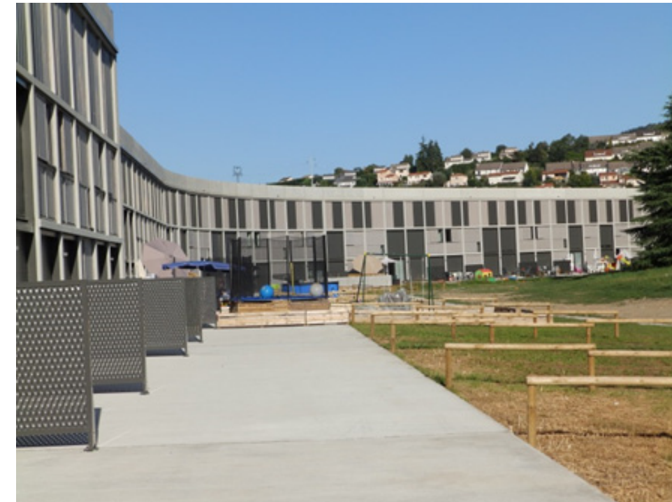
Figure 5 : La Corniche rénovée.
