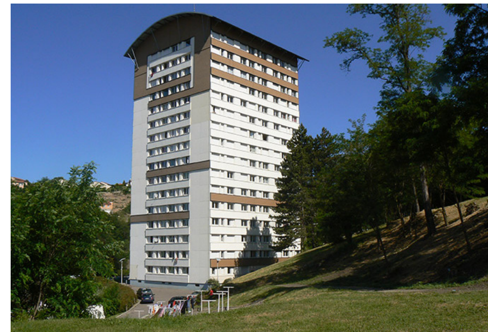
Figure 5 : Tour de l'ensemble de logement Layat.
