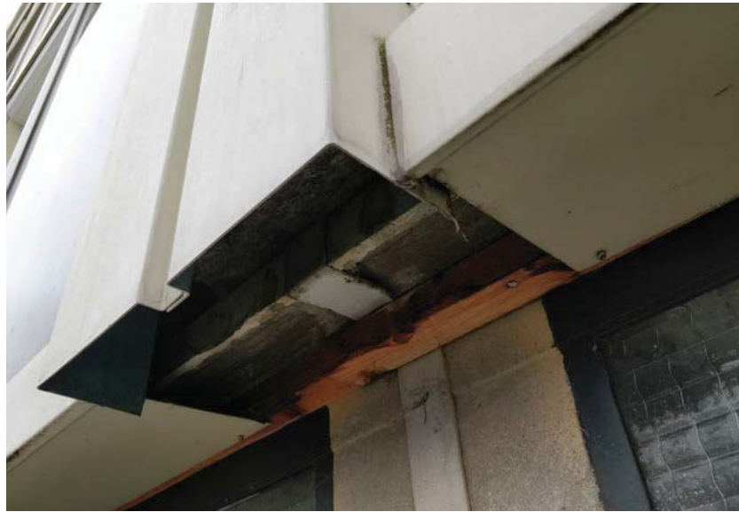
Figure 14 : Détail du capotage en façade | Barre « Peupliers ».
