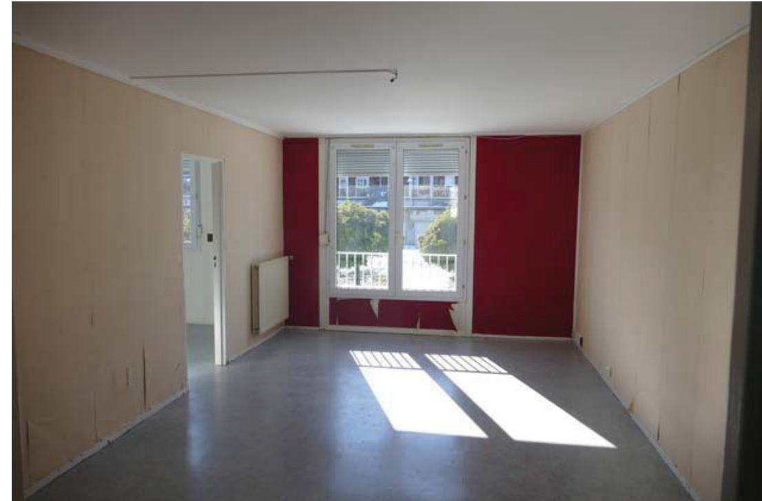
Figure 7 : Façade intérieure séjour | Barre « Peupliers » Cadre bois d'origine (Panneau type A) et intégration menuiserie PVC après réhabilitation.
