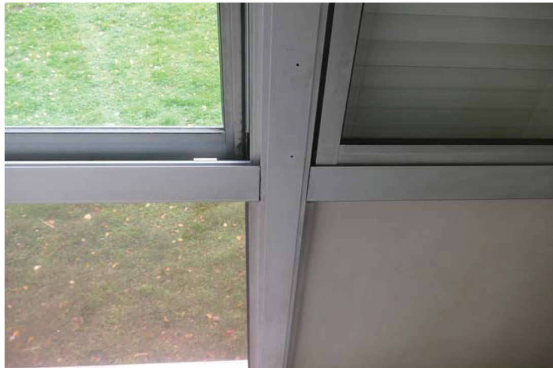
Figure 5 : Détail menuiserie extérieure loggia | Panneau d'origine (1989).
