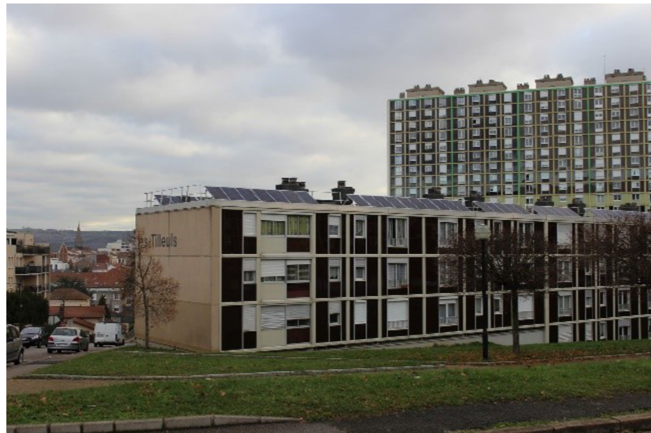
Figure 19 : Photo de l'immeuble « les Tilleuls » après sa rénovation en 1989.
