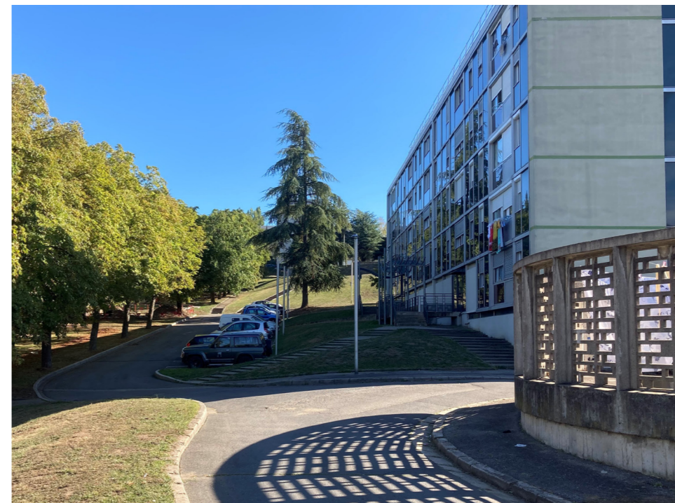
Figures 25 et 26 : En haut, séchoir, Immeuble A (droite), C (gauche) et pignon de l'immeuble D dit « Chicago » au début des années 60. En bas, le même point de vue aujourd'hui, après démolition de deux tiers du Chicago.
