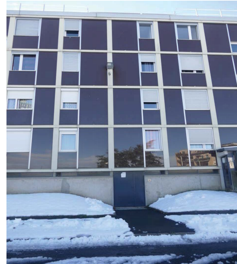
Figure 12 : Façade nord | Barre « Peupliers ».
