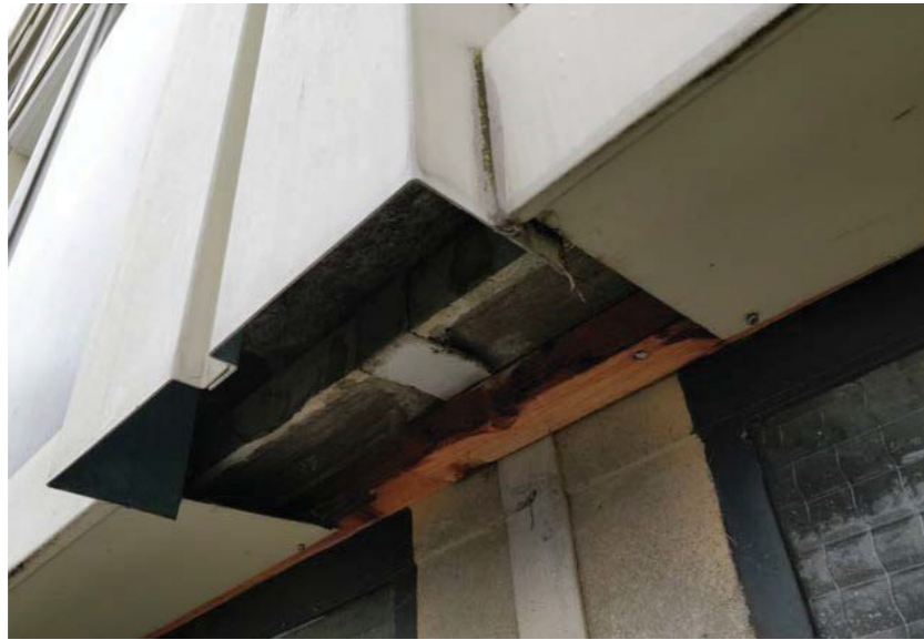
Figure 14 : Détail du capotage en façade | Barre « Peupliers ».
