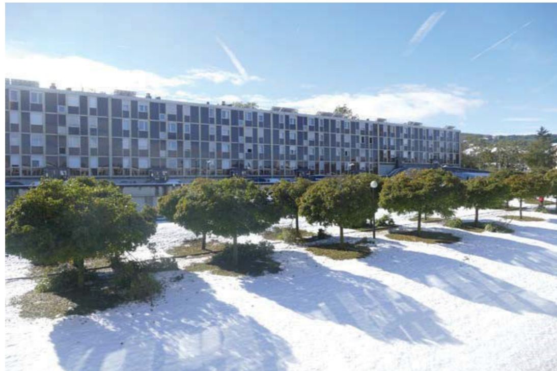
Figure 11 : Façade Nord | Barre « Peupliers ».
