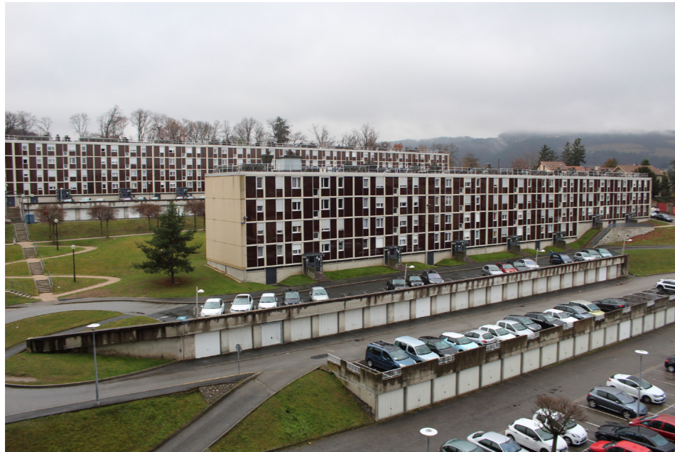
Figure 10 : Immeubles de Firminy-Vert réhabilités.
