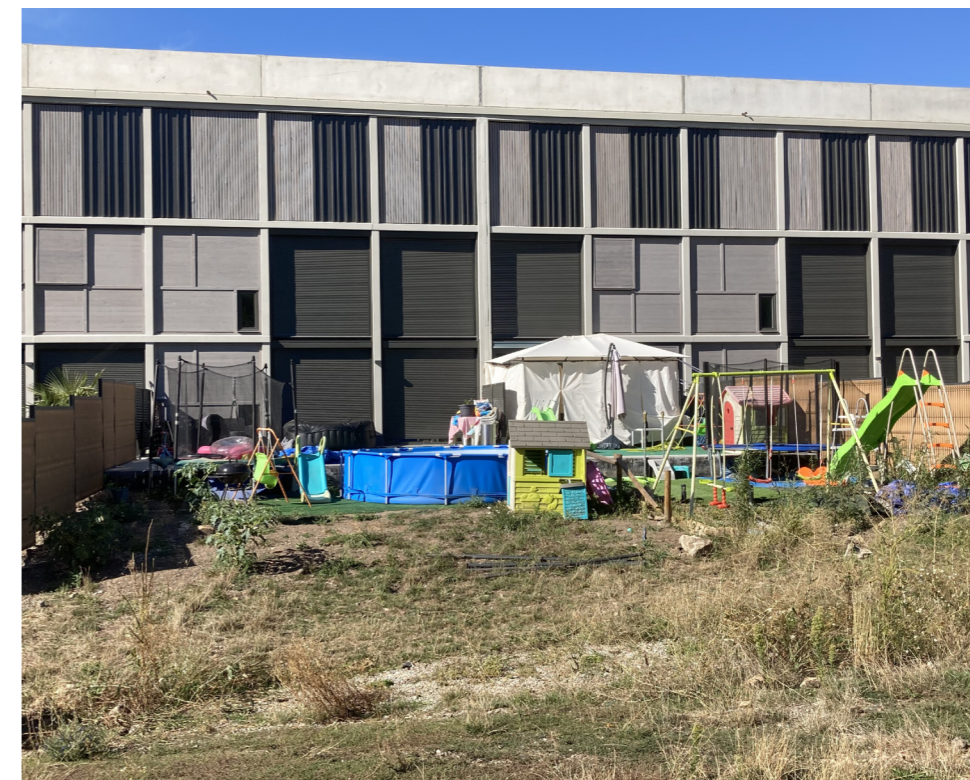
Figures 20 et 21 : La Corniche, été 2020 : un an après réalisation, occupations et appropriations des espaces en pied d'immeuble (façade sud). En l'absence de limites, interdites par une prescription de l'Avap, on tente de contenir les occupations de ces espaces non-maîtrisés, par des éléments mobiliers insuffisants et aux effets très douteux en matière de paysage et de patrimoine... Par ailleurs les grandes baies vitrées surexposées au sud sont évidemment toutes occultées.
