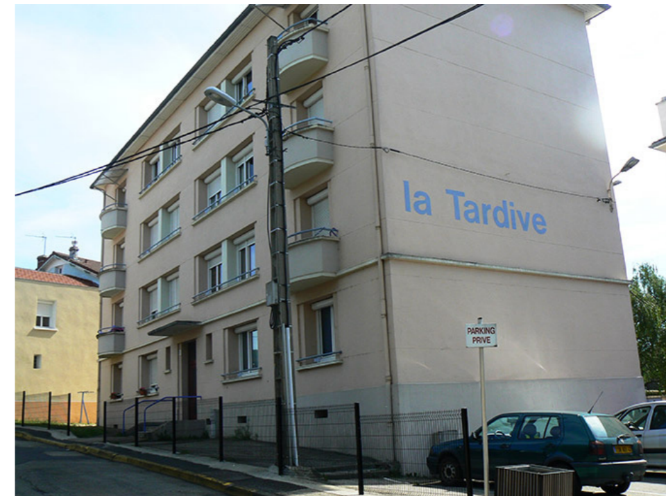
Figure 2 : Logements de la Tardive. Trois immeubles de trois étages et un rez-de-chaussée.
