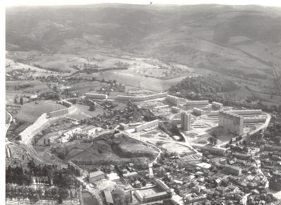
Figure 8 : Vue aérienne du chantier d'exécution du quartier de Firminy-Vert ; Ito Josué.
