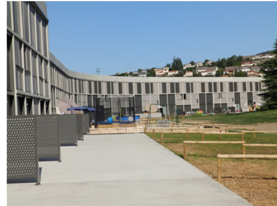
Figure 5 : La Corniche rénovée.
