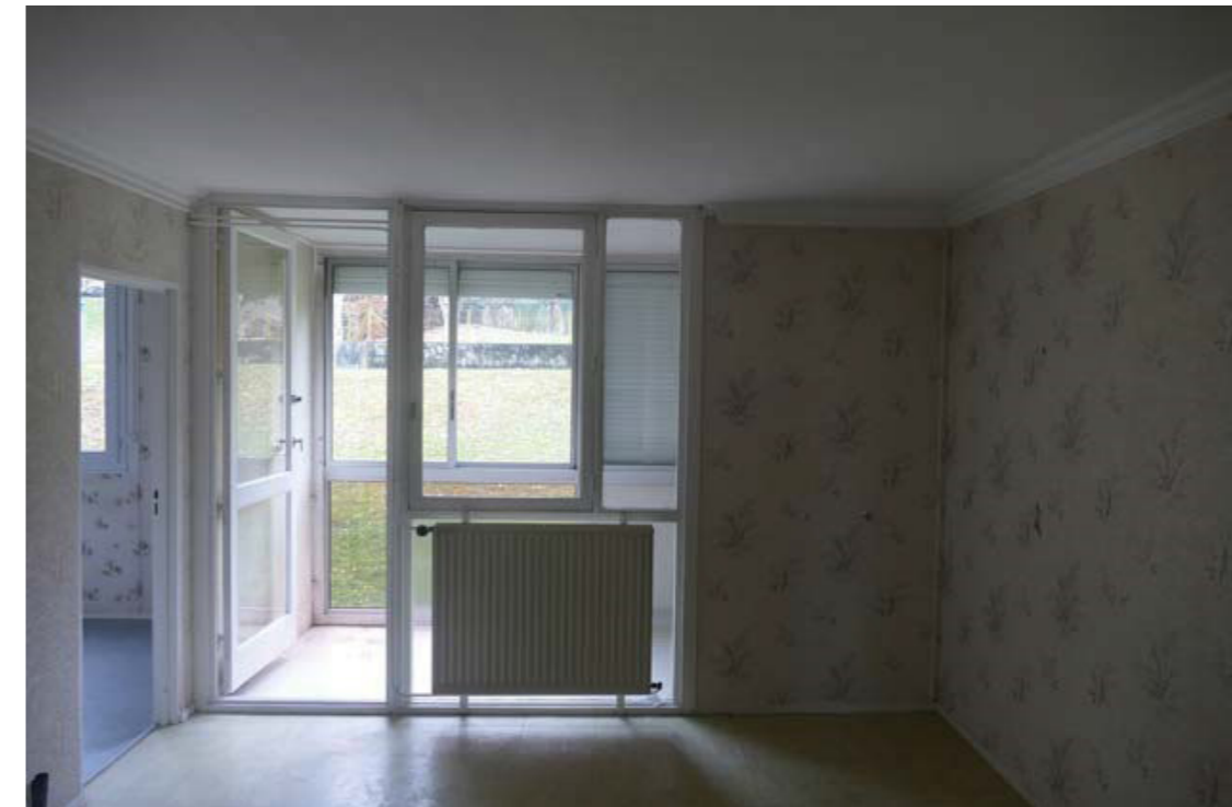
Figure 4 : Façade intérieure séjour avec Loggia | Barre « Peupliers ». Au premier plan, le panneau d'origine, type Z (1958) Au second plan, le panneau de la réhabilitation (1989).
