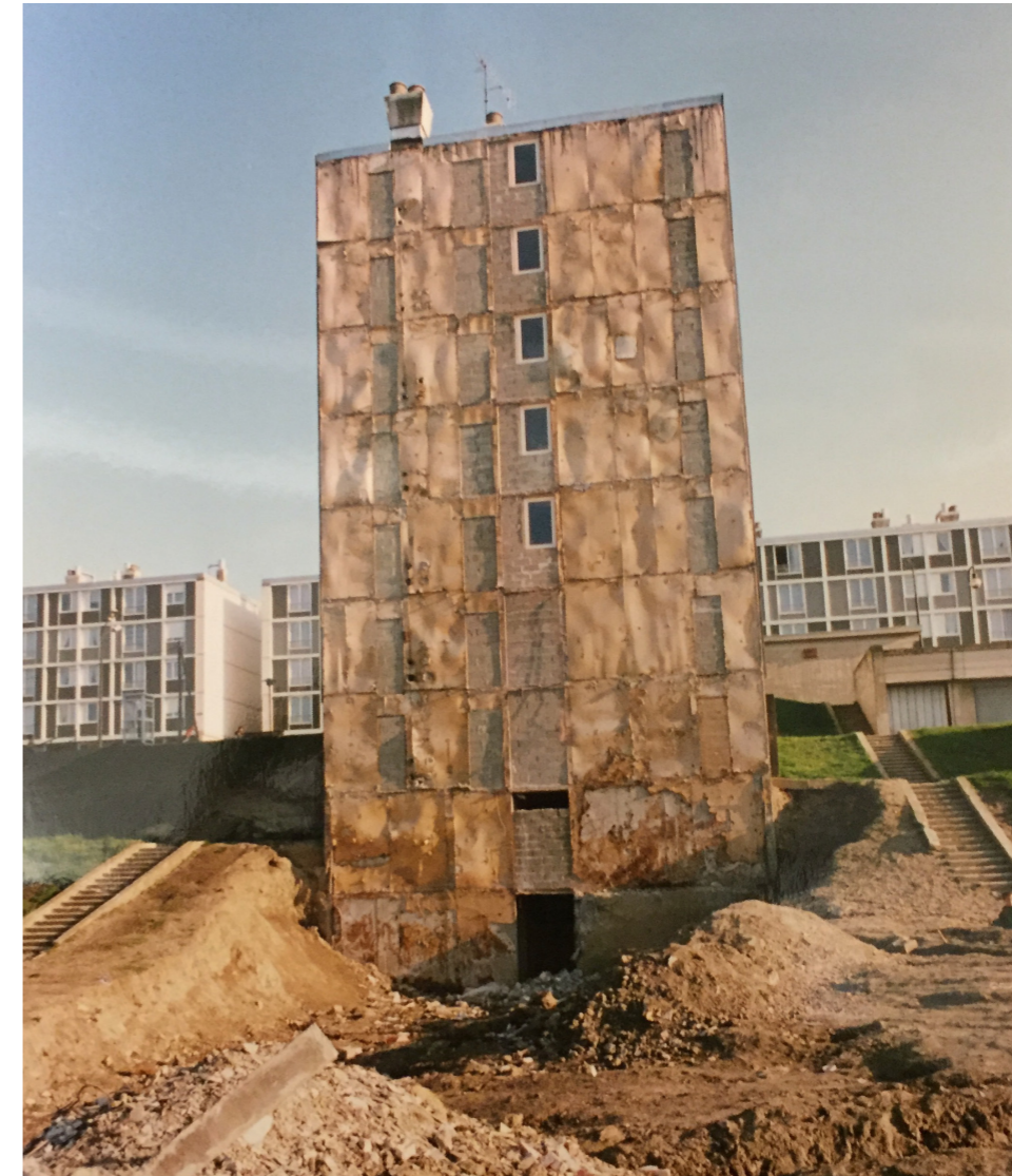
Figure 7 : Photographie de l'immeuble D ou « Chicago » après démolition.
