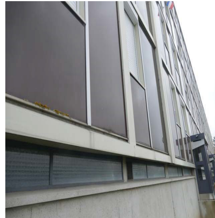
Figure 13 : Façade nord | Barre « Peupliers ».
