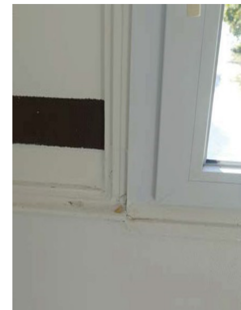
< Figure 8 : Détail menuiserie séjour | Cadre bois, menuiserie PVC.
