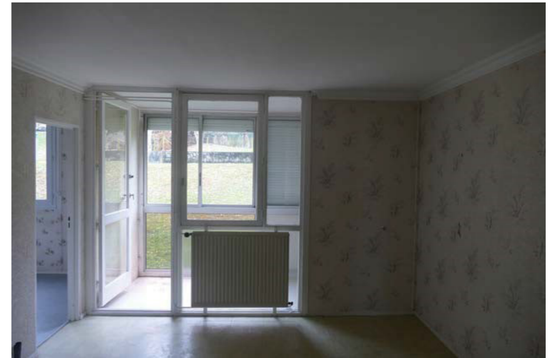
Figure 4 : Façade intérieure séjour avec Loggia | Barre « Peupliers ». Au premier plan, le panneau d'origine, type Z (1958) Au second plan, le panneau de la réhabilitation (1989).
