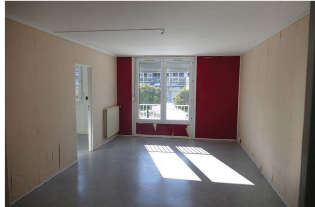
Figure 7 : Façade intérieure séjour | Barre « Peupliers » Cadre bois d'origine (Panneau type A) et intégration menuiserie PVC après réhabilitation.
