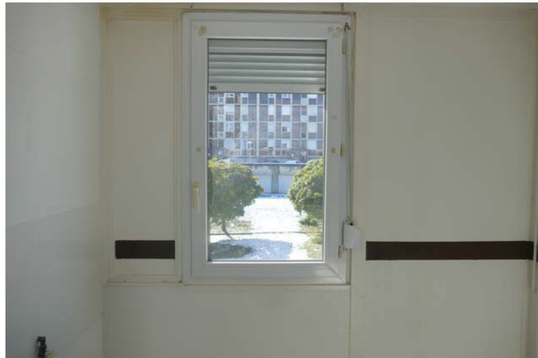
Figure 10 : Façade intérieure cuisine | Barre « Peupliers ». Cadre bois d'origine (Panneau type U) et intégration menuiserie PVC après réhabilitation.
