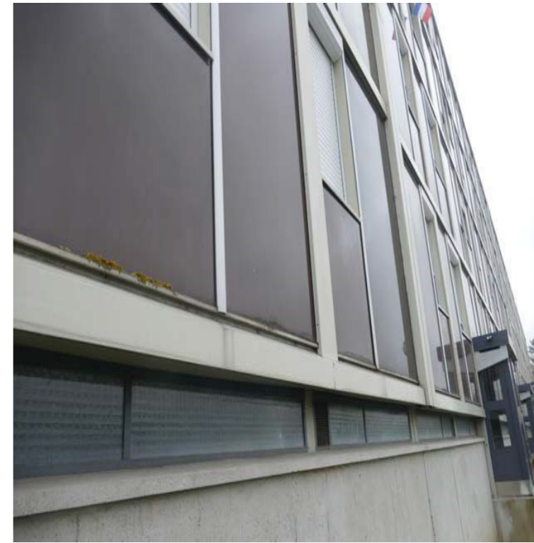
Figure 13 : Façade nord | Barre « Peupliers ».
