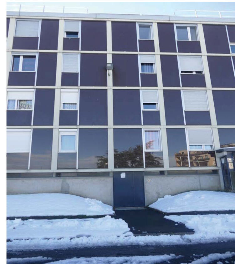
Figure 12 : Façade nord | Barre « Peupliers ».
