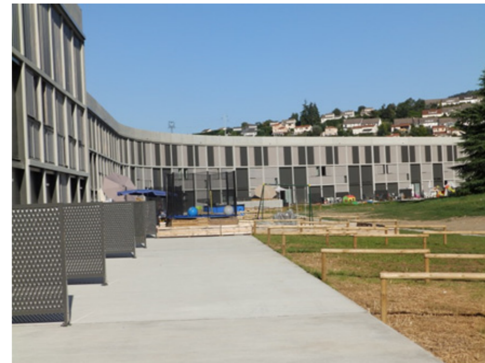
Figure 5 : La Corniche rénovée.
