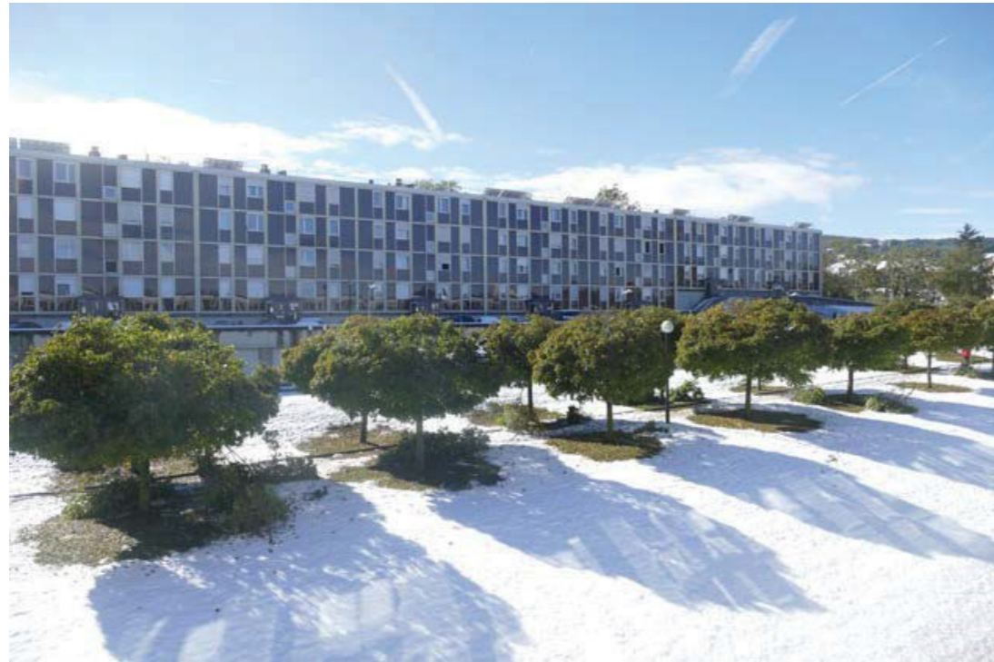
Figure 11 : Façade Nord | Barre « Peupliers ».
