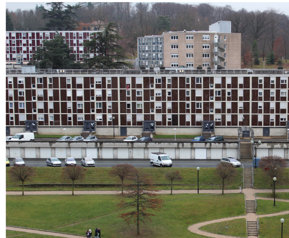
Figures 2 et 3 : Modification des façades et de la volumétrie de l'immeuble B (second plan) au début des années 60, et aujourd'hui.
