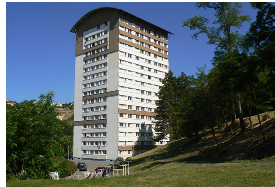
Figure 5 : Tour de l'ensemble de logement Layat.
