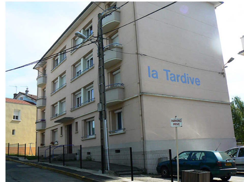
Figure 2 : Logements de la Tardive. Trois immeubles de trois étages et un rez-de-chaussée.
