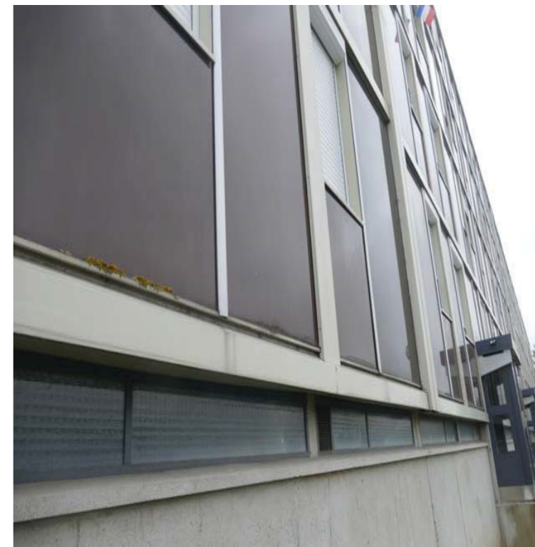
Figure 13 : Façade nord | Barre « Peupliers ».
