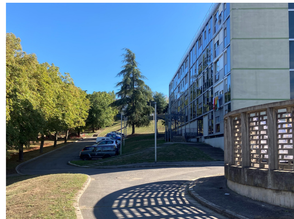
Figures 25 et 26 : En haut, séchoir, Immeuble A (droite), C (gauche) et pignon de l'immeuble D dit « Chicago » au début des années 60. En bas, le même point de vue aujourd'hui, après démolition de deux tiers du Chicago.
