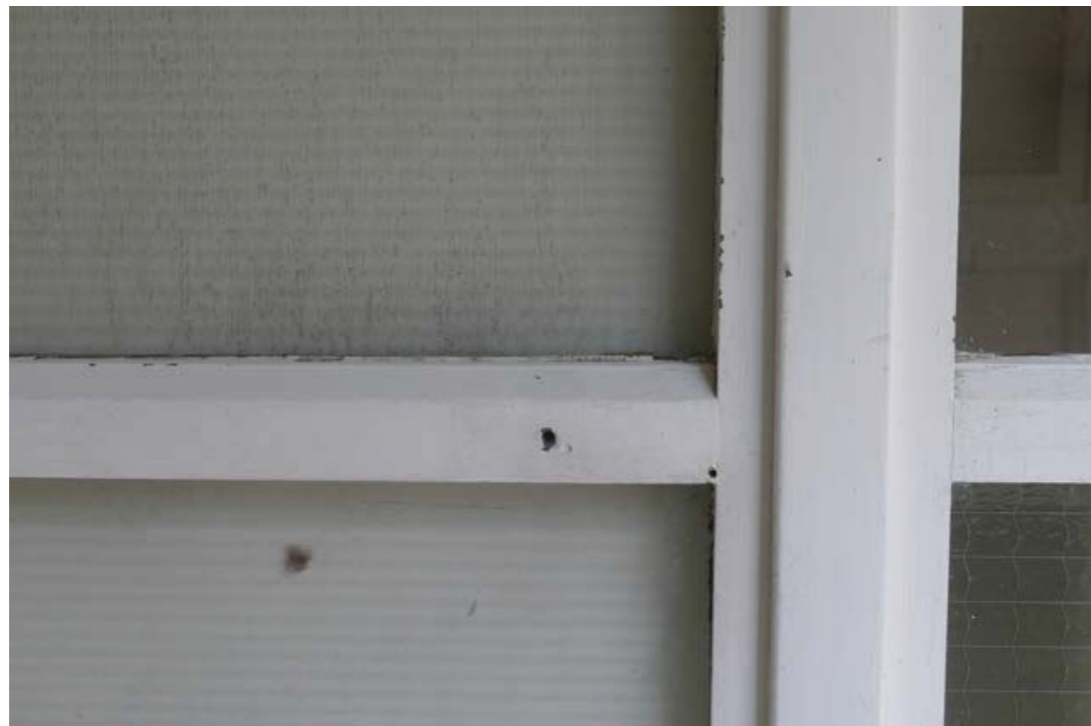
Figure 6 : Détail menuiserie intérieure loggia | Panneau d'origine, type Z (1958).
