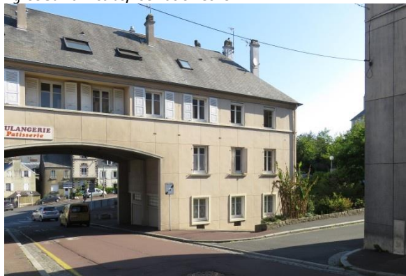
Porche de l'ensemble Gambetta sur la rue du Maréchal Foch
