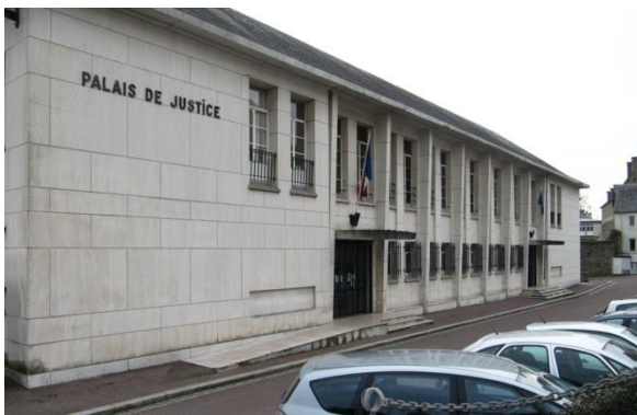
Coutances, le palais de Justice, André Clermont architecte. Avant et après l'ITE. La volonté de préserver les lignes architecturales est évidente : maintien de la colonnade centrale, des auvents des portes, des grilles en applique.
