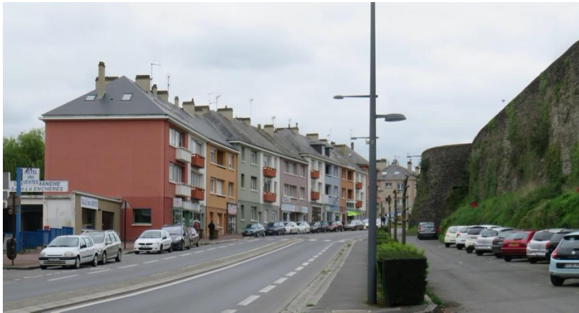
La rue de la Poterne à Saint-Lô. Les limites de propriété dessinées par la peinture contredisent les lignes architecturales du rez-de-chaussée au niveau des vitrines (photo PG)
