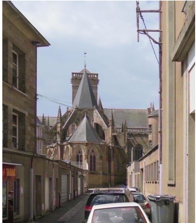
Vire. Incendiée en 1944, l'église Notre-Dame s'est partiellement effondrée en 1946. Elle a ensuite été entièrement restaurée.
