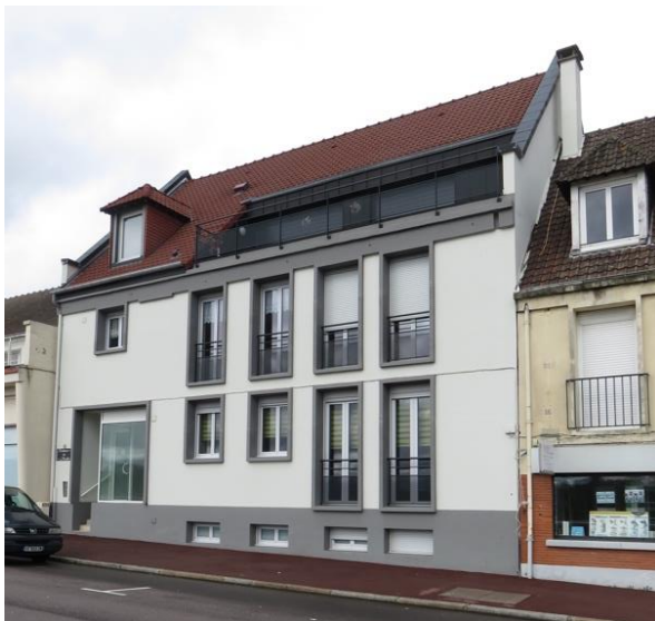
Neufchâtel-en-Bray. Maison transformée sur le pont-route. L'isolation n'a pas été réalisée par l'extérieur.
