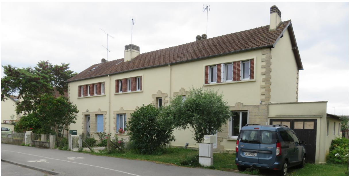
Argentan, logements HLM (?) individuels, rue des Capucins
