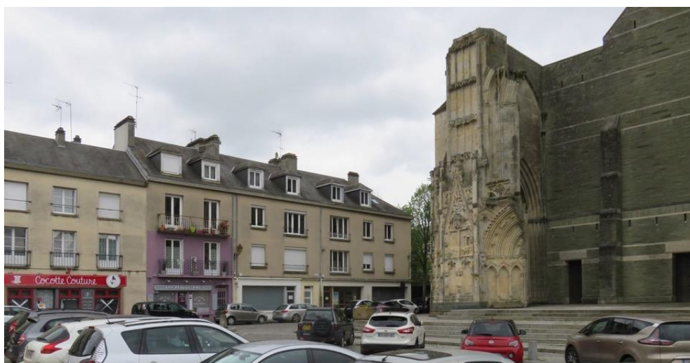
Rue Carnot et place Notre-Dame. La façade à coloriser est celle du grand immeuble d'angle, réunissant trois copropriétés (photo PG)
