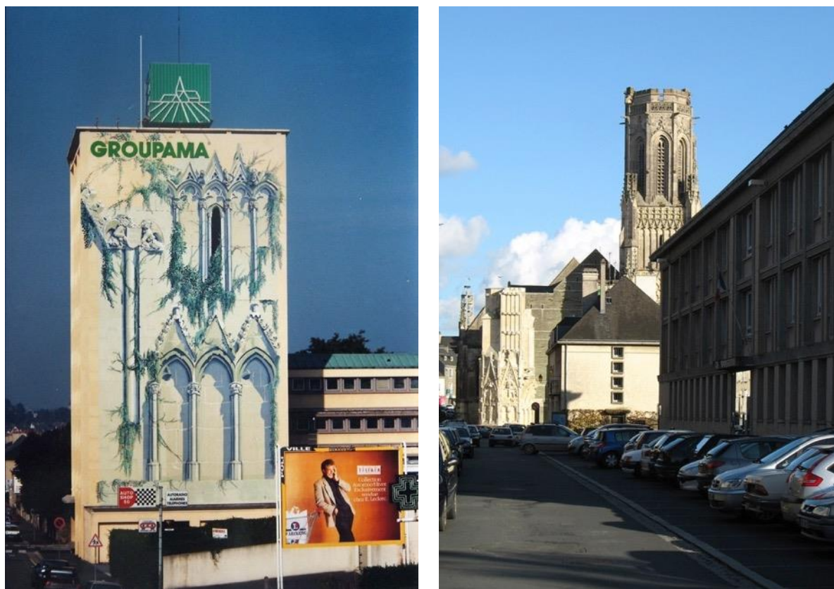
Le trompe-l'œil de la tour de Groupama (photo B. Dufour-Coppolani) ; l'église dans son contexte urbain actuel (photo PG)
