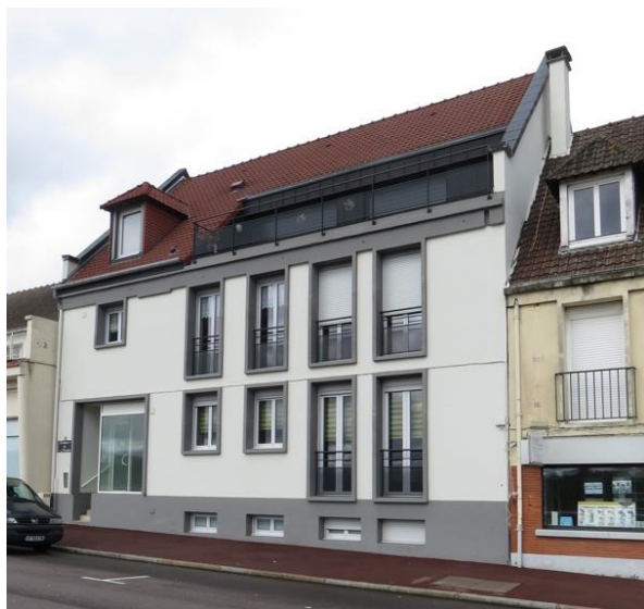
Neufchâtel-en-Bray. Maison transformée sur le pont-route. L'isolation n'a pas été réalisée par l'extérieur.
