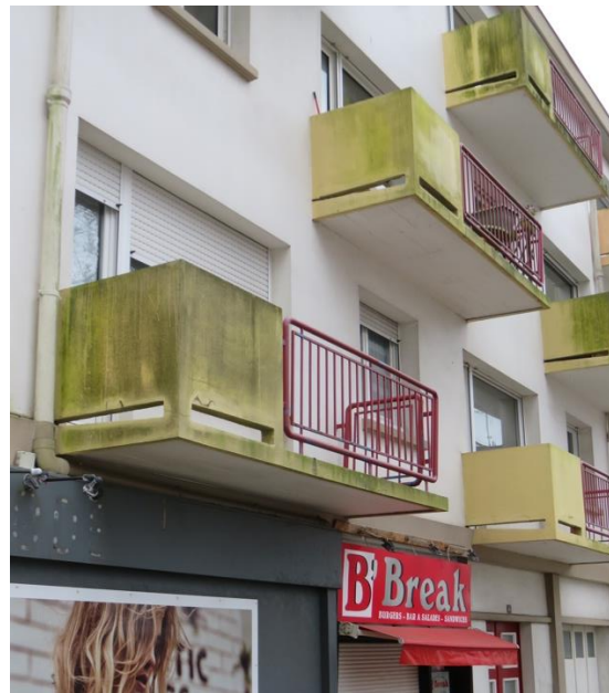
Lorient : vieillissement rapide des surfaces peintes et coexistence difficile avec les couleurs des boutiques
