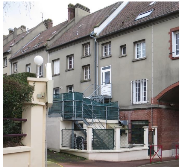
Neufchâtel-en-Bray. Une banque a envahi la totalité du rez-de-chaussée et du premier étage (fenêtre grillagée). L'entrée du second étage a donc été reportée à l'extérieur par un escalier métallique rapporté. Le système de l'ilot ouvert permet de colmater entièrement le rez-de-chaussée de la parcelle
