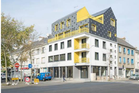
Saint-Nazaire, restructuration de l'immeuble Le Guérandais (Photo
