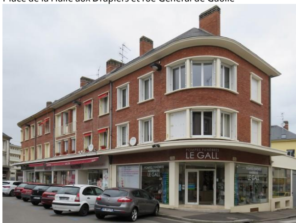
Îlot N, façade place de la Halle aux Drapiers
