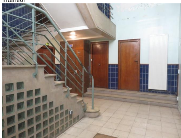
Vernon, l'îlot Pasteur, escalier d'accès aux logements
