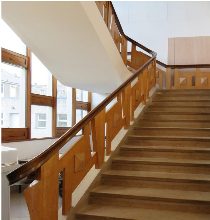
La rampe de l'hôtel de ville, qui avait été remplacée par une structure contemporaine sur un des côtés, a été reconstituée à l'identique en vue de la future protection Monument historique (photo PG)
