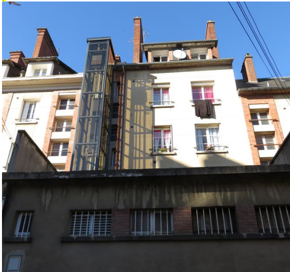
Lisieux, insertion d'un ascenseur, rue de la Libération
