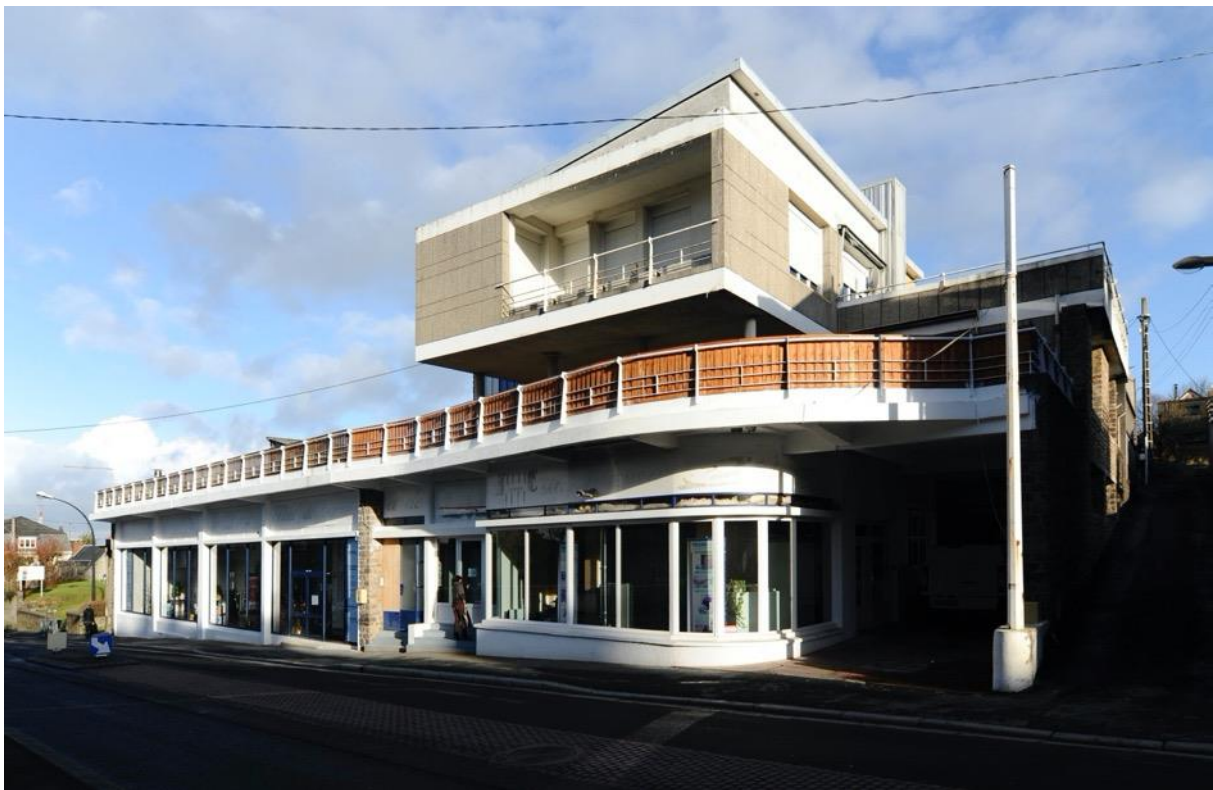
Vire, ancien garage Chatel, rue du Calvados, Claude Herpe architecte. Ce bâtiment spectaculaire, située sur une voie d'accès importante de la ville, comprenait une concession automobile, un garage, une pompe à essence un parc de stationnement et des logements sur la terrasse. Son réaménagement a été subventionné dans le cadre de l'appel à projet régional. (Photo Philippe Delval)
