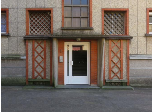
Flers, résidence Saint-Germain : porte d'entrée remplacée par une menuiserie en PVC
