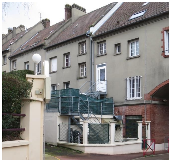
Neufchâtel-en-Bray. Une banque a envahi la totalité du rez-de-chaussée et du premier étage (fenêtre grillagée). L'entrée du second étage a donc été reportée à l'extérieur par un escalier métallique rapporté. Le système de l'ilot ouvert permet de colmater entièrement le rez-de-chaussée de la parcelle
