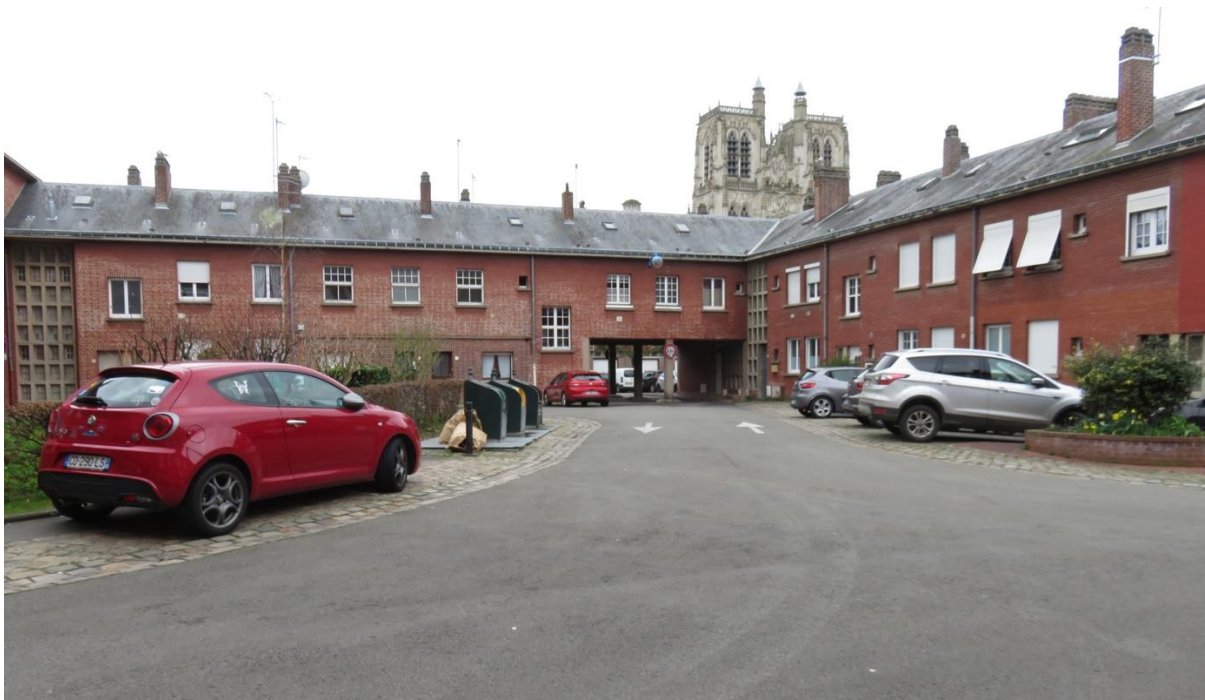
Abbeville : la nature du sol n'est pas clairement définie, les rues sont indépendantes du bâti
