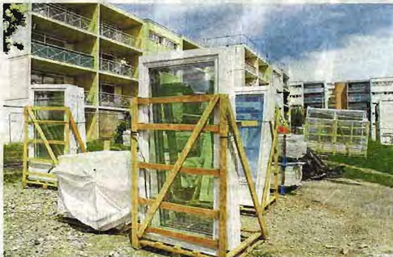
Toutes les menuiseries de 229 logements vont être changées.
