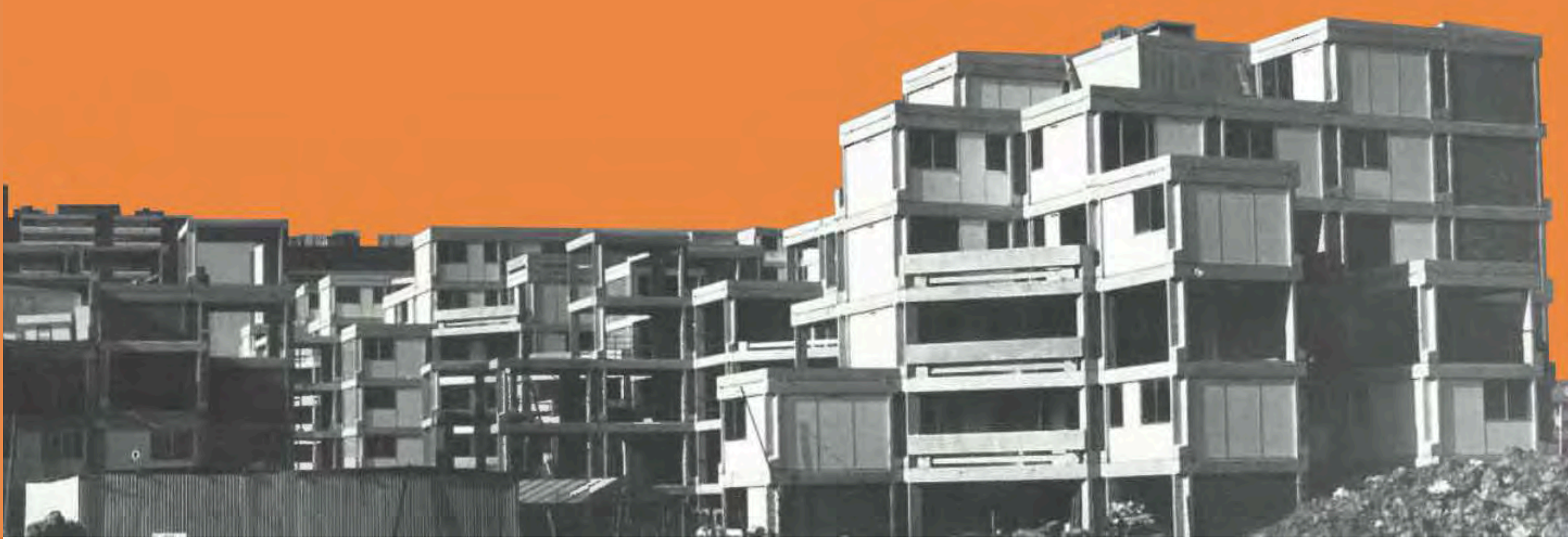
"Modèle Innovation Maillard, photographie de mise en oeuvre d'un tabouret", Jean-Pierre Maillard + Jean Roussel architectes & SAIEMFM, extrait de la plaquette de présentation, 1975
