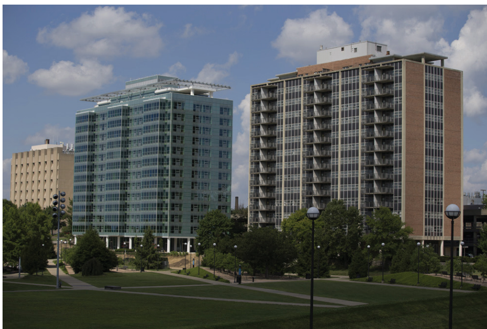
Figure 28. Photo des bâtiments en 2013. À gauche Morgen Hall rénové, à droite Scioto Hall avant rénovation. On distingue bien sur cette photo l'apparence d'origine des bâtiments. Université de Cincinnati
