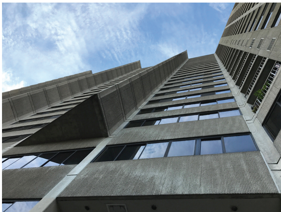
Figure 22. Vue de façade montrant l'articulation de la structure et l'enveloppe en béton armé. Photo Kent Fitzsimons 2017
