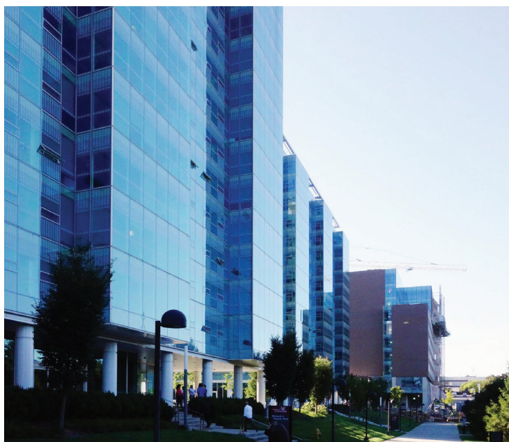
Figure 30. Vue depuis le pied des immeubles en direction du nouveau bâtiment en chantier. Photo Louise Jammot 2017
