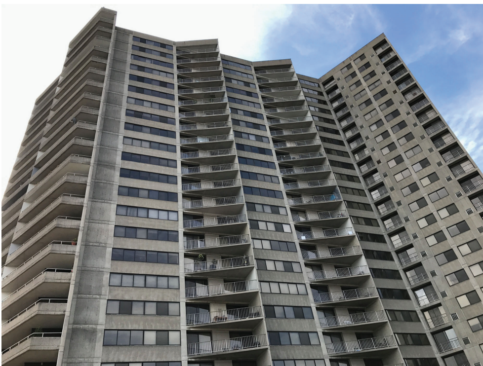
Figure 24. Vue d'une façade de l'immeuble, avec balcons triangulaires et loggias. Photo Kent Fitzsimons 2017
