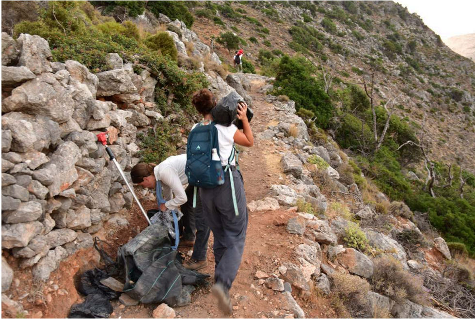
Fig. 44. Acheminement des matériaux de consolidation.
