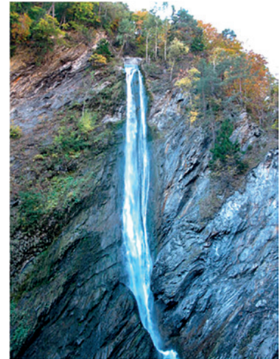
Figure 7: Débouché aval du tunnel de contournement du glissement de terrain sur le torrent du Morel (Aigueblanche, 73). Le tunnel, percé dans le versant stable situé en face du glissement de terrain, détourne le torrent du pied du glissement (situé de l'autre côté du vallon qu'on devine sur la droite de la photo) et empêche le cours d'eau d'éroder le pied de la masse instable et de se charger de sédiments qu'il transporterait en aval sur les zones à enjeux.
