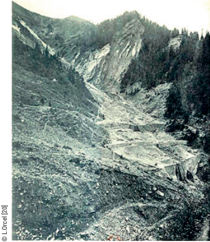
Figure 5: mention Eaux et Forêts 1911 [20], légendée Barrages de rétention des dépôts morainiques issues des têtes de bassins: Ravin des Arandellys, affluent de la Griez qui se jettent dans l'Arve en aval du barrage EDF des Houches (74).
