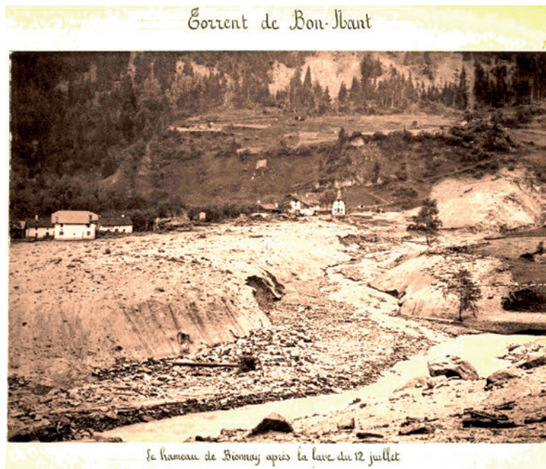
Figure 4: Hameau de Bionnay ravagé par la rupture de la poche du glacier de Tête Rousse et la lave torrentielle qui s'est formé en aval. Catastrophe qui engendra 175 morts en 1892.
