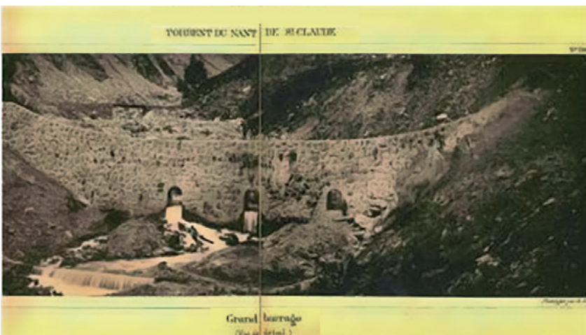
Figure 6: Grand barrage du Nant Saint Claude en aval d'un éboulement (73). Le barrage est équipé de pertuis permettant le passage de l'eau en attendant qu'il se remplisse de matériaux et élève ainsi le niveau du torrent.
