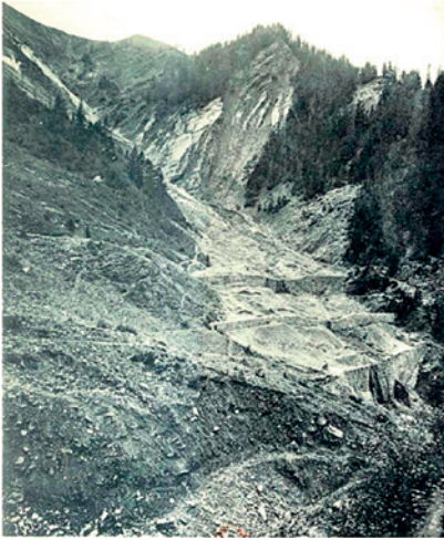
Figure 5: mention Eaux et Forêts 1911 [20], légendée Barrages de rétention des dépôts morainiques issues des têtes de bassins: Ravin des Arandellys, affluent de la Griez qui se jettent dans l'Arve en aval du barrage EDF des Houches (74).
