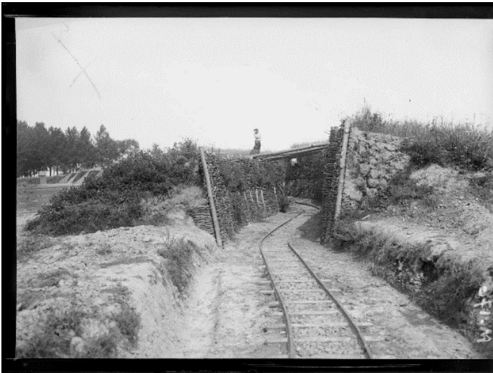
SPA 14 M 176 Batterie de Thorigny (Seine-et-Marne)
