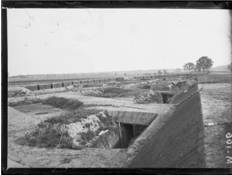
SPA 14 M 166 Torcy. Les ouvrages de défenses
