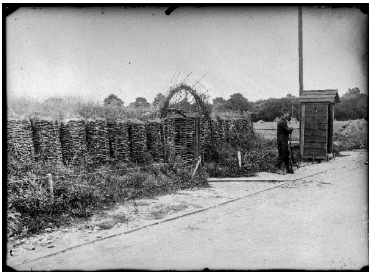
SPA 8 T 140 Batterie d'artillerie n°104 située entre Soisy-sous-Montmorency et Domont avec sa poudrière. Entrée de la batterie 104
