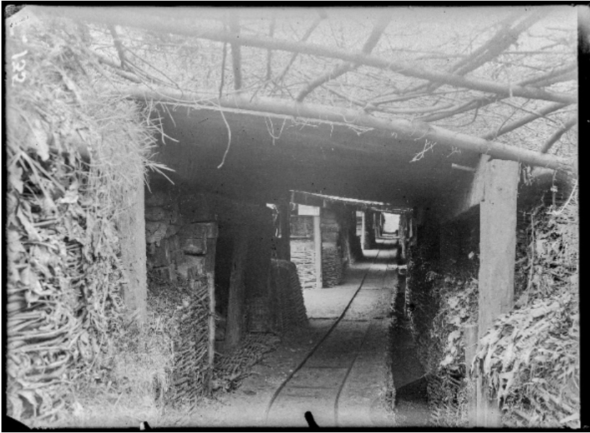
SPA 8 T 135 Batterie d'artillerie n°104 située entre Soisy-sous-Montmorency et Domont avec sa poudrière. A la Croix Blanche, le couloir central
