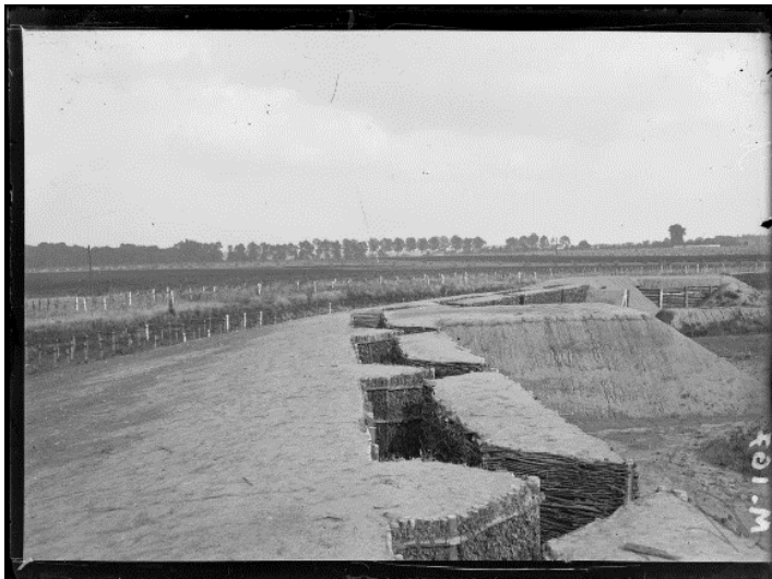
SPA 14 M 167 Torcy. Les ouvrages de défenses
