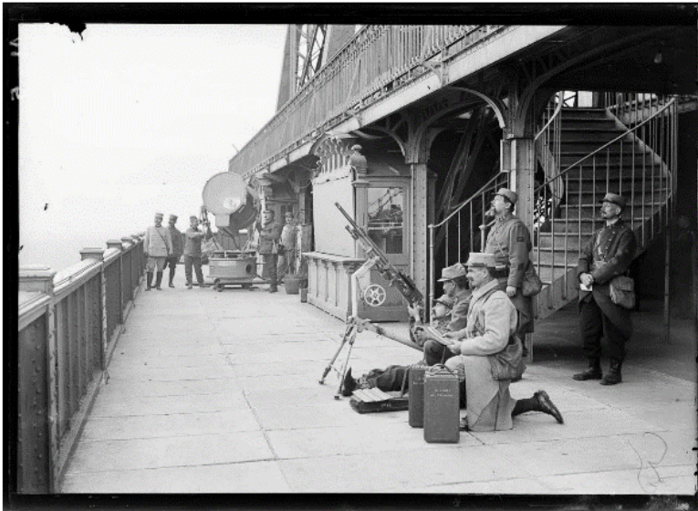
SPA 1 M 5 26 juillet. Tour Eiffel. Mitrailieuse et projecteur 2 e plateforme
