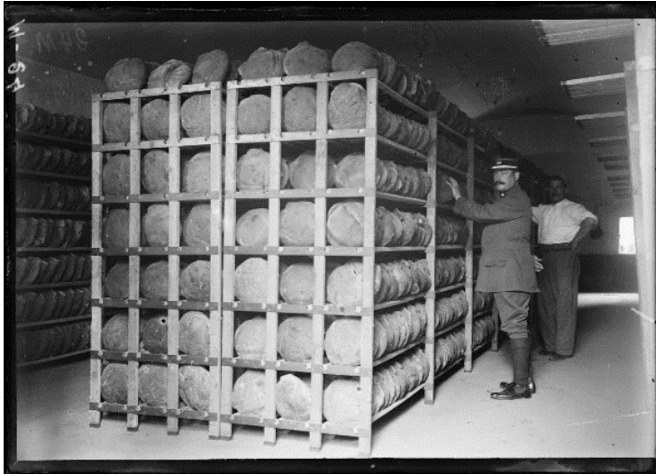
SPA 3 M 24 Fort de Vincennes. La panneterie
