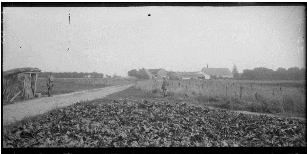
SPA 9 Z 153 CRP. Derrière de la ferme de Champagne. Protection de fil de fer
