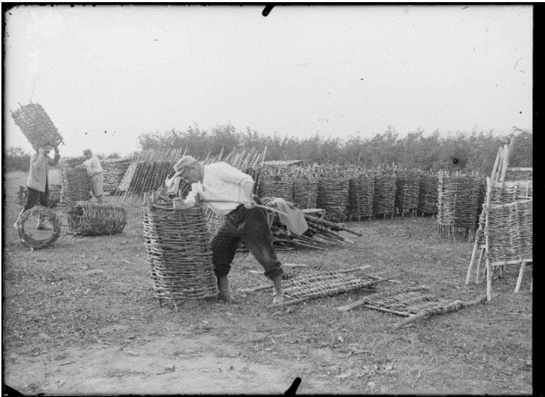
SPA 16 T 542 Champlan. La Butte Chaumont. L'école de fascinage. Les gabions
