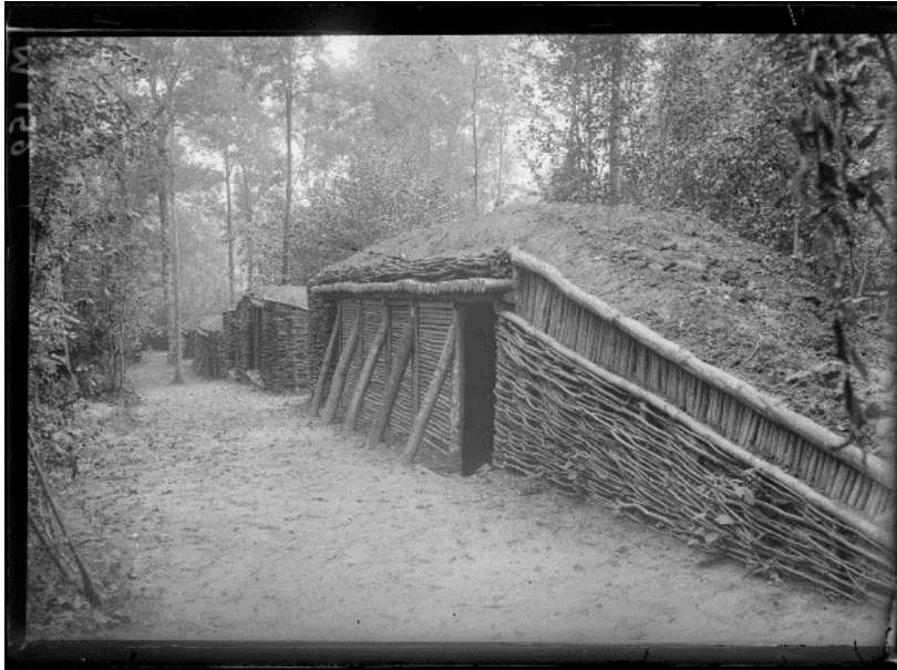
SPA 14 M 152 La batterie de Vaseliers, entre Montebise et Signy-Signets
