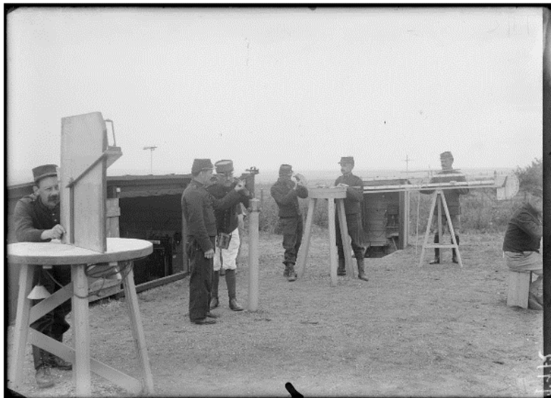
SPA 10 T 172 Frépillon. Poste de télémétrie
