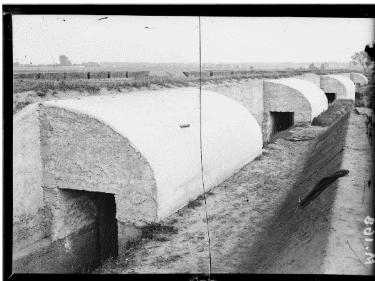
SPA 14 M 168 Torcy. Les ouvrages de défenses
