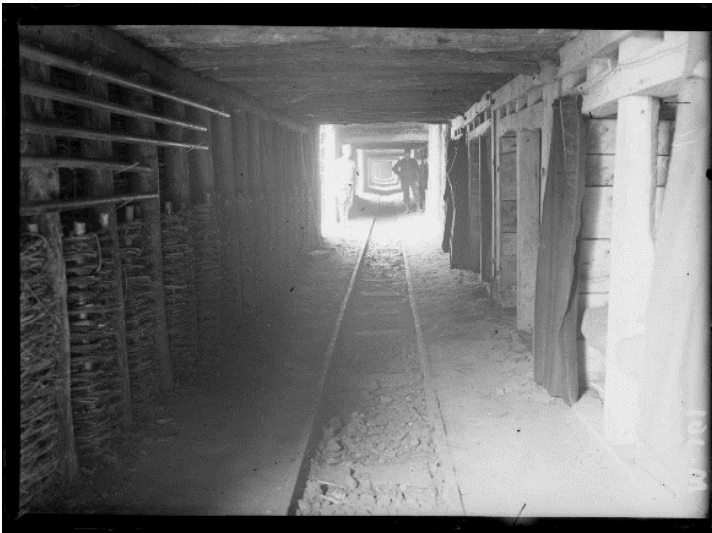
SPA 14 M 161 Torcy. Couloir montrant l'enfilade des batteries
