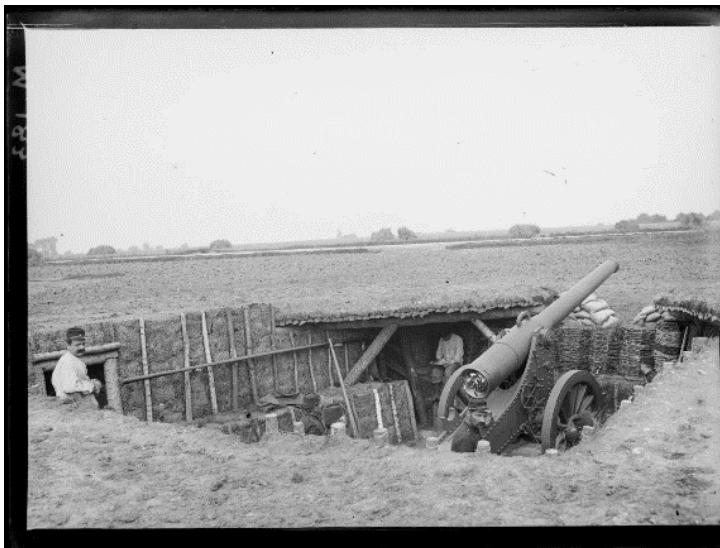
SPA 14 M 183 Batterie de Croissy-Beaubourg
