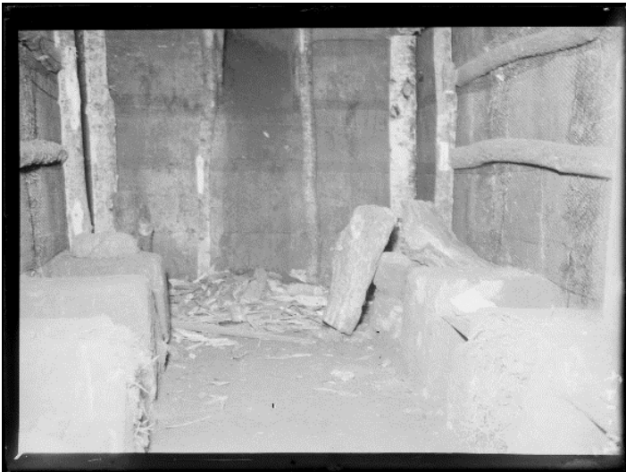
SPA 14 M 147 Cuisine de tranchée refuge pour soutien de la 1ère compagnie.
