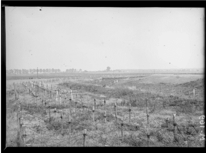
SPA 14 M 169 Torcy. Les ouvrages de défenses
