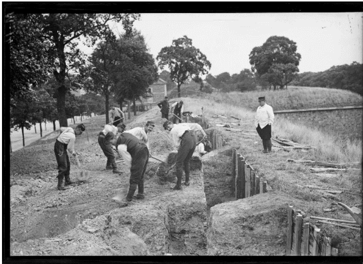
SPA 2 M 14 Tranchée porte de Châtillon Charenton.
