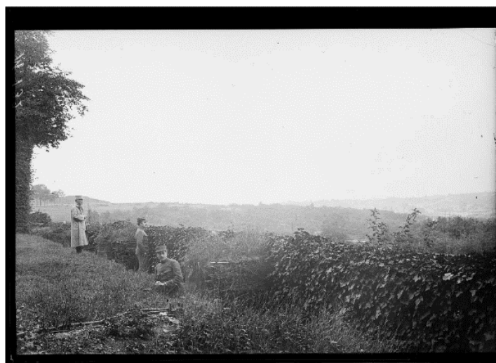
SPA 12 M 132 cliché se raccordant pour montrer la ligne de tranchées suivant celle du fort de Rosny
