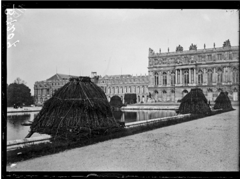
SPA 145 B 7207 Versailles, travaux de protection
