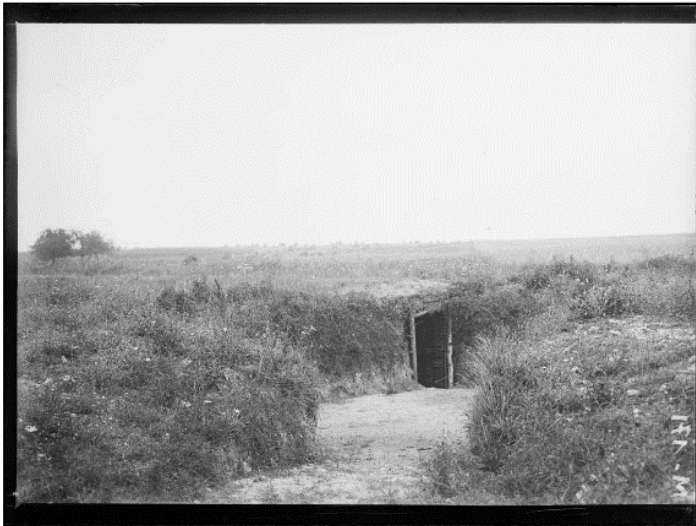
SPA 14 M 171 Batterie construite entre Milheuil et Bois la Ville
