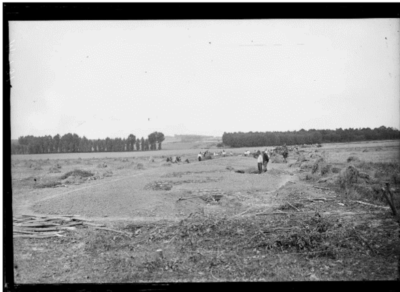
SPA 12 M 131 Territoriaux construisant des tranchées à Saint-Witz
