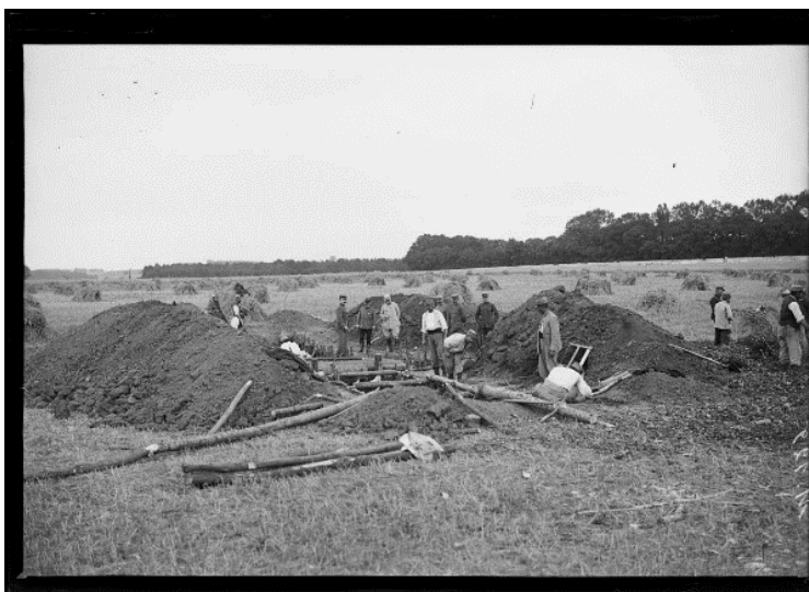
SPA 12 M 129 Territoriaux construisant des tranchées à Vemars.
