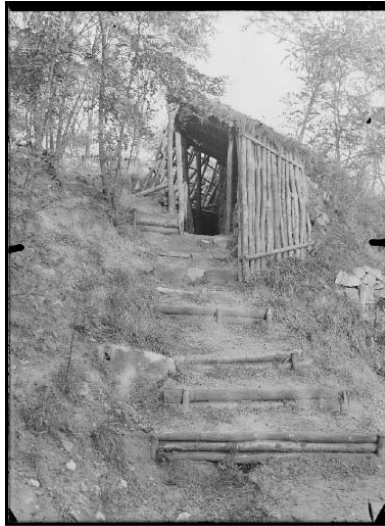
SPA 16 T 530 Saulx les Chartreux – Balainvillier. Un des accès du pourtour de la tour 22 H (galerie demi couvert)
