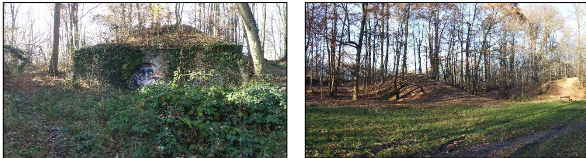
Figure 23 : Batteries de Noisy (gauche) et de l'Auberderie (droite) (ONF/C.Dardignac).
