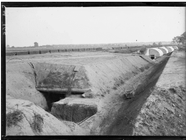
SPA 14 M 165 Torcy. Les ouvrages de défenses
