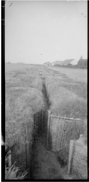
SPA 9 Z 155 CRP. Boyaux de communication, Ferme de Champagne à Savigny-sur-Orge
