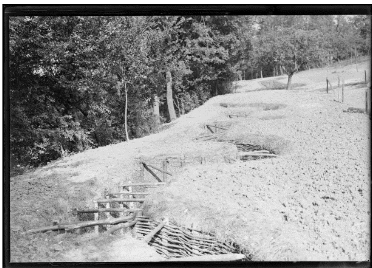
SPA 14 M 213 Tranchées à droite de la route de Monthyon
