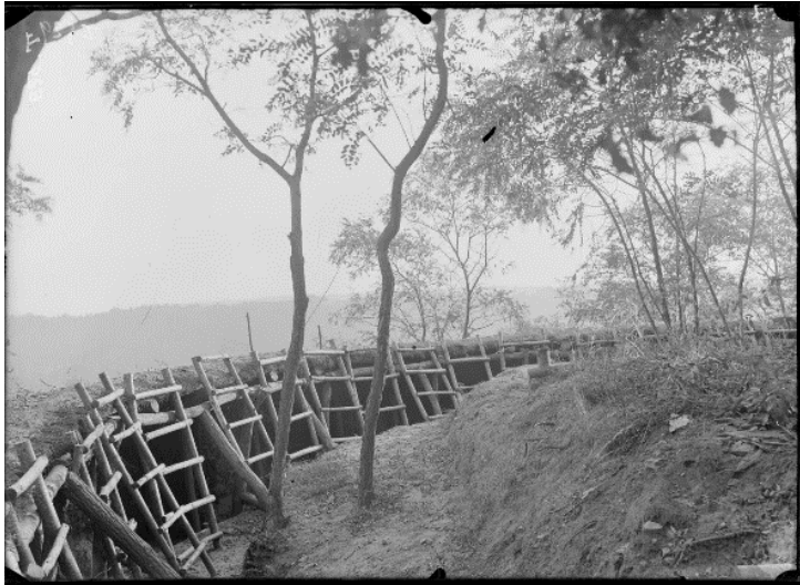
SPA 16 T 529 Saulx les Chartreux – Balainvillier. Ce que l'on nomme la tour 22 H (sorte de fer à cheval constitué par des débris de grès et de terre formant promontoire dans le bois dit : Rochers de Saulx. Une galerie circulaire et échelons d'accès complètent l'ouvrage
