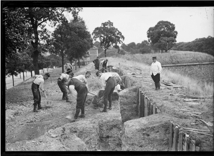
SPA 2 M 14 Tranchée porte de Châtillon Charenton.
