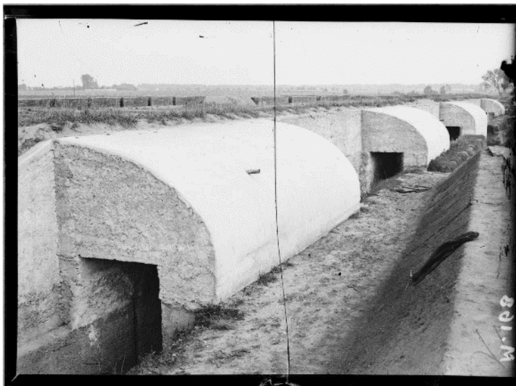
SPA 14 M 168 Torcy. Les ouvrages de défenses
