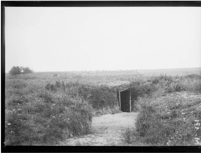
SPA 14 M 171 Batterie construite entre Milheuil et Bois la Ville
