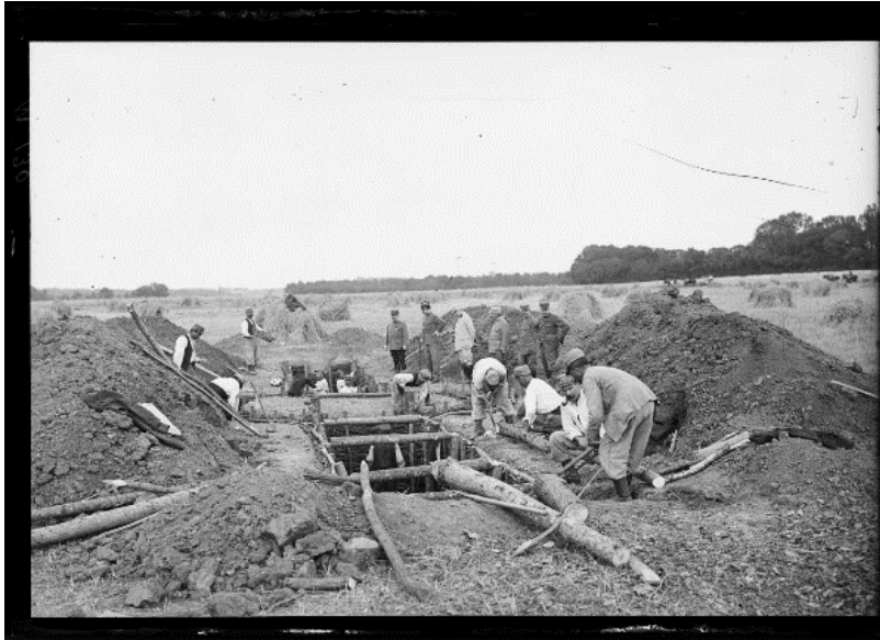
SPA 12 M 130 Territoriaux construisant des tranchées à Vemars.
