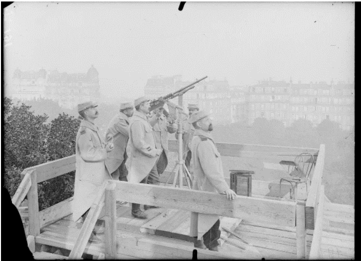
SPA 10 T 191 Buttes Chaumont. Le poste n°2. DCA mitrailleuse
