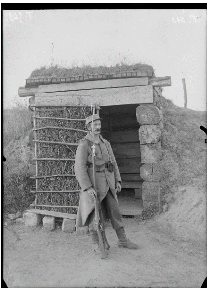
SPA 16 T 543 Champlan. La Butte Chaumont. L'école de fascinage. A l'entrée. La sentinelle
