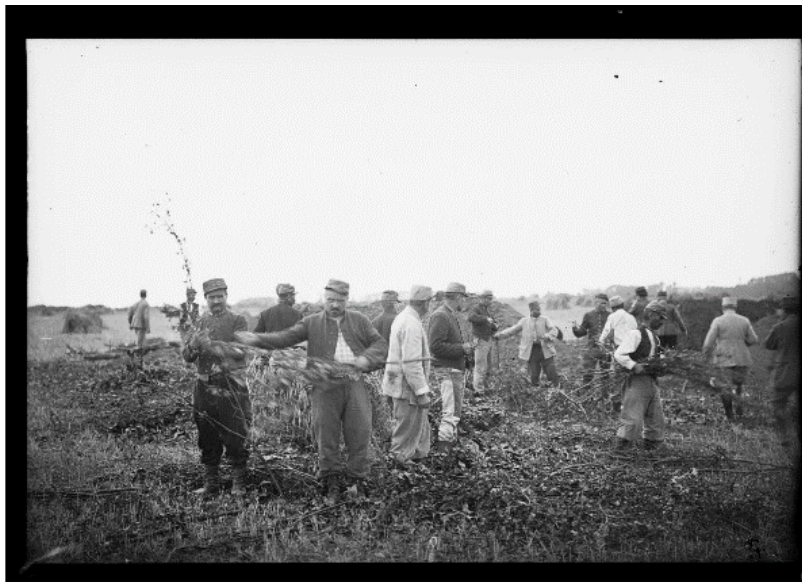
SPA 12 M 128 Territoriaux arrangeant des branches pour servir à la construction des tranchées. Aubervilliers
