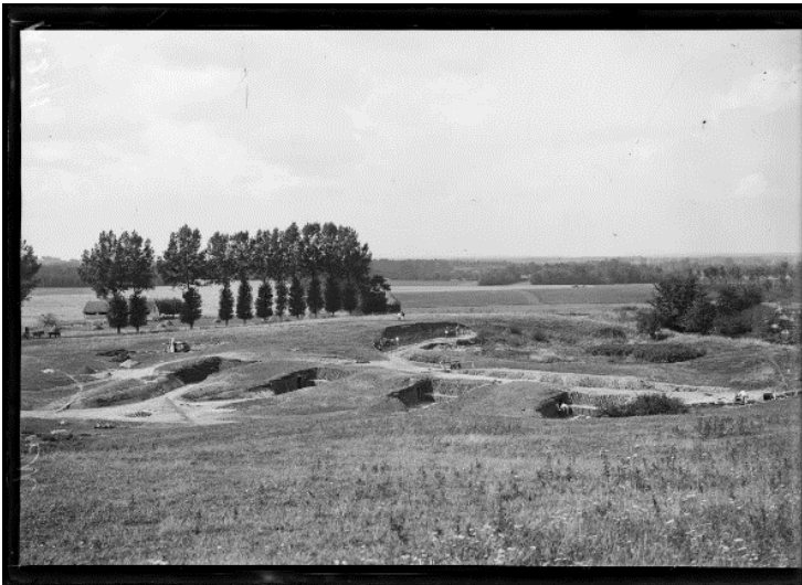
SPA 14 M 211 Batterie de Saint-Thibault en construction
