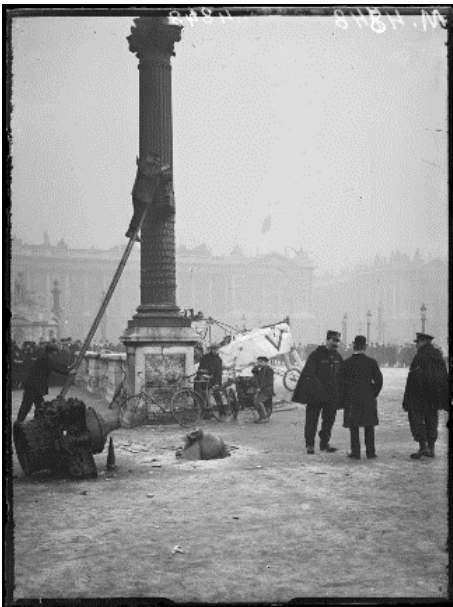
SPA 253 M 4848 Dommages causés par les avions sur Paris dans la nuit du 30 au 31 janvier. Avion français ayant atterri place de la Concorde
