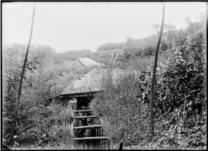
SPA 16 T 541 La Butte Chaumont. Champlan. Abris blindés recouverts pour ? et au fond un boyau d'accès
