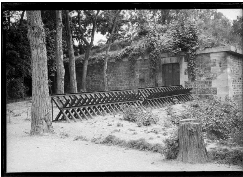
SPA 2 M 22 Tranchées Porte de Passy (27 juillet 1915). Cheval de frise
