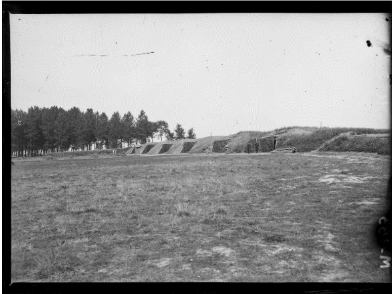
SPA 14 M 163 Torcy. Extérieur de l'ouvrage
