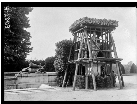
SPA 145 B 7203 Versailles, travaux de protection. Dans le Parc la statue de Flore
