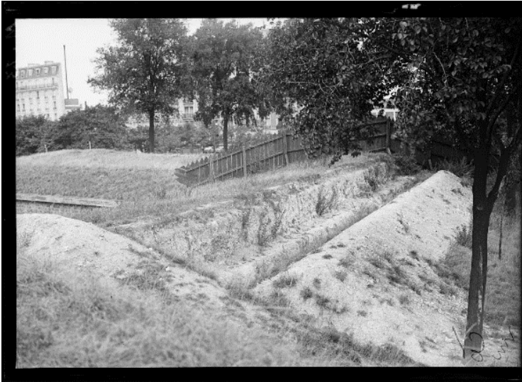
SPA 2 M 13 Tranchée Port de Châtillon – Charenton (27 juillet 1915)
