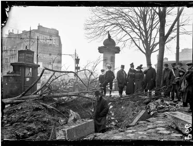
SPA 7 P 66 Dégâts causés dans Paris par le raid d'un zeppelin le 29 janvier 1916. Quartier de Mesnilmontant
