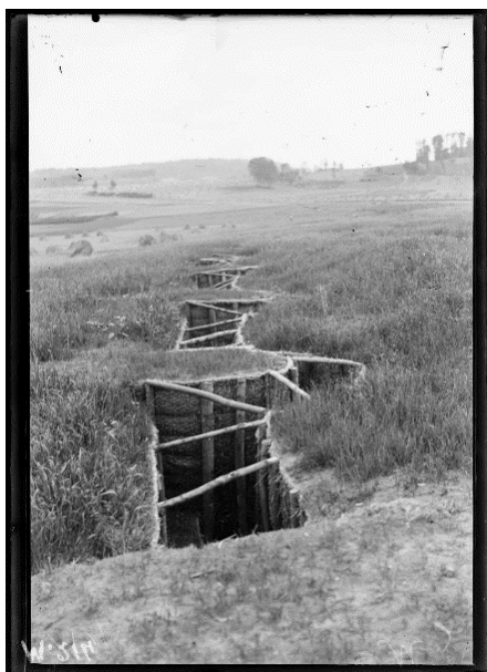
SPA 14 M 214 Tranchée à droite de la route de Monthyon
