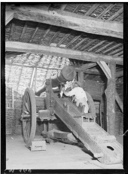
SPA 14 M 162 Torcy. Nettoyage d'un 120 long
