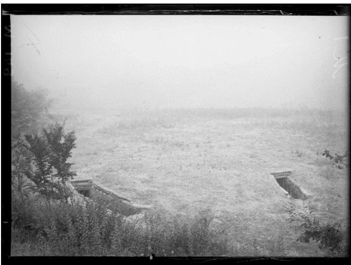
SPA 14 M 149 Poste entre la Ferté-sous-Jouarre et Ussy, contre le chemin de fer
