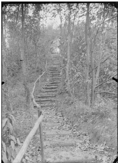
SPA 16 T 532 Saulx les Chartreux – Balainvillier. Escalier qui conduit à la tour 22 H (aux Rochers de Saulx)
