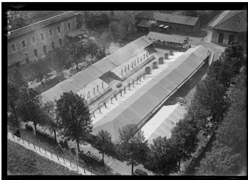
SPA 3 M ? Fort de Vincennes. Vue générale de la boulangerie
