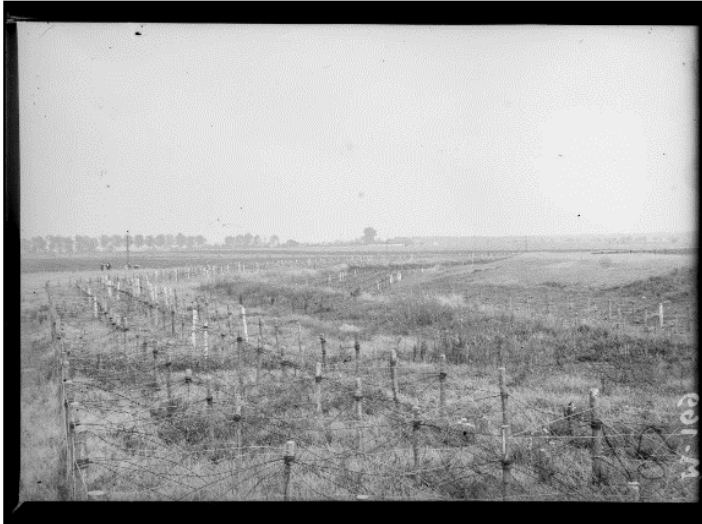
SPA 14 M 169 Torcy. Les ouvrages de défenses
