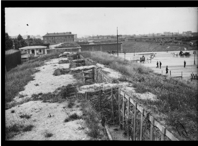
SPA 2 M 19 Tranchées Porte de la Chapelle (27 juillet 1915)
