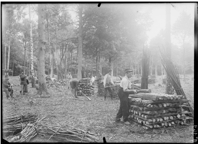
SPA 10 T 169 CRP. L'Isle Adam et la confection de pieux pour les tranchées
