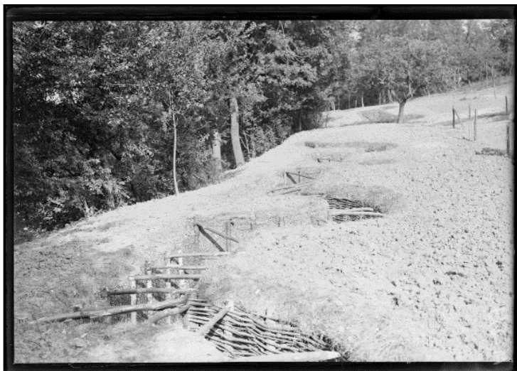
SPA 14 M 213 Tranchées à droite de la route de Monthyon
