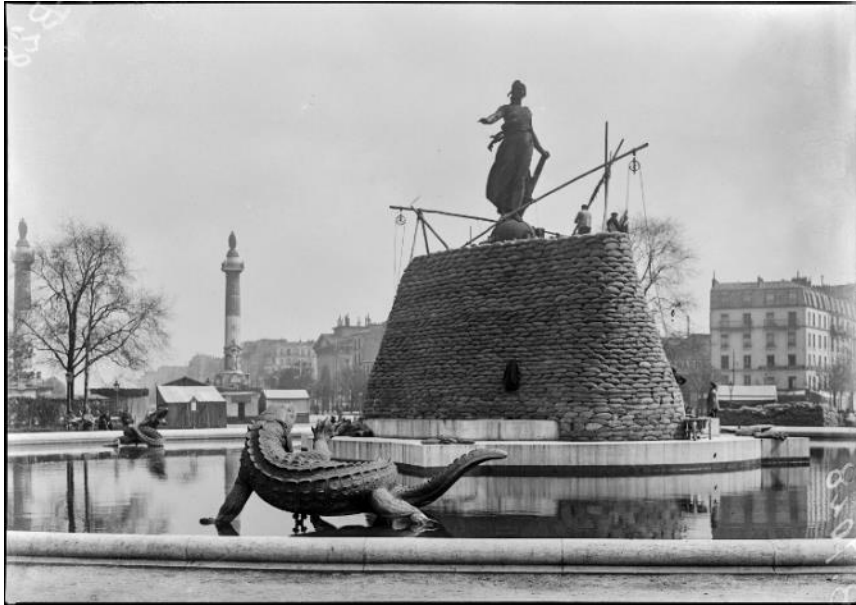
SPA 140 B 7028 Travaux de protection. Paris, La Fontaine de Dalou, place de la Nation
