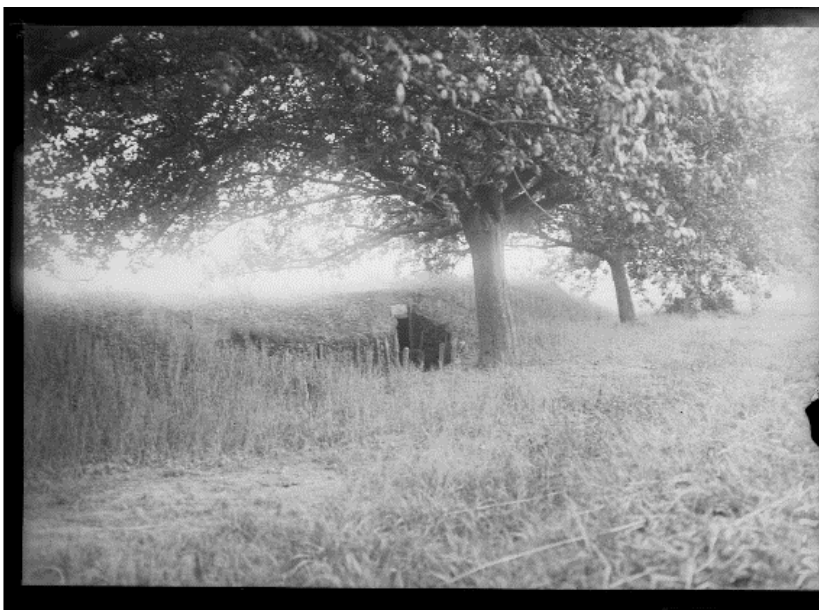
SPA 14 M 172 Poste du Puits près de Chailly en Brie
