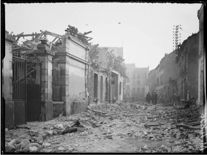
SPA 253 M 4856 Dommages causés par les avions sur Paris dans la nuit du 30 au 31 janvier. Fontenay-sous-Bois
