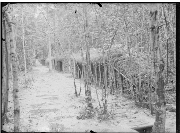
SPA 3 T 19 27 juillet 1915. Batterie du Tertre à 1km du nord de Touquin
