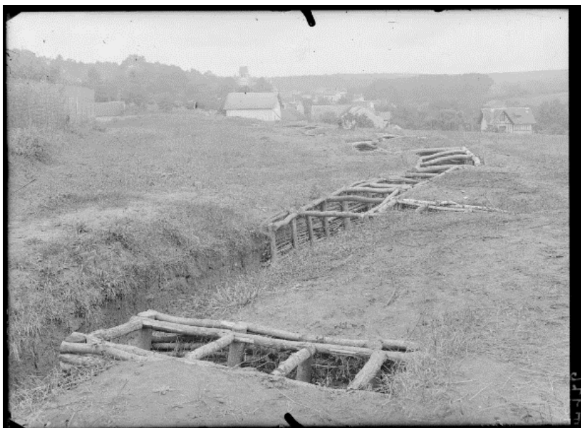
SPA 10 T 176 Entre Parmain et Jouy-le-Comte. Les tranchées et abris pour mitrailleuses
