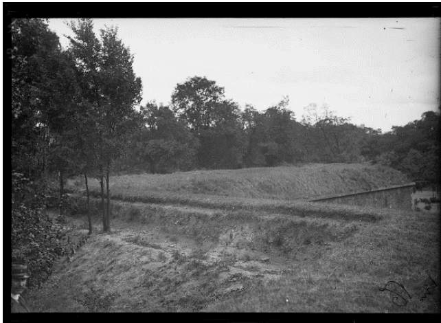
SPA 2 M 21 Tranchées Porte de Passy (27 juillet 1915)
