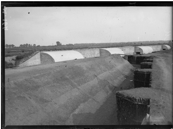
SPA 14 M 164 Torcy. Les ouvrages de défenses
