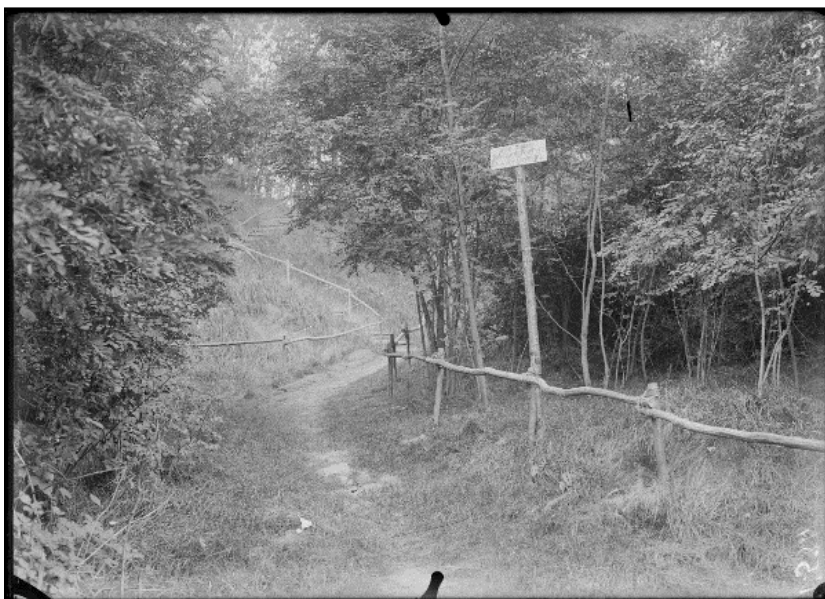
SPA 16 T 534 Saulx les Chartreux – Balainvillier. Poteau de signalisation
