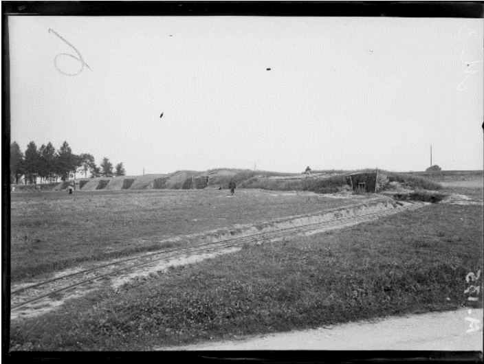
SPA 14 M 175 Batterie de Thorigny (Seine-et-Marne)
