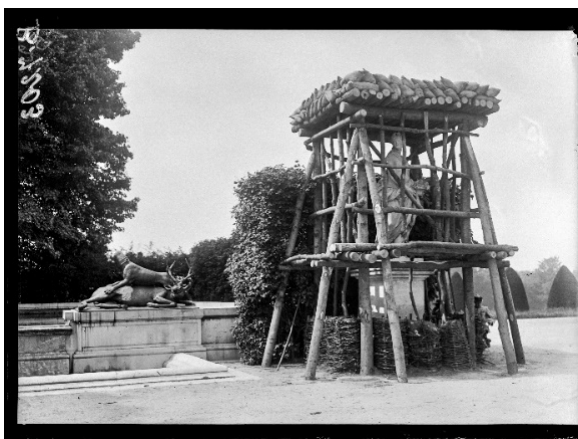
SPA 145 B 7203 Versailles, travaux de protection. Dans le Parc la statue de Flore
