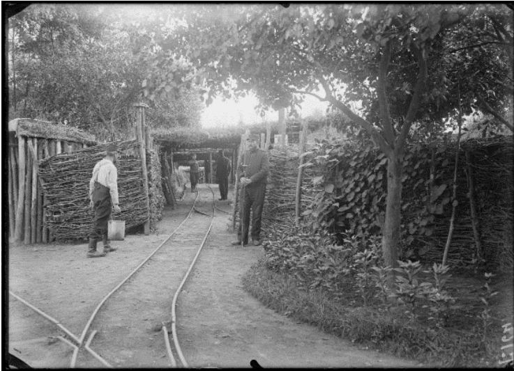
SPA 10 T 164 Montigny. L'entrée de la batterie 113
