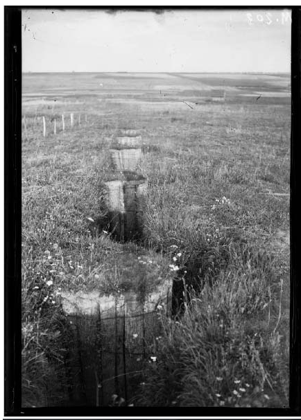
SPA 14 M 203 Tranchée manœuvre à Etrepilly
