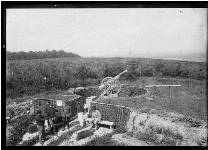
SPA 14 M 205 Batterie NO du fort de Vaujours
