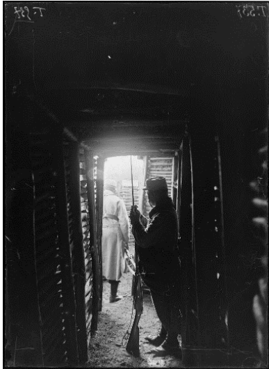
SPA 16 T 537 Champlan. La Butte Chaumont. Travaux de défense. Tranchées couvertes
