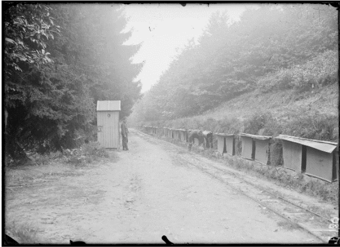
SPA 10 T 180 Bois Corbon. Château de Courcy (par St Prix). Les réserves à poudre
