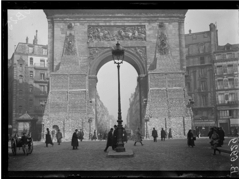
SPA 138 B 6929 Protection des œuvres d'art. Porte de Saint-Denis
