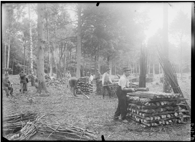
SPA 10 T 169 CRP. L'Isle Adam et la confection de pieux pour les tranchées
