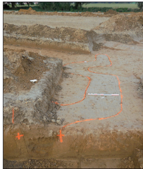
Vue de la tranchée 14.10 et du sondage vers le nord-ouest
