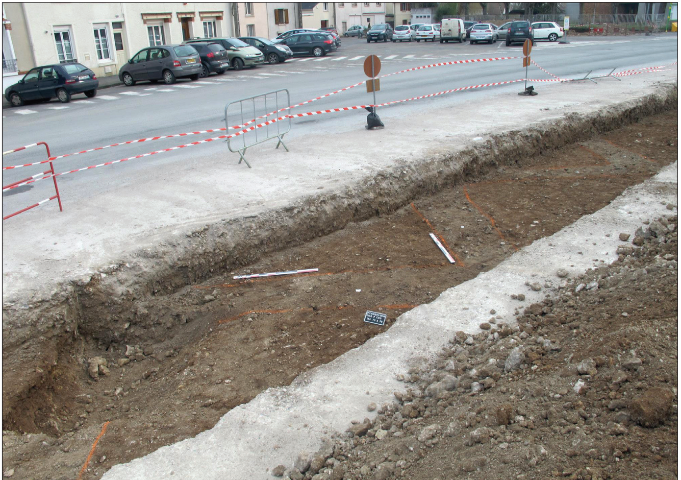
Fig. 28 : vue générale des faits dans la tranchée 4. Cliché F. Capron
