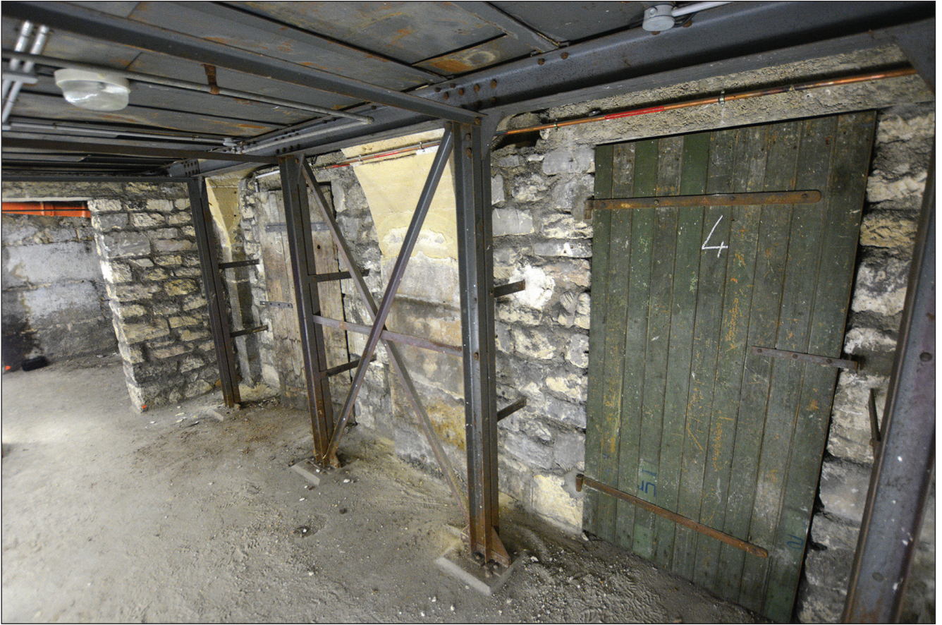
Fig. 41 : vue des renforcements du plafond. © N. Samuelian, Inrap
