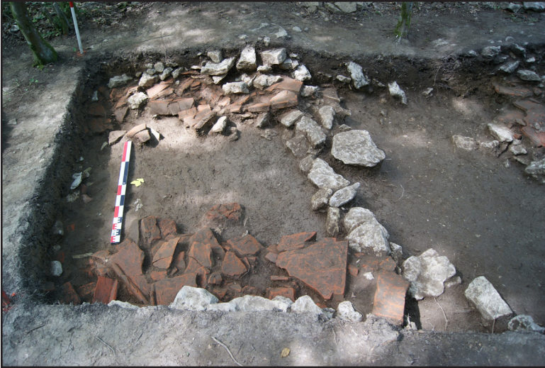
Fig. 30. Niveau de sol 106 dans la partie occidentale du sondage. Le niveau de tuiles (112) qui le recouvre n'est pas encore entièrement dégagé. Au centre, la fondation 108. Sous le niveau de tuiles au nord, contre la fondation, le niveau de démolition 105
