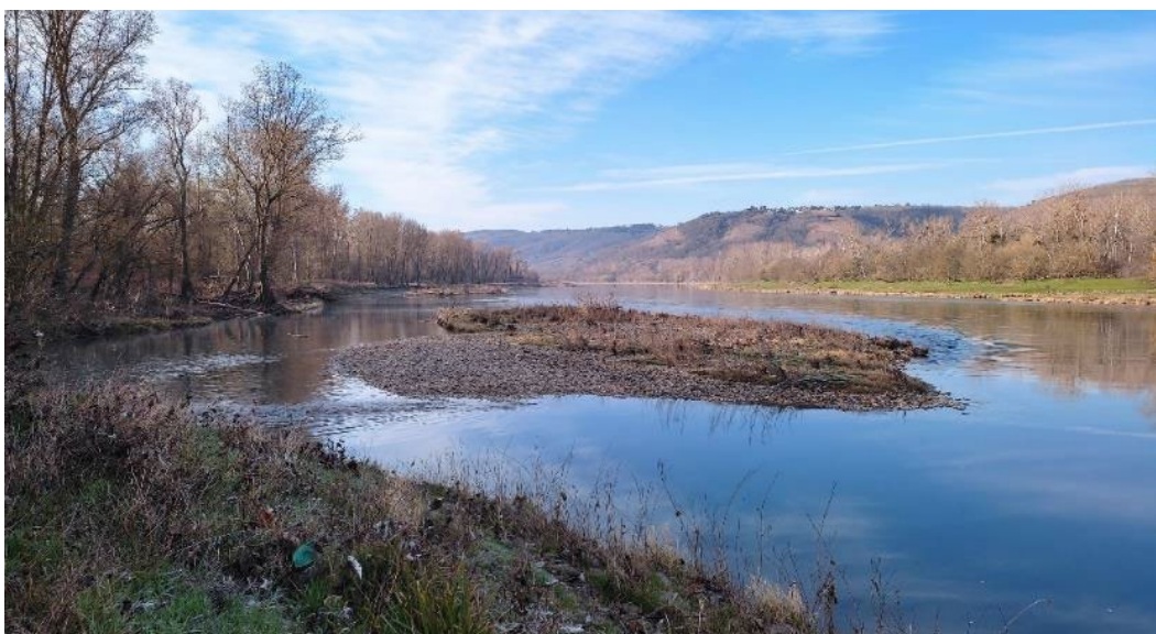
Figure 47. Bras secondaire réhabilité dans la partie amont du secteur de démantèlement des casiers 5 ans après travaux (vue vers l'aval, 1/03/2022)
