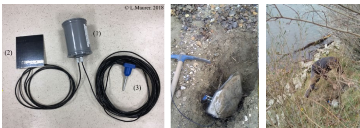
Figure 55. Le canal de Miribel : détails des composants de la station géophone (à gauche), son installation en rive gauche (au centre) et en rive droite (à droite) (Cassel et al., 2022)
