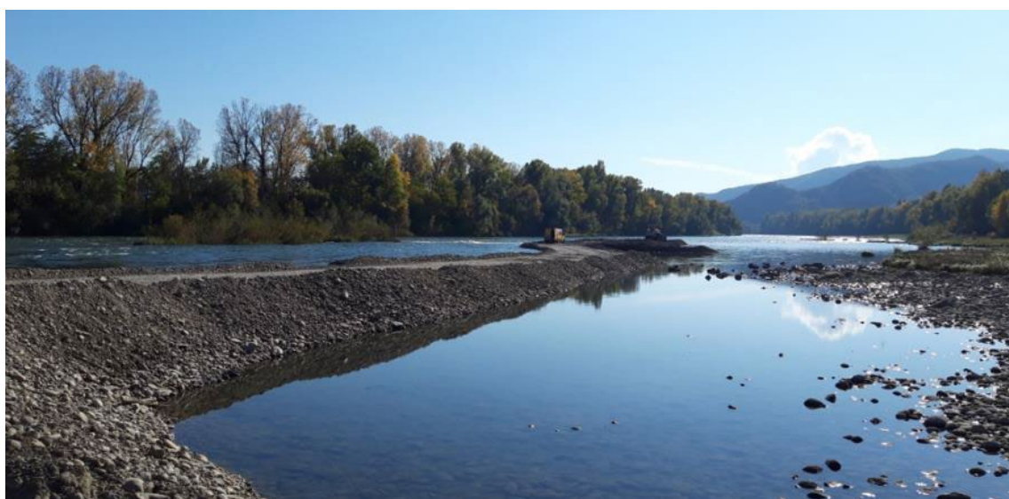
Figure 56. Le Vieux Rhône de Baix-le-Logis-Neuf : travaux de réinjection sédimentaire sur le site amont en novembre 2021 (photo de Nedjma Salhi, CNR)
