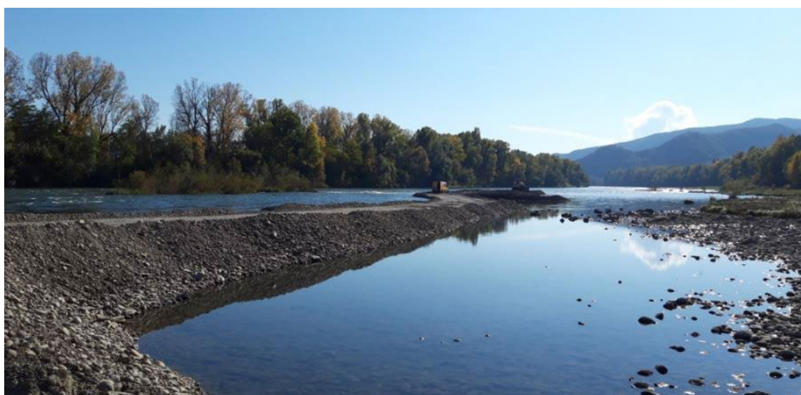
Figure 56. Le Vieux Rhône de Baix-le-Logis-Neuf : travaux de réinjection sédimentaire sur le site amont en novembre 2021 (photo de Nedjma Salhi, CNR)
