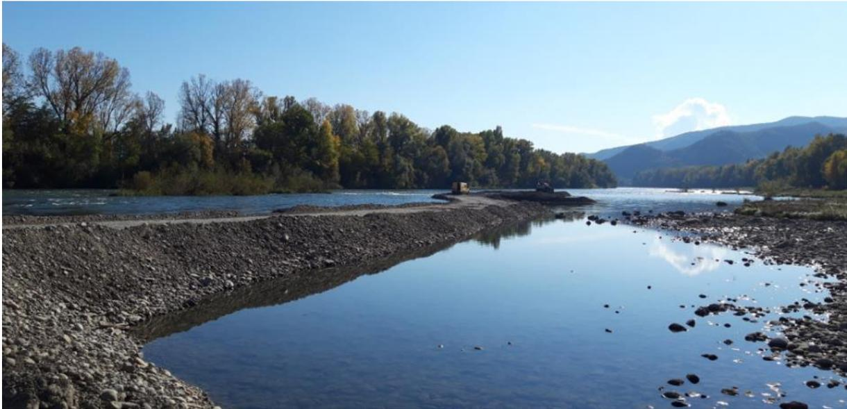
**Figure 15.** Le Vieux Rhône à Baix : travaux de recharge sédimentaire sur le site amont en novembre 2021 (photo de Nedjma Salhi, CNR)
