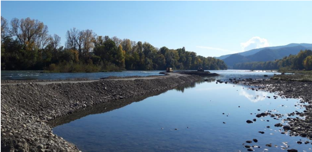
Figure 15. Le Vieux Rhône à Baix : travaux de recharge sédimentaire sur le site amont en novembre 2021 (photo de Nedjma Salhi, CNR)
