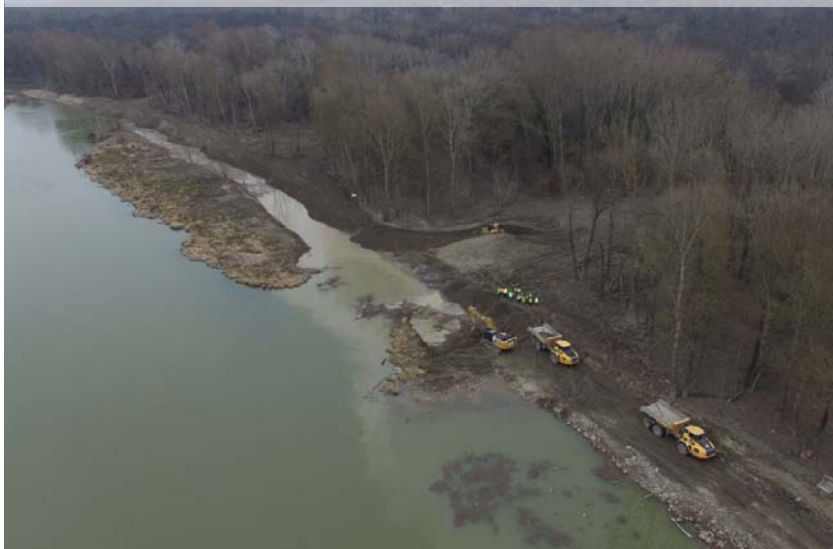
Démantèlement des d'ouvrages Girardon
