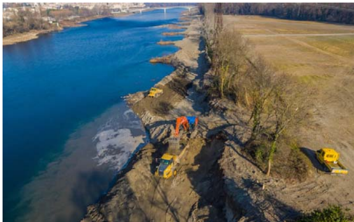
Démantèlement d'ouvrages Girardon sur 1 km de, Ile Dions, Février 2017
