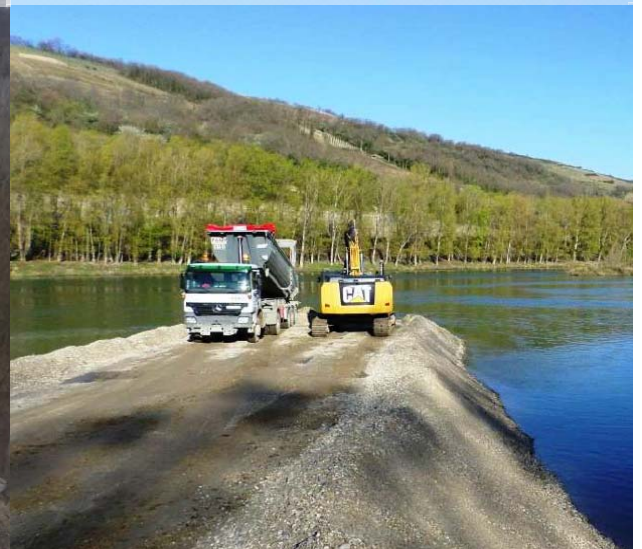
Recharge de 5 800 m3 de graviers dans Rhône
