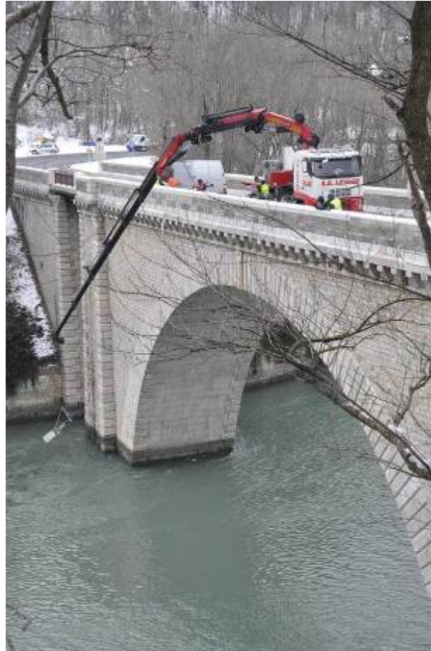
Figure 20 : Déploiement de préleveur à l'aide d'un camion grue à partir du pont Carnot
