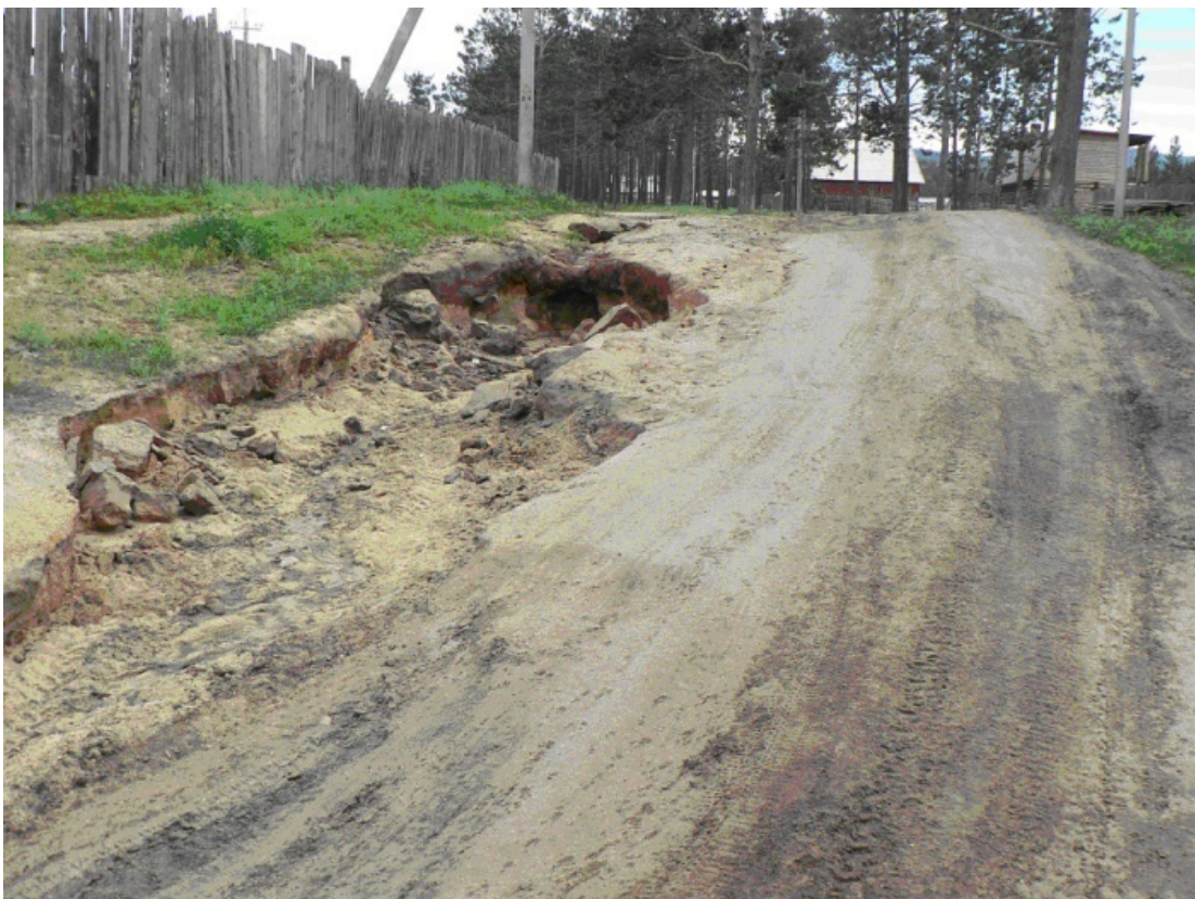
Photo 42 La transformation d'une ornière en ravine sous l'action des orages d'été Cliché L. Touchart, août 2008
