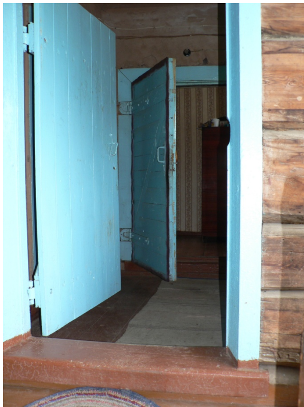
Photo 12 Succession de deux portes à seuil séparées par un couloir servant de sas Cliché L. Touchart, août 2008
