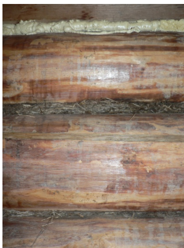
Photo 10 Le calfeutrage des interstices entre les pièces de bois
