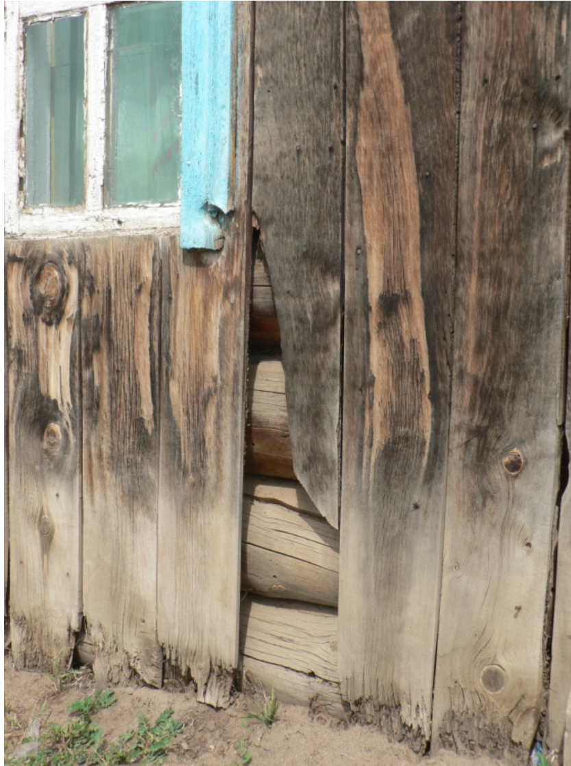
Photo 9 La couverture de la cage de l'izba, le doublement de la paroi externe Cliché L. Touchart, août 2010
