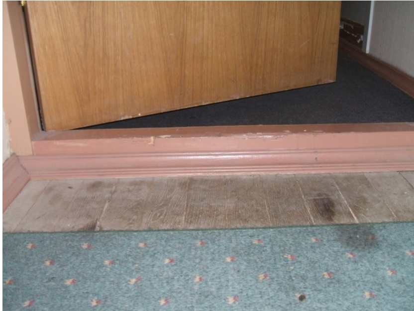
Photo 30 Le seuil surélevé d'une porte à l'intérieur d'un appartement de ville, barrière à l'air froid Cliché L. Touchart, août 2007
