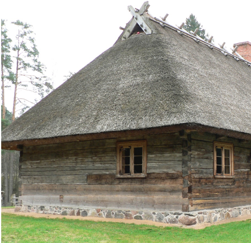
Photo 8 La maison rurale de l'ouest, une fondation en pierre isolant du sol froid et humide Cliché L. Touchart, avril 2008
