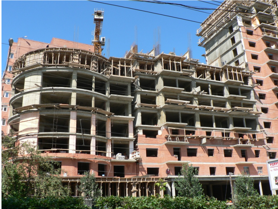
Photo 24 La construction des immeubles et le rôle de la brique comme isolant Cliché L. Touchart, août 2010
