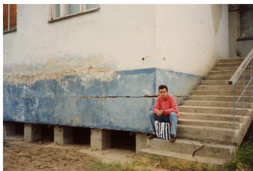
Photo 27 Les villes du Grand Nord, une construction des immeubles sur pilotis Cliché H. Touchart, juillet 1991
