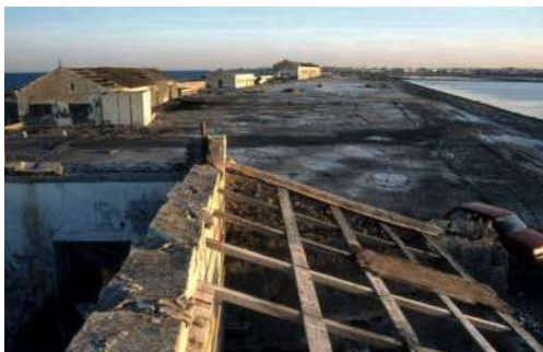
10 Instalaciones salineras en 1992 tras cinco años de abandono y desmantelamiento.
