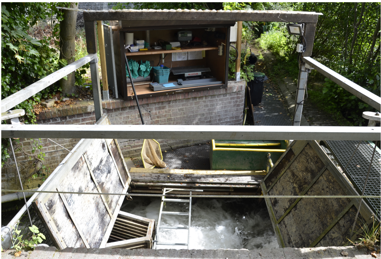
Figure III.27. Vue du piège de montaison d’Eu pour les salmonidés en fonctionnement.
