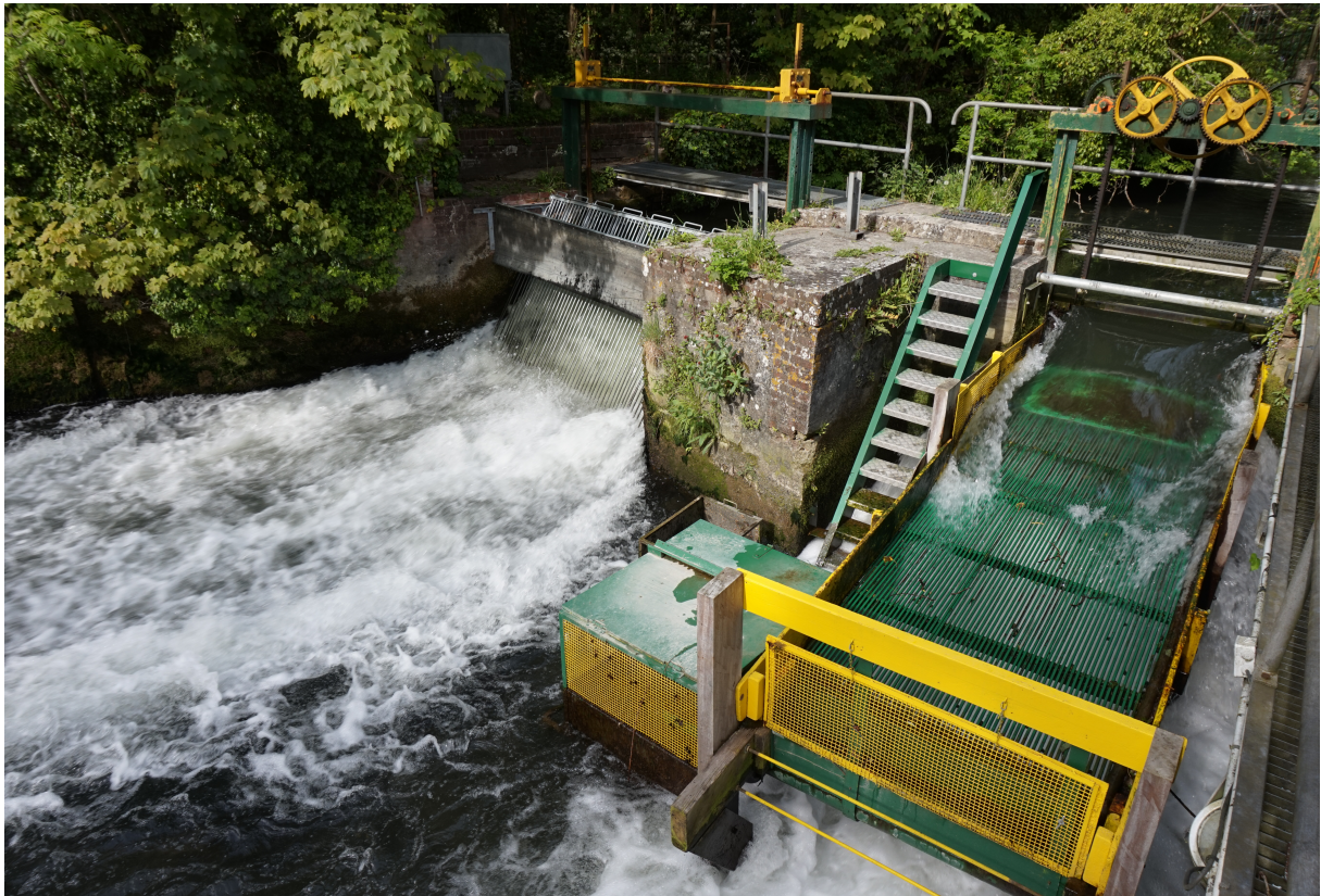
Figure V.3. Vue du dispositif de piégeage de dévalaison d'Eu en fonctionnement (EU_PGD).
