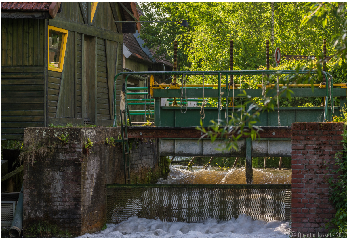
Figure III.3. Vue aval du piège du Lieu-Dieu (Beauchamps - 80) en fonctionnement.
