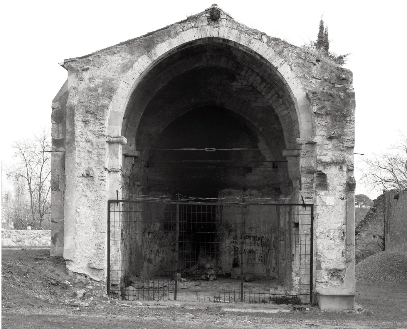
Fig. 5 - Vue de l'église romane de Saint-Jean d'Aureilhan depuis l'ouest (O. Ginouvez Inrap).
