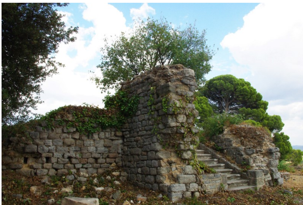
Clermont-l'Hérault (Hérault), château, vue, depuis le nord-ouest, de la tour d'entrée située dans l'angle sud-ouest de la première enceinte
