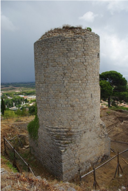
Clermont-l'Hérault (Hérault), château, vue, depuis le nord-ouest, du donjon circulaire sur sa souche carrée
