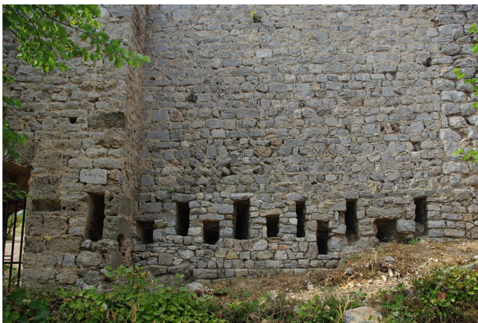
Clermont-l'Hérault (Hérault), château, depuis l'intérieur, les archères ouvertes dans la courtine entre les tours Cardinal et Marie
