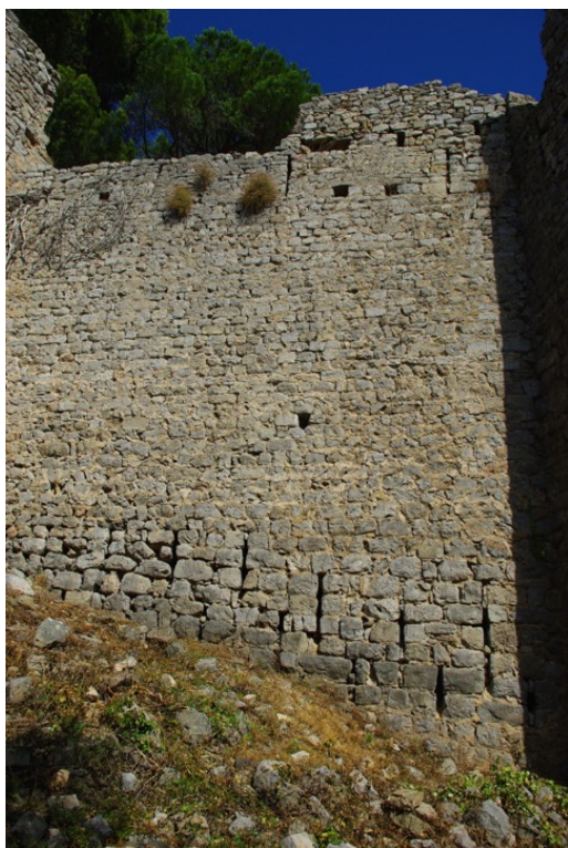
Clermont-l'Hérault (Hérault), château, depuis l'extérieur, les archères basses de la courtine tendue entre les tours Béranget et Tristan
