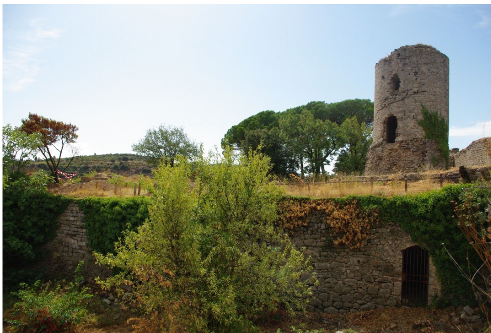
Clermont-l'Hérault (Hérault), château, vue de la terrasse haute depuis l'est. Au second plan, la grande tour circulaire édiflée sur une souche carrée plus ancienne. Au premier plan, la porte récente ouverte dans la salle de soubassement dite de la Légende
