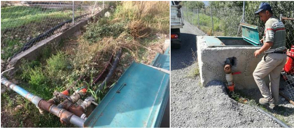
Figure 4 : Photos de vannes individuelles installées sur les hydrants du projet de gölet
